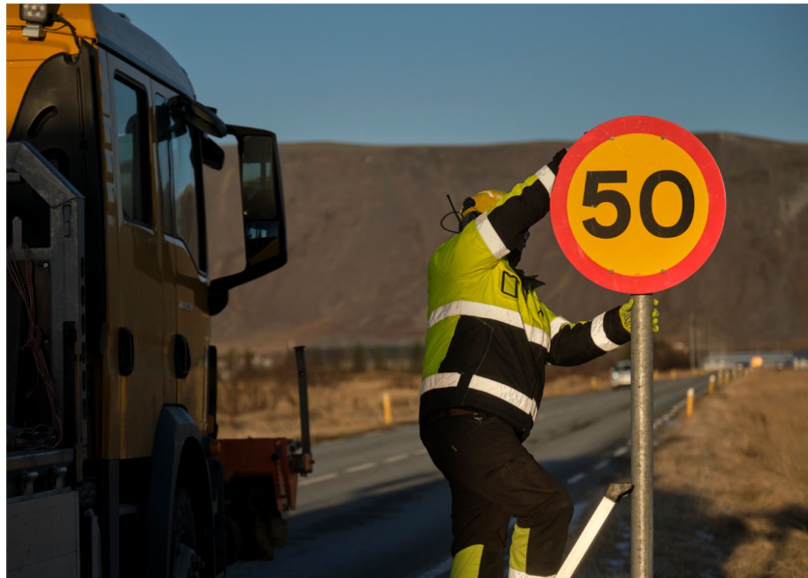
Starfsmaður Vegagerðarinnar setur upp hraðaskilti á Suðurlandsvegi. Ný umferðarmerkjareglugerð var nýverið gefin út. Mynd: Anton Brink
