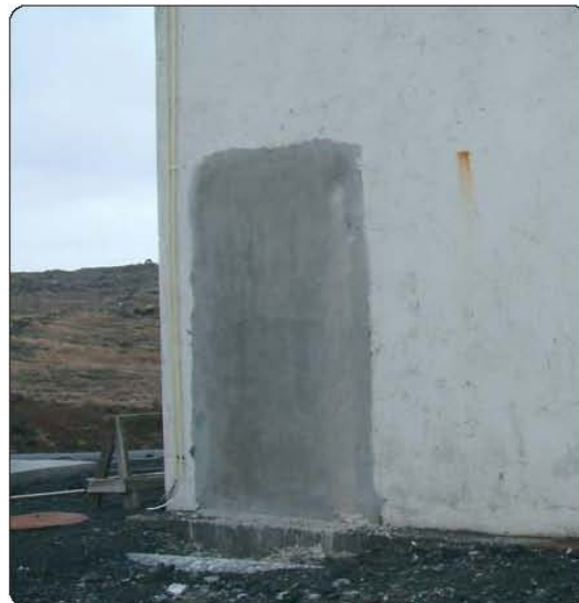
Þessi mynd er tekin um hálfum mánuði eftir meðhöndlun. XYPEX-efnið hefur náð að þétta og ekki er minnsti vottur um raka.
