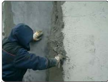
XYPEX Patch & plug-þéttiefni er þrýst inn í raufina.
