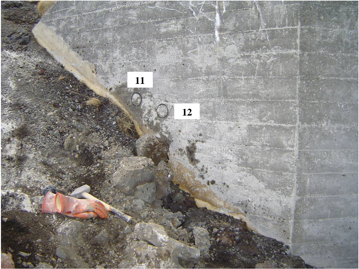
Mynd 2. Staðsetning borkjarna 11 og 12 í vestari landstöpli.
