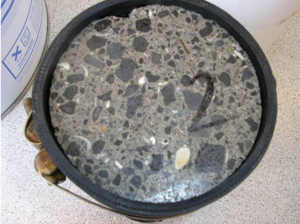
Mynd 16. Sýni 2 eftir um 3 sólarhringa var sýnið aðeins yfirborðsblautt. Sprungan liggur upp-niður efir sýninu miðju, en sprungan sést ekki vel vegna þess að myndi er ekki í fókus.
