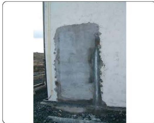
Hér má greinilega sjá leka, hvíta rákin hægra megin á myndinni er salt.
