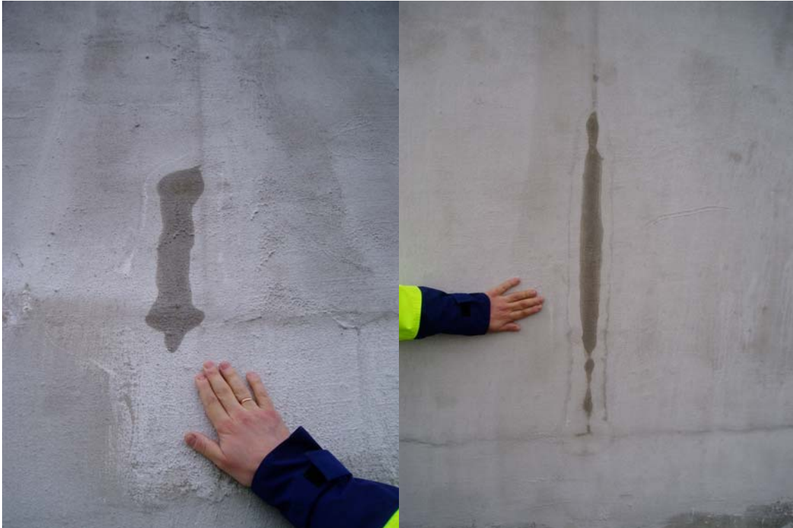
Mynd 27. Leki í ferskvatnstanki í Reyðarfirði, myndin var tekin 31-3-2005
