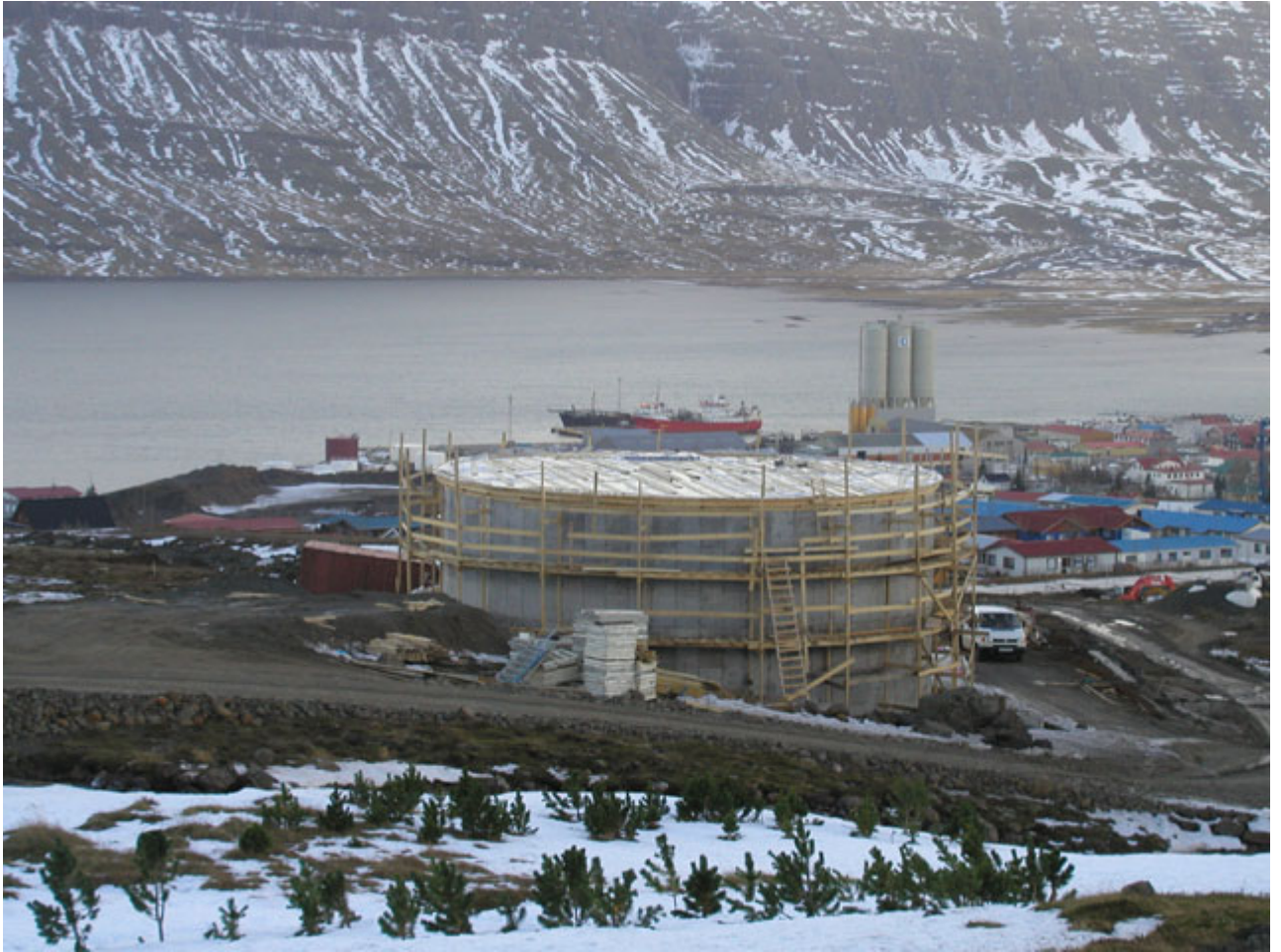
Mynd 25. Ferskvatnstankur á Reyðarfirði í byggingu um vorið 2004. Steypan er með 1,5 % XYPEX admix
