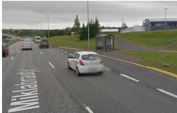
MYND 20 Strætóstöð við Gerði.
