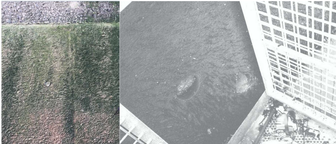
Mynd 2. Stöpull 11. Myndirnar voru tekin í sýnatökuferð 28.08.2019, myndin niðri til vinstri var þó tekin í skoðunarferð 9.10.2017. Myndirnar sýnir nokkra yfirborðslögnun í fletinum sem snýr upp í straum árinna. Steypa í langhliðum stöpsulsins er hins vegar með tiltölulega litla yfirborðslögnun, en þó aðeins meiri en í stöpli 5. Sýni voru tekið af langhliðinni, neðarlega í stórstraumsfjörubelti, sjá neðri myndina (gæði myndarinnar eru ekki góð).
