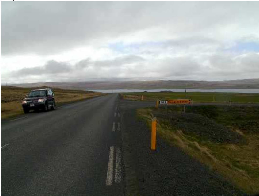
Mynd 30. Norðurlandsvegur við afleggjara að Heggstaðanesvegi.
