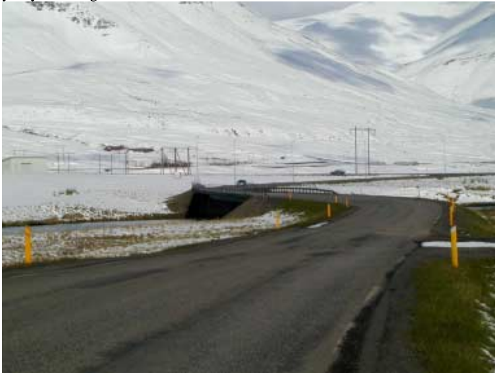
Mynd 57. Ólafsfjarðarvegur við Svarfaðardalsá, horft til austurs á brúna.
