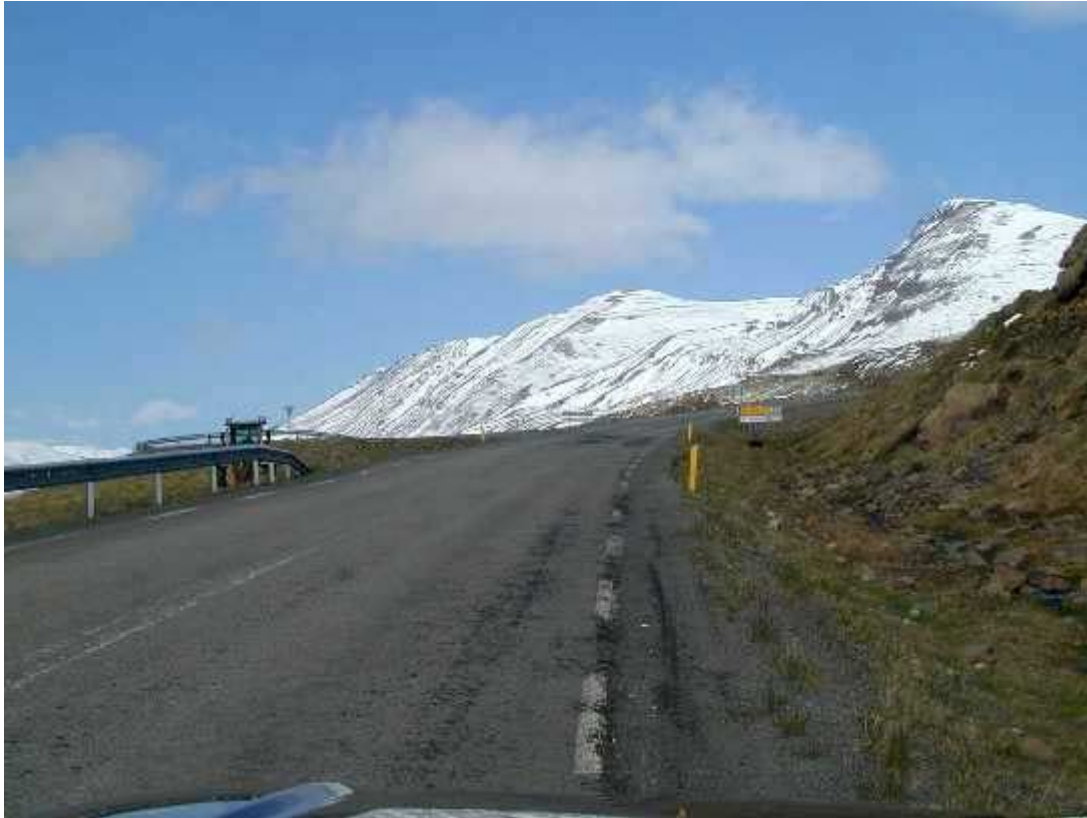
Mynd 44. Vegamót Grenivíkurvegar og Norðurlandsvegur, horft norður eftir Norðurlandsvegi.
