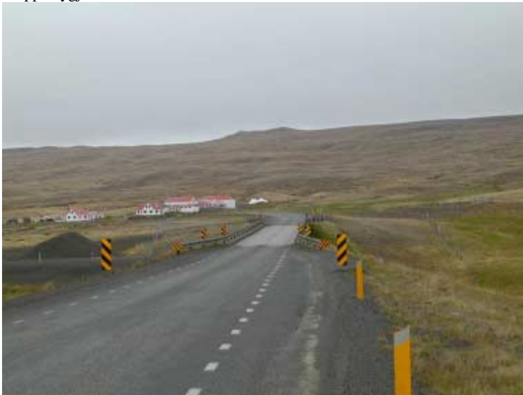
Mynd 13. Norðurlandsvegur við Síká, horft til norðurs.
