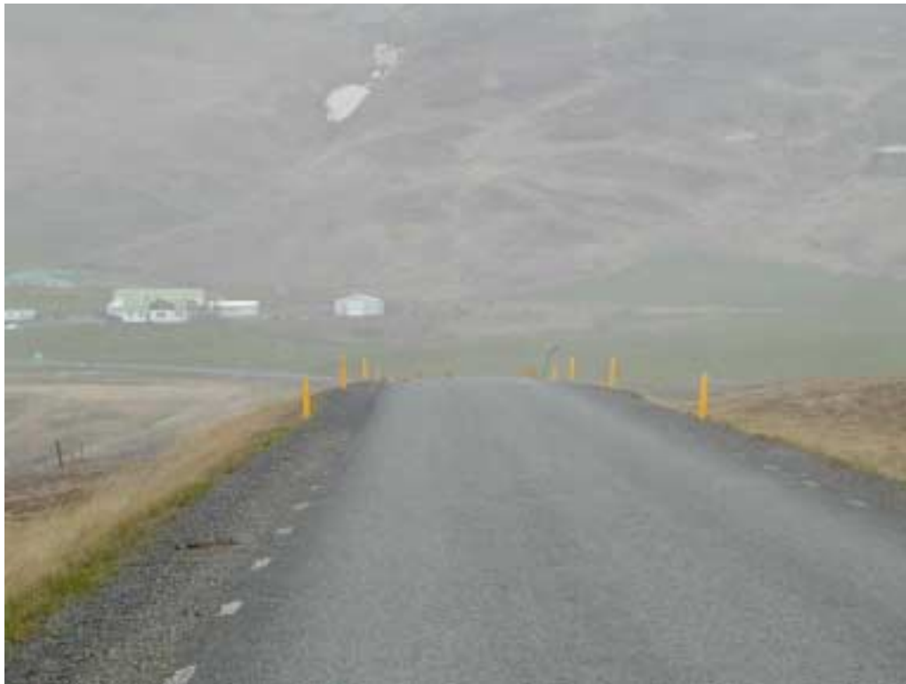
Mynd 24. Skagastrandarvegur við Laxá, horft norður.
