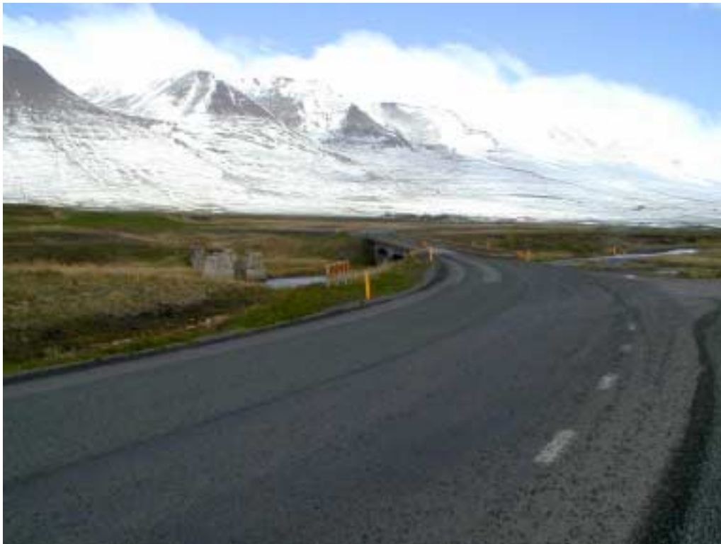
Mynd 38. Vegamót Ólafsfjarðarvegar og Dagverðararvegar, horft norður eftir Ólafsfjarðarvegi.
