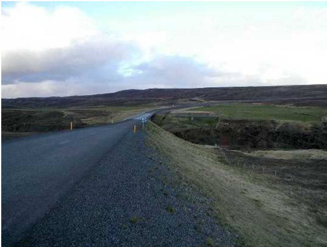
Mynd 10. Nýr vegur yfir Jökulsá á Dal. Lengja þarf vegrið á annars ágætri tvíbreiðri brú.
