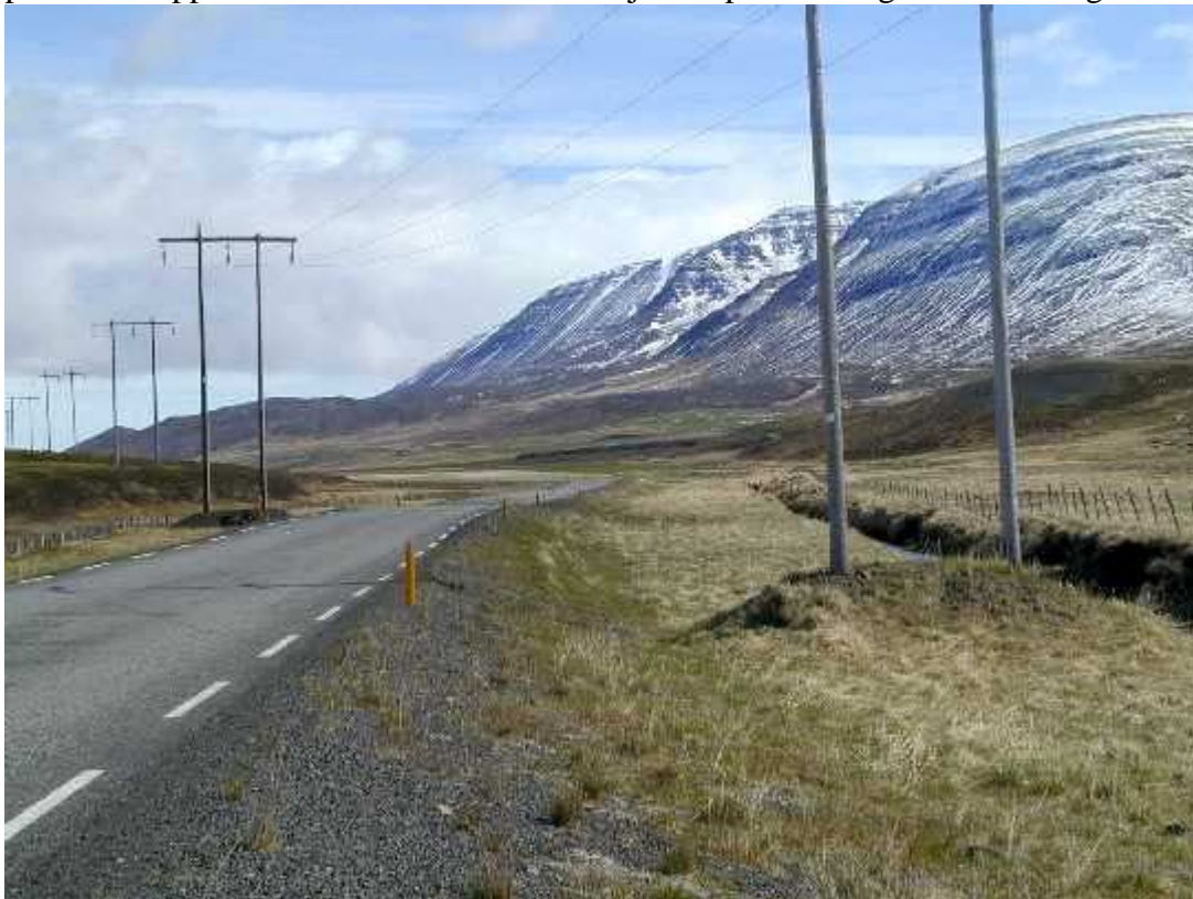
Mynd 46. Norðurlandavegur við Birningsstaði, horft til suðurs.
