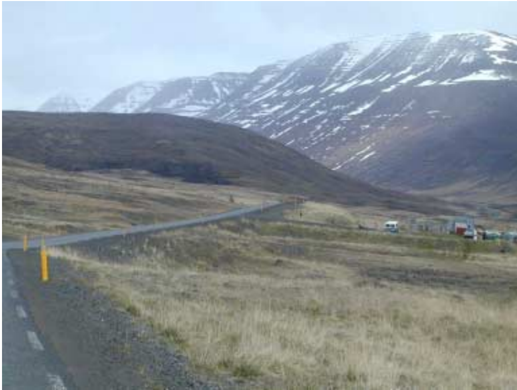
Mynd 35. Norðurlandsvegur við Fremra Kot, horft til austurs.
