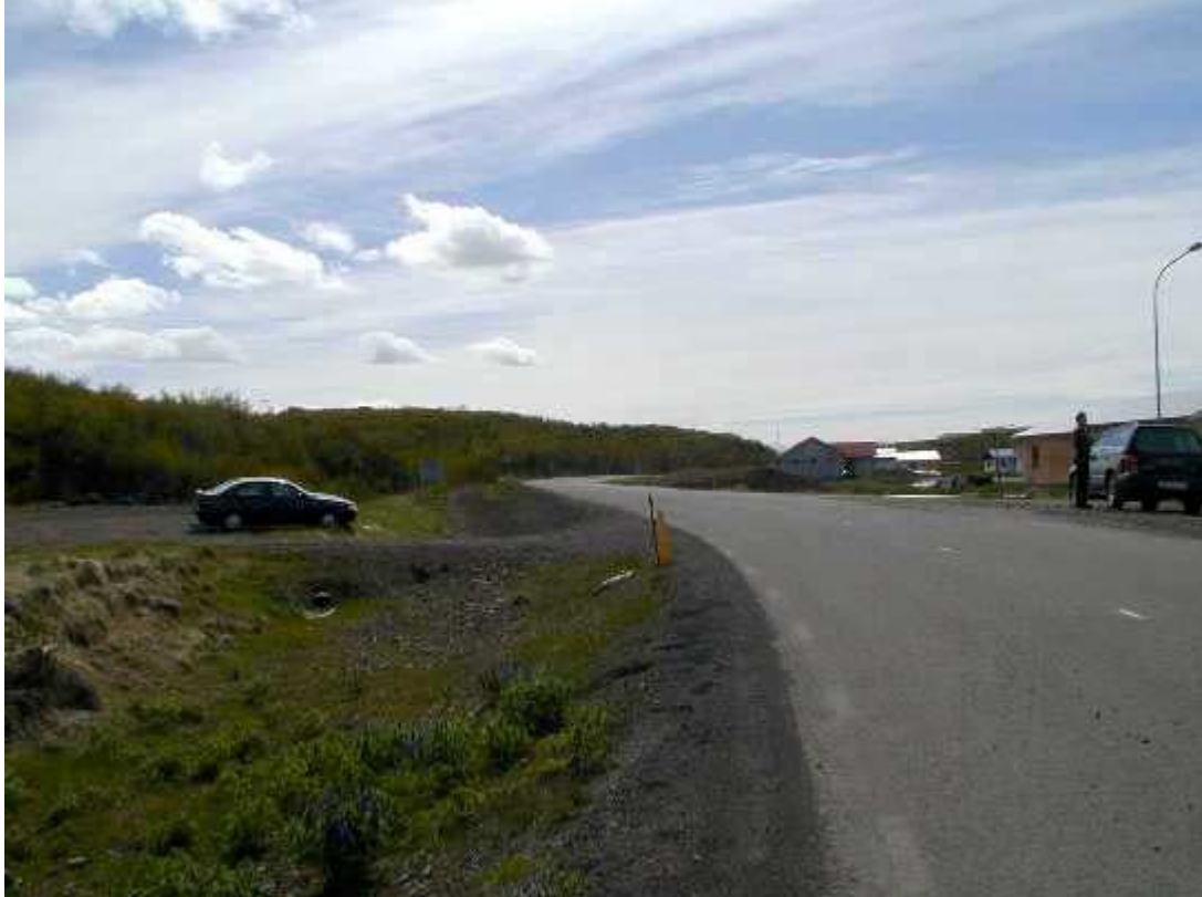
Mynd 76. Tengingar við Seyðisfjarðarveg við Eyvindará.
