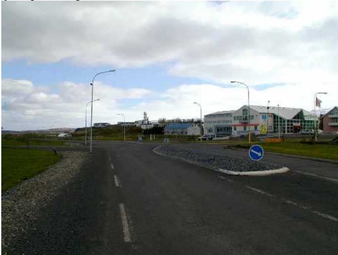
Mynd 63. Vegamót Austurlandsvegur við Egilsstaði
