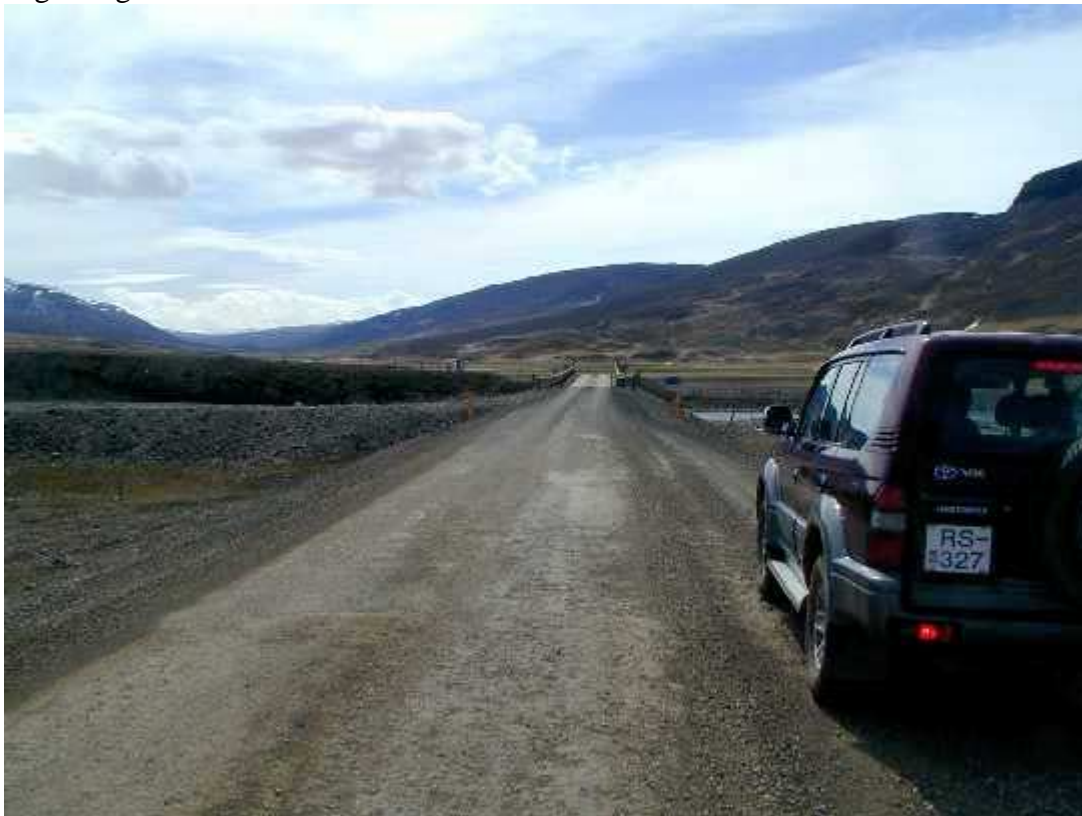
Mynd 67. Einbreið brú við Jóku, sjónlengd skert við brúna.
