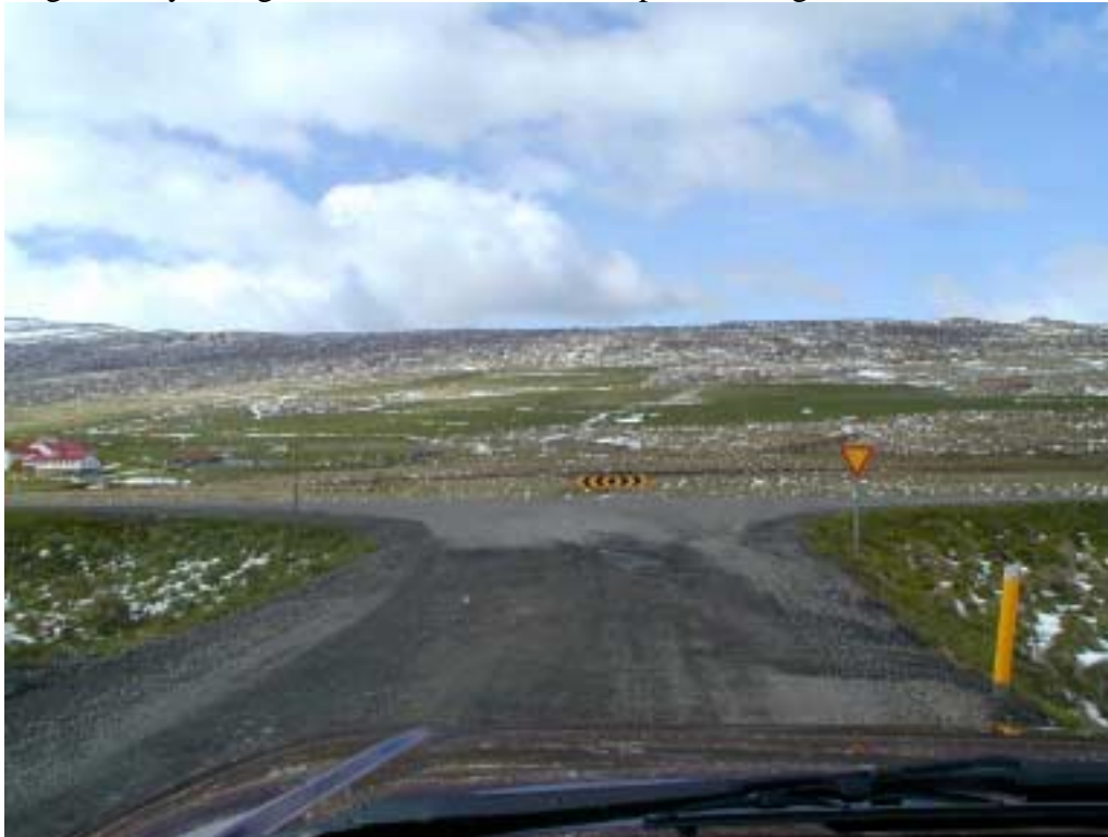
Mynd 41. Vegamót Norðurlandsvegur og Dagverðareyrarvegur, horft frá Dagverðareyrarvegi.
