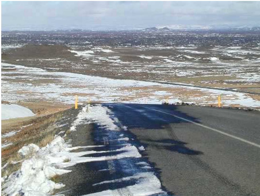
Mynd 52. Norðurlandsvegur í Námaskarði, horft austur eftir Norðurlandsvegi.
