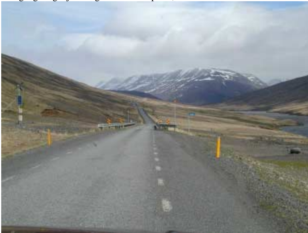
Mynd 34. Norðurlandsvegur við Kotá, horft til austurs.
