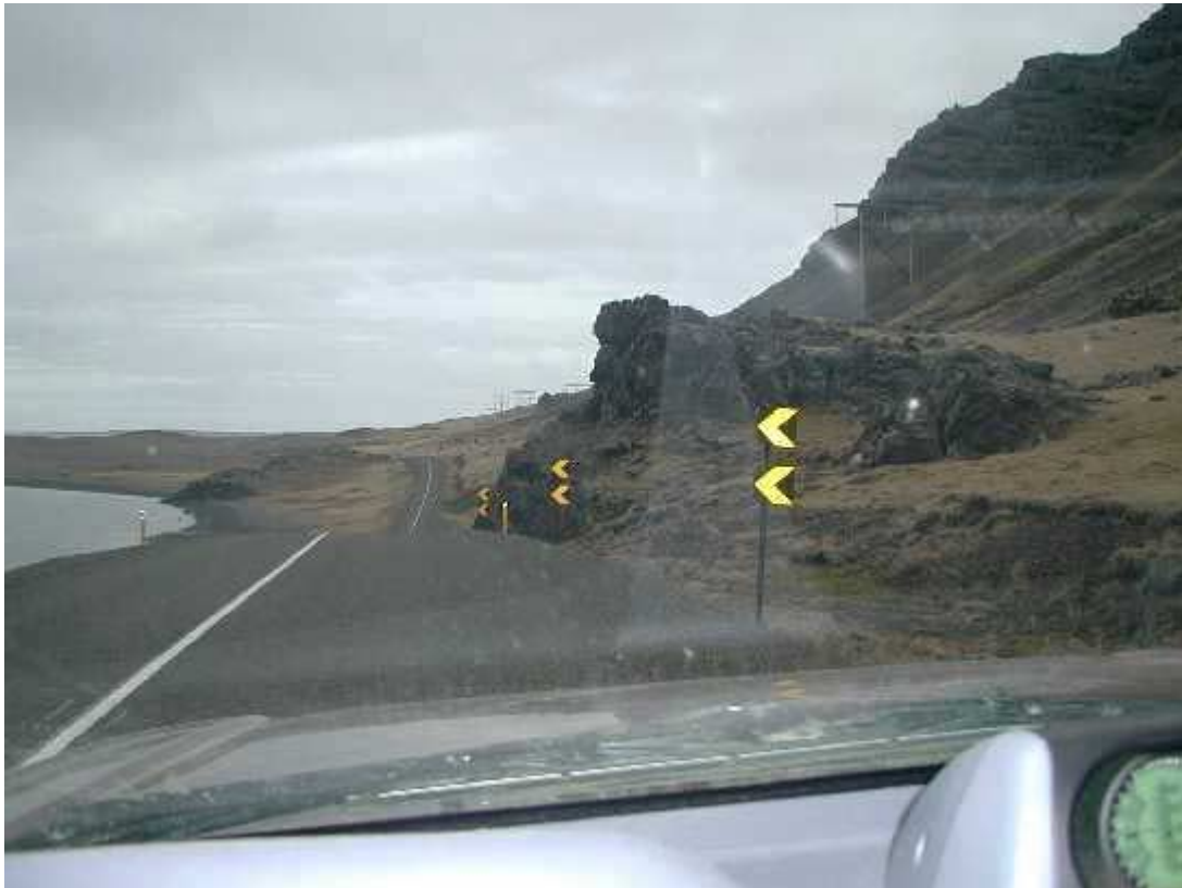
Mynd 4. Athyglisverð lausn á Austurlandsvegi í Hamarsfirði. Tvöfaldar örvar eru greinilegar.
