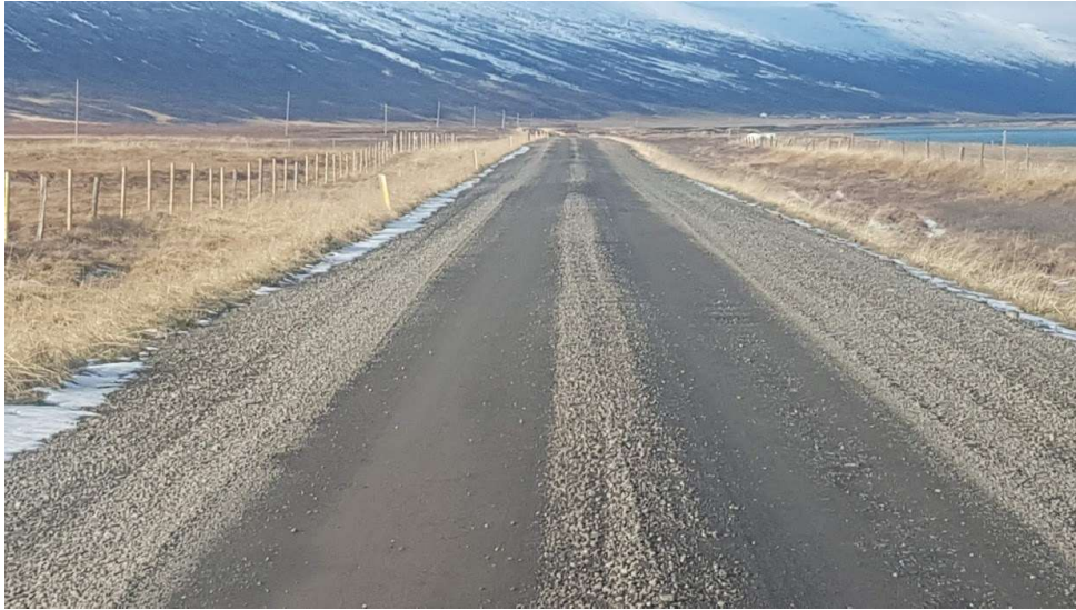
Mynd 42. Nýtt salt og óblandað Sexhólagilsefni. Rétt við Litlu Velli, undirkafli Litlu Velli-stöð 4760, 9. október 2018.
