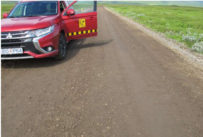
Mynd 8. Rykbundið með magnesíum klóríð. Hringvegur-Öxará, 3. júlí 2018.
