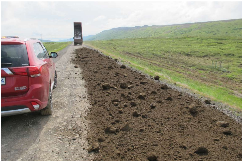
Mynd 16. Efni dreift á veginn úr Arnstapanámu.
