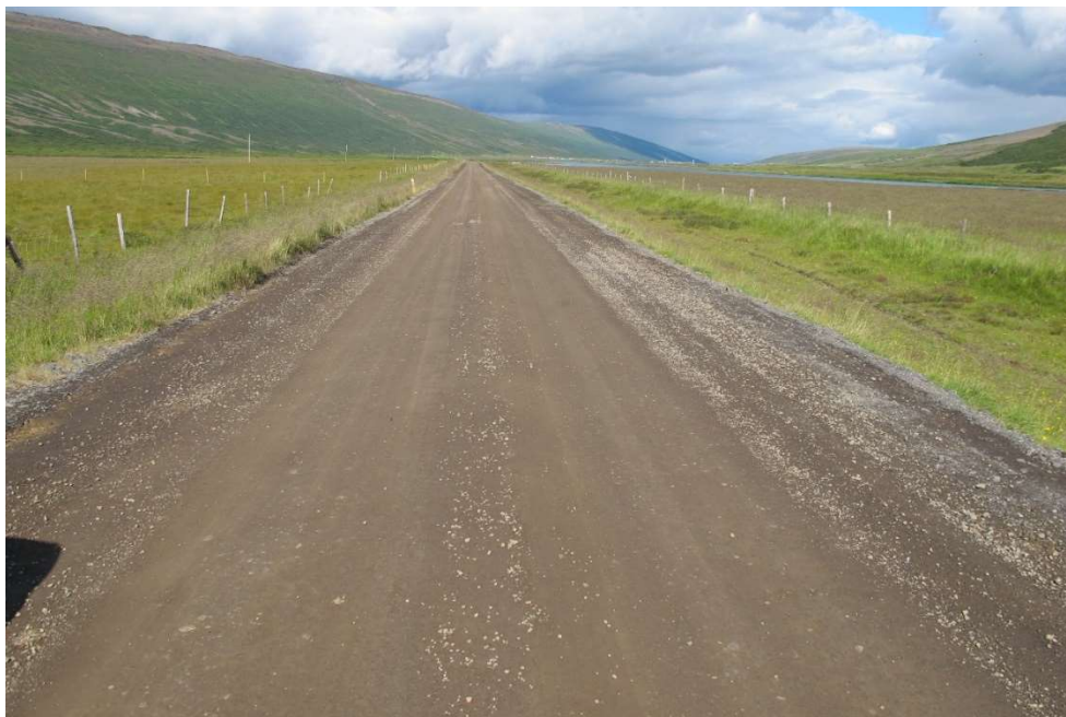
Mynd 41. Nýtt salt og óblandað Sexhólagilsefni. Rétt við Litlu Velli, undirkafli Litlu Velli-stöð 4760, 25. júlí 2018.
