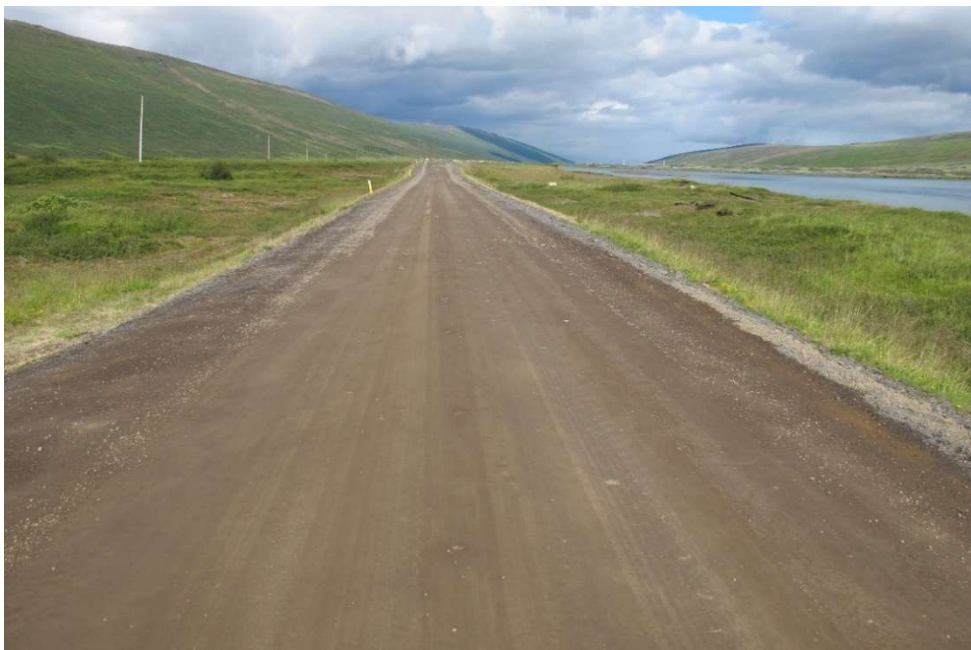
Mynd 36. Nýtt salt og blandað Sexhólagilsefni. Við Sexhólagil, undirkafli stöð 1000-Sexhólagil, 25. júlí 2018.
