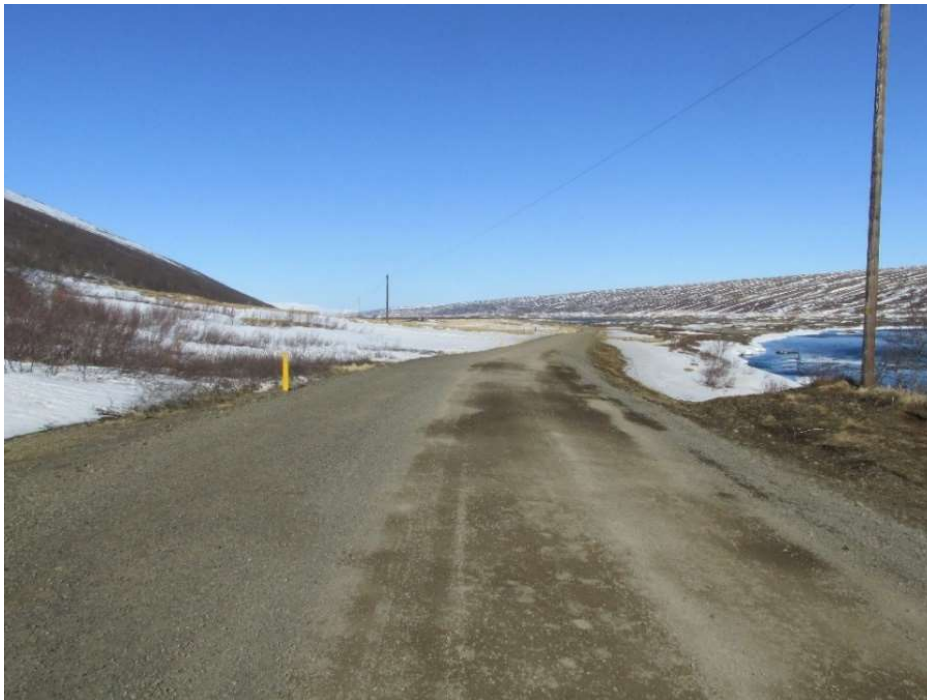
Mynd 23. Nýtt salt á kaflann Sandhaugar-Hlíðskógaklif. Þarna eru nokkrir mánuðir frá því að malarefni var ekið yfir kaflann. 12. apríl 2019.
