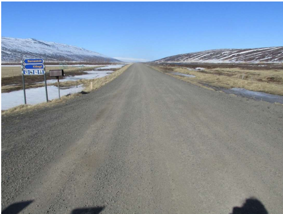
Mynd 27. Gamalt salt og blandað Sexhólagilsefni. Við Kiðagil, 8. apríl 2019, undirkafli Hlíðskógaklif-Stóruvallarbrú.
