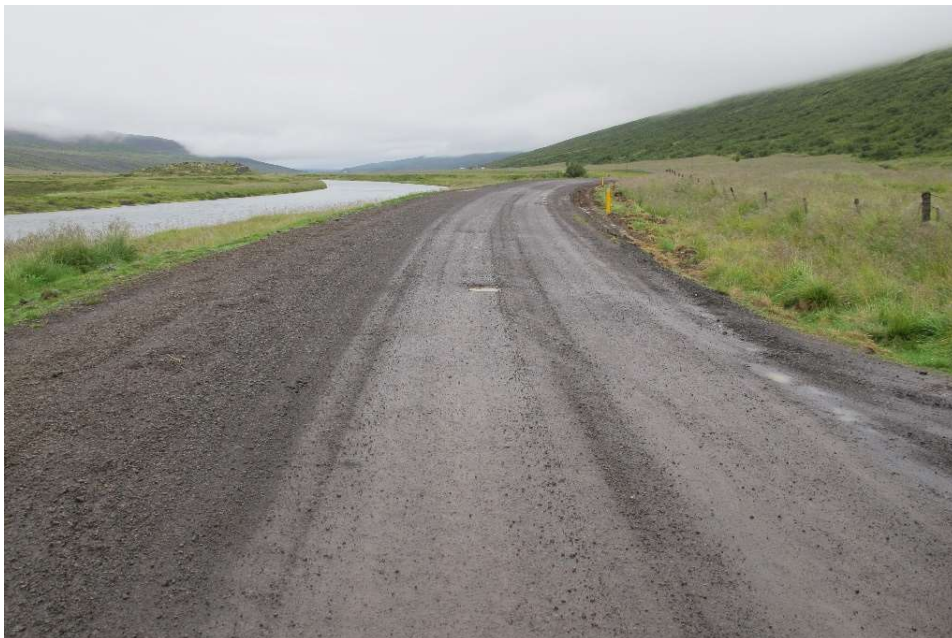
Mynd 32. Nýtt salt og blandað Sexhólagilsefni. Við Hlíðskóga, undirkafli Stöð 1000-Sexhólagil, 9. ágúst 2018.
