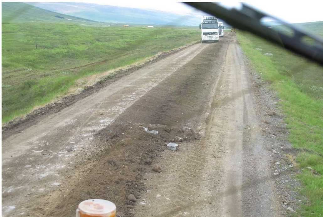
Mynd 18. Horft út um afturgluggan á traktorsgröfunni sem dró á eftir sér steinbrjótinn. Hér sést hversu fíngert efnið er sem notað var í veginn.
