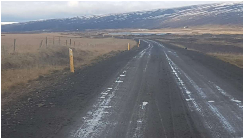
Mynd 22. Nýtt salt á kaflann Sandhaugar-Hlíðskógaklif. Vegurinn mjög eðjukennur og sleipur. 9. október 2018.
