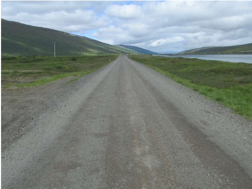
Mynd 39. Nýtt salt og blandað Sexhólagilsefni. Við Sexhólagil, undirkafli stöð 1000-Sexhólagil, 1. júlí 2019.
