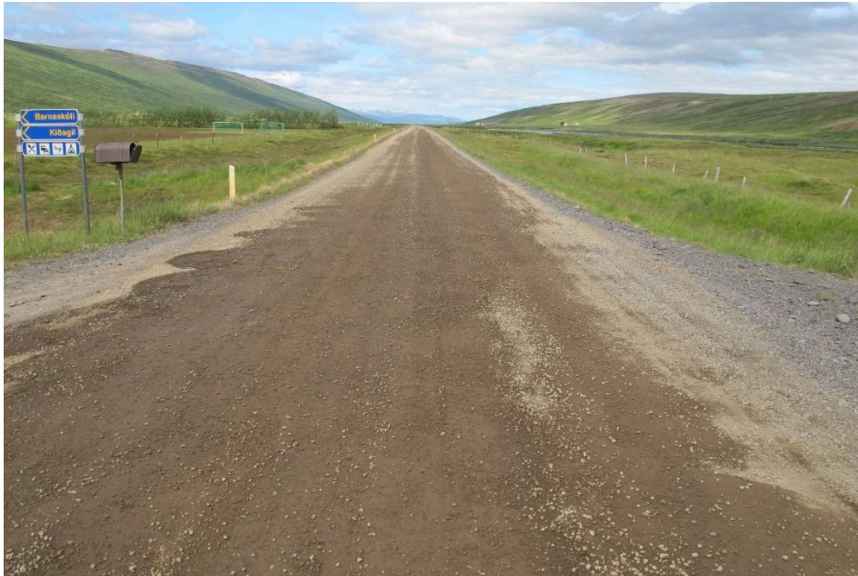
Mynd 24. Gamalt salt og blandað Sexhólagilsefni. Við Kíðagil 12. júlí 2018, undirkafli Hlíðskógaklif-Stóruvallarbrú.
