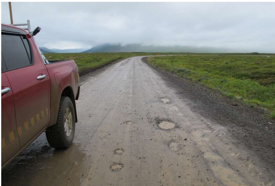
Mynd 11. Rykbundið með magnesíum klóríð. Hringvegur-Öxará, 9. ágúst 2018.
