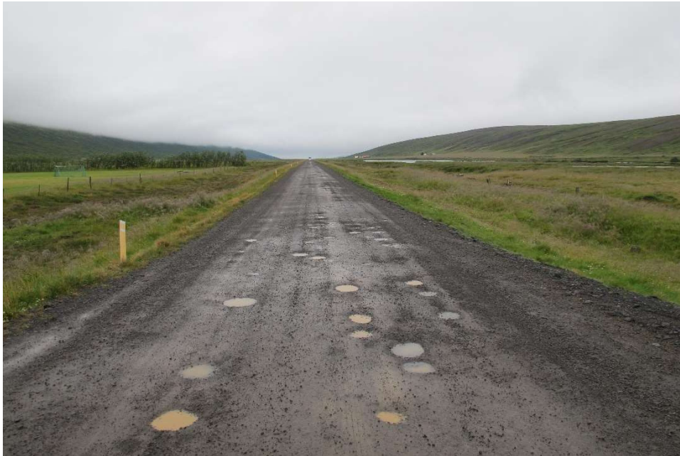
Mynd 26. Gamalt salt og blandað Sexhólagilsefni. Við Kiðagil, 9. ágúst 2018, undirkafli Hlíðskógaklif-Stóruvallarbrú.
