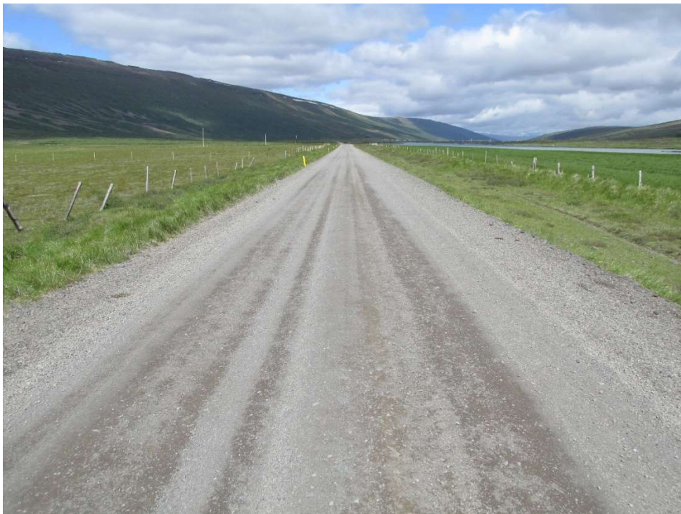
Mynd 43. Nýtt salt og óblandað Sexhólagilsefni. Rétt við Litlu Velli, undirkafli Litlu Velli-stöð 4760, 1. júlí 2019.
