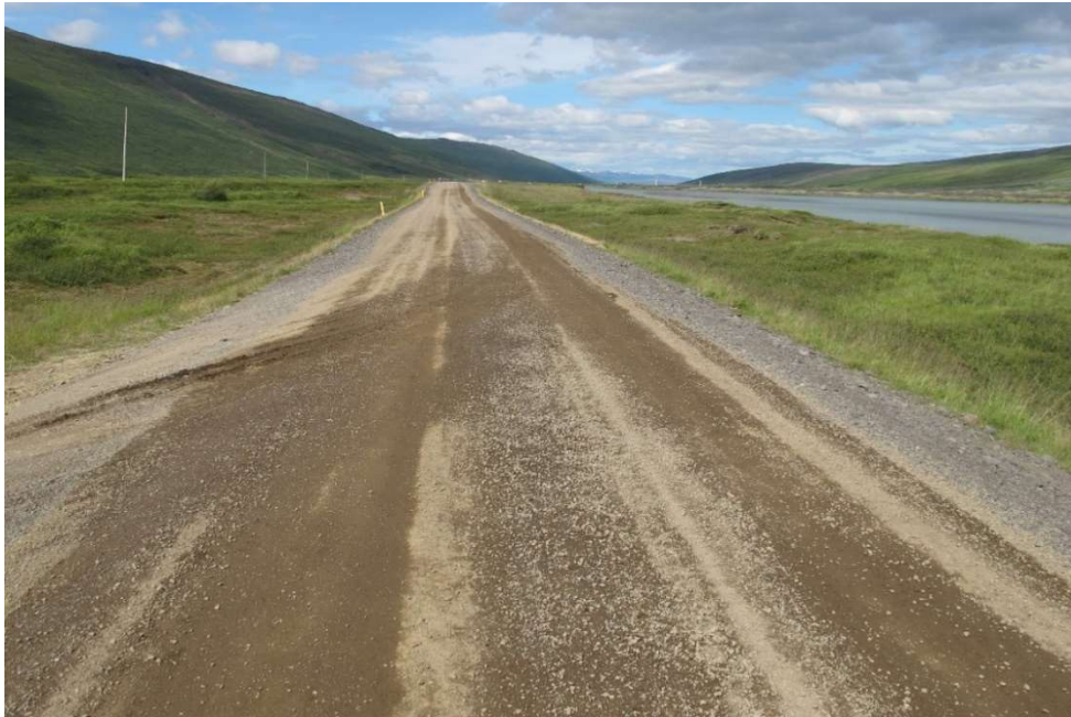
Mynd 35. Nýtt salt og blandað Sexhólagilsefni. Við Sexhólagil, undirkafli stöð 1000-Sexhólagil, 12. júlí 2018.
