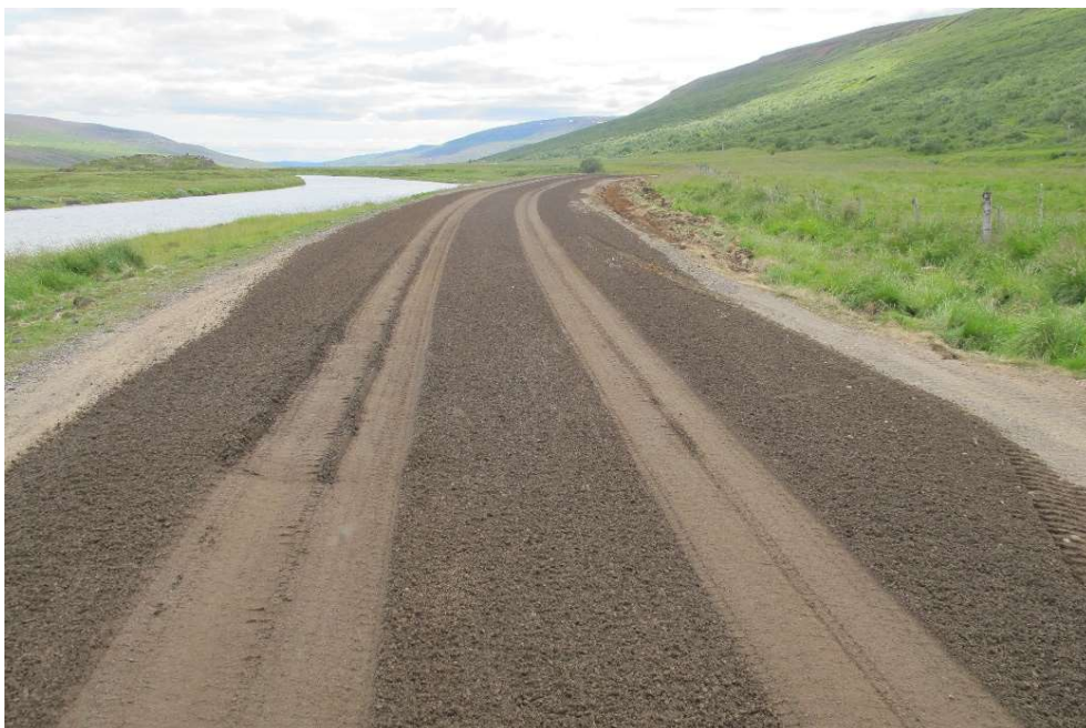
Mynd 30. Nýtt salt og blandað Sexhólagilsefni. Við Hlíðskóga, undirkafli Stöð 1000-Sexhólagil, 12. júlí 2018.
