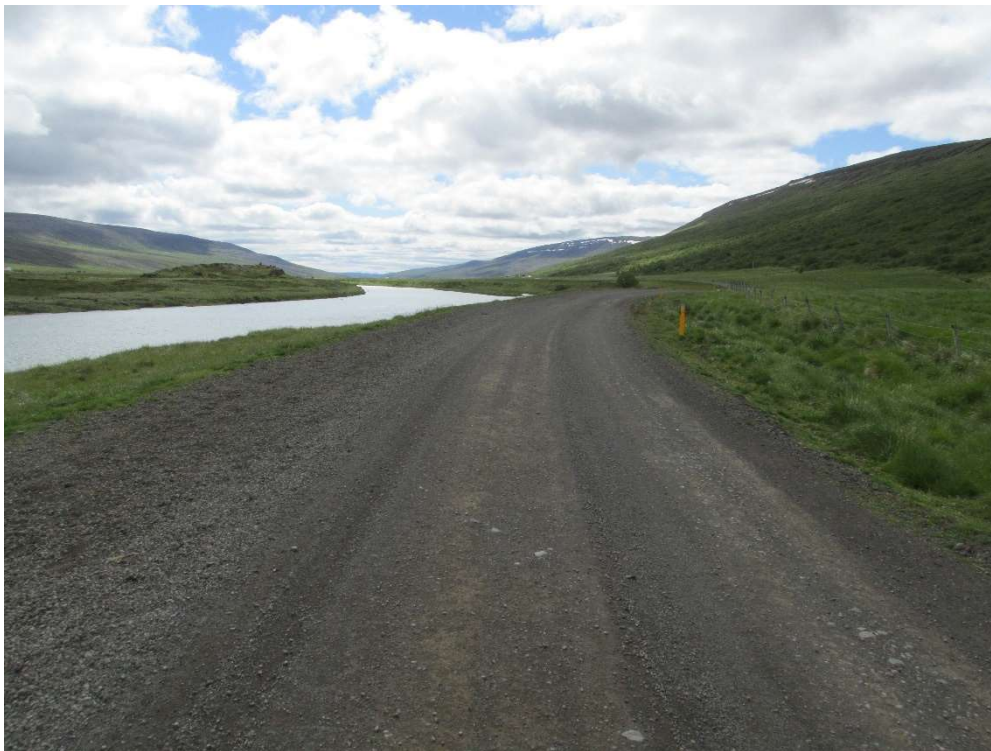
Mynd 34. Nýtt salt og blandað Sexhólagilsefni. Við Hlíðskóga, undirkafli Stöð 1000-Sexhólagil, 1. júlí 2019.
