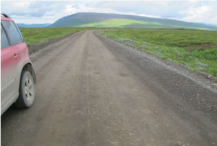
Mynd 10. Rykbundið með magnesíum klóríð. Hringvegur-Öxará, 25. júlí 2018.
