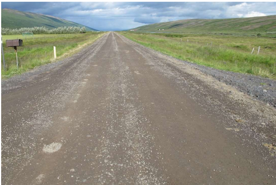
Mynd 25. Gamalt salt og blandað Sexhólagilsefni. Við Kíðagil, 25. júlí 2018, undirkafli Hlíðskógaklif-Stóruvallarbrú.
