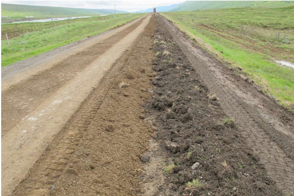
Mynd 15. Uppheflað rastarefni hægra megin á myndinni og vinstra megin er efni úr Arnstapanámu.
