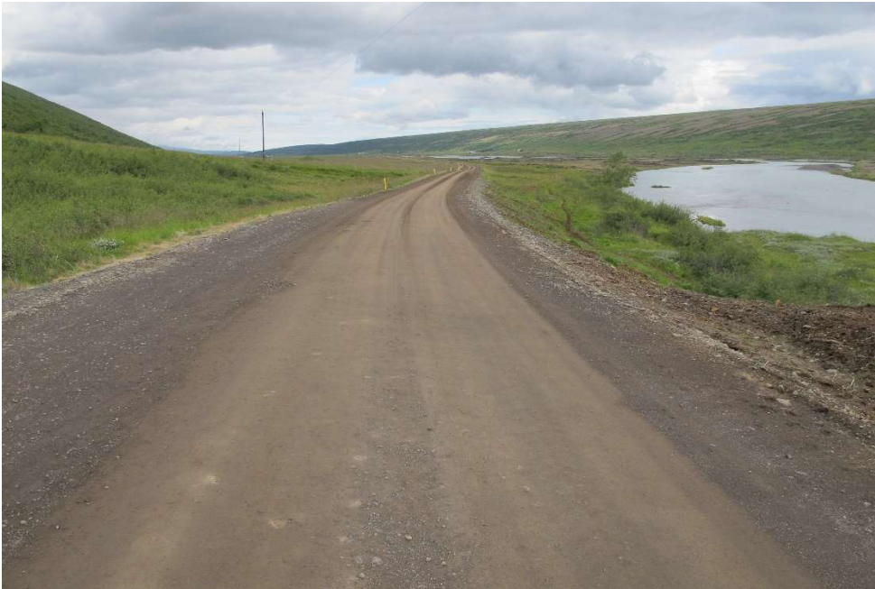
Mynd 21 . Nýtt salt á kaflann Sandhaugar-Hlíðskógaklif. 25 júlí 2018.
