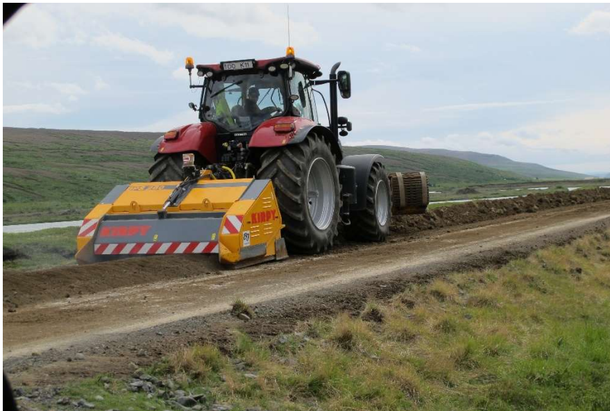
Mynd 12. Steinbrjóturinn og dráttavél á Bárðardalsvegi vestri.
