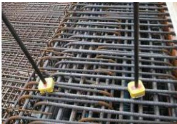
Abb. II.13: Injektionsanschlüsse mit Aussparungskörpern.
