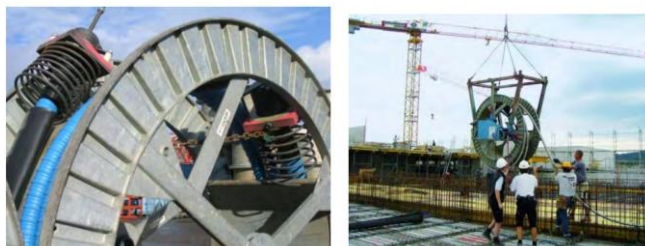
Mynd 23 - úr STA – 01/010 , rör sett á rúllu í verksmiðju og rúllað út á verkstað
