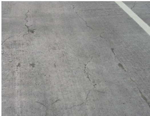
Mynd 10 – yfirborð brúar
