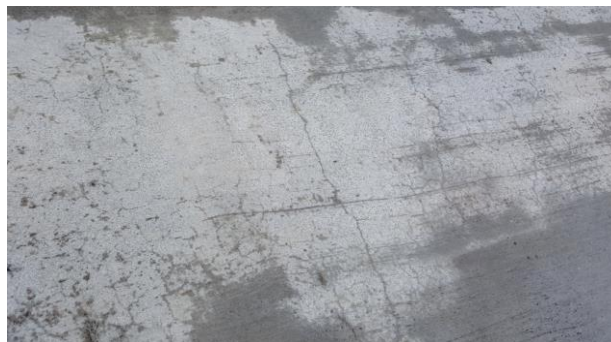
Mynd 11 – yfirborð brúar
