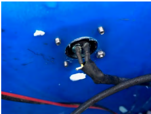
Mynd 18. Ekki dugði að skipta um skynjara og þegar betur var að gáð kom í ljós að 12v leiðslan var tærð í burtu og pinninn á tengi inn í tunnu var horfinn. Eftir að búið var að skipta um þetta komst neminn aftur í gang.
