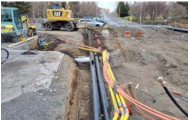
↑ Stór hluti af framkvæmdinni sneri að endurnýjun lagna í vegstæðinu.
