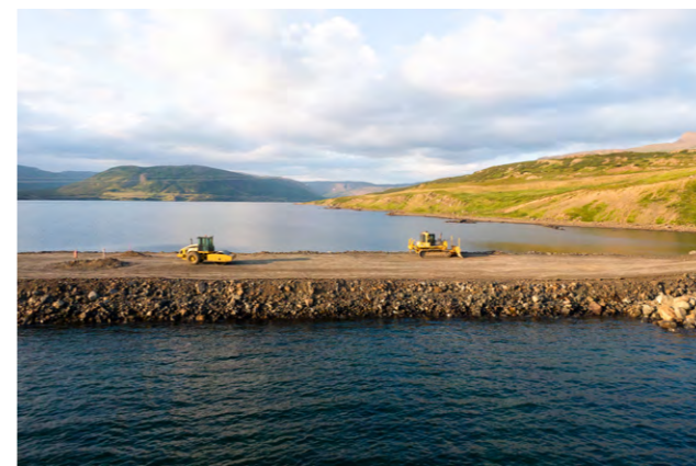
Framkvæmdir við þverun Þorskaflirðar standa yfir.
