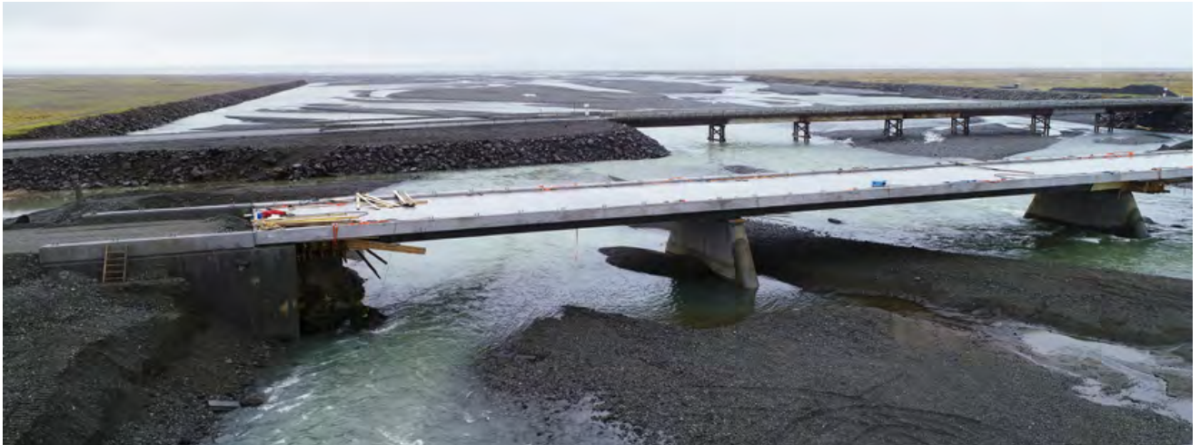
Steinavötn, nýja brúin í byggingu og bráðabirgðabrú í baksýn. Mynd: Ístak
