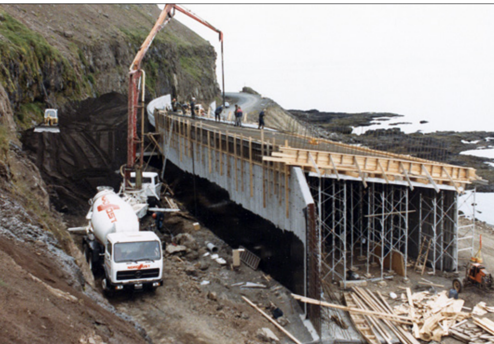
Gerð vegskála í Óshlíð 14. ágúst 1986. Einn Ó-veganna. Þessi mannvirki eru ekki lengur í notkun eftir að Bolungarvíkurgöngin komu í stað vegar um Óshlíðina.
