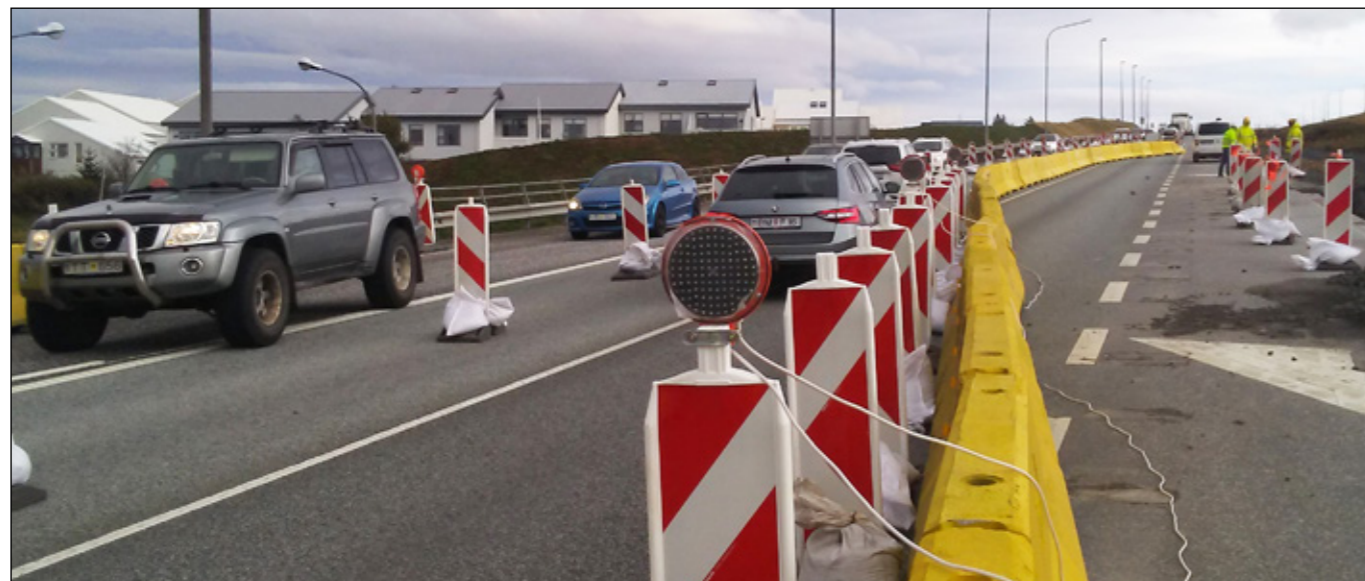
Nú standa yfir miklar framkvæmdir við tvöföldun Reykjanesbrautar (41), Kaldárselsvegur – Krýsuvíkurvegur. Vegfarendur munu þurfa að sýna sérstaka tillitssemi á þessu vinnusvæði næsta árið.
