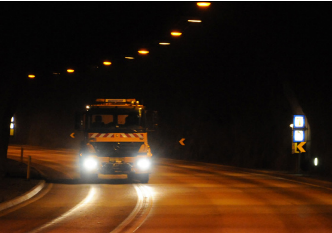
Hvalfjarðargöng voru opnuð 11. júlí 1998.
