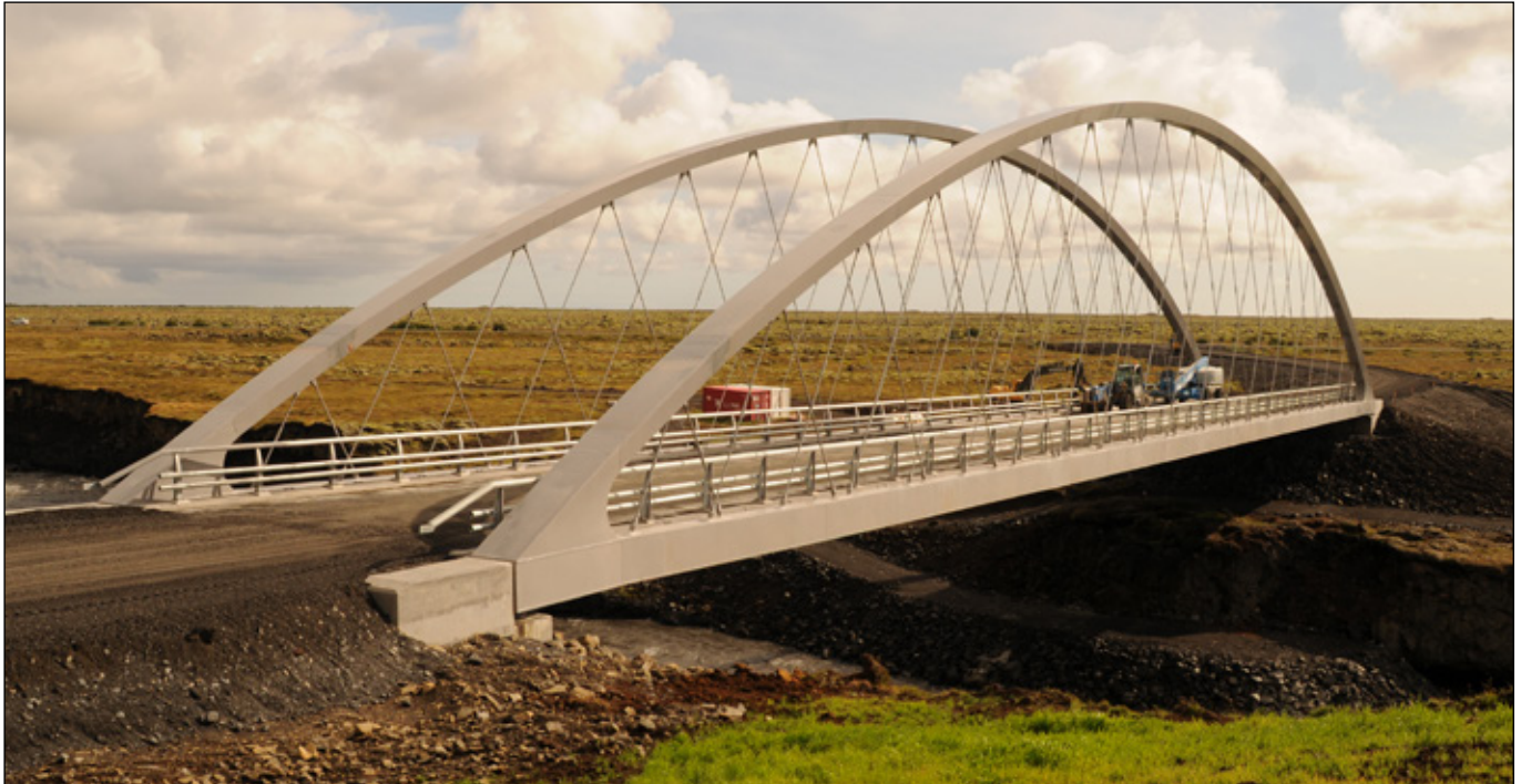
Skaftártunguvegur (208) um Eldvatn. Búið er að leggja fyrra lag klæðingar á veginn og var umferð hleypt á nýjan veg og brú 12. september sl. Gömlu leiðinni hefur verið lokað. Þessi mynd var tekin 6. september.
