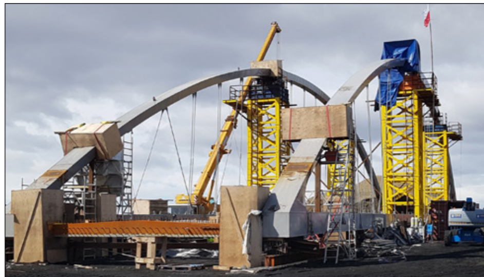
8. maí 2019 kl. 14:07. Samsetning stálverkja langt á veg komin. Stál í boga og langbita kom í allt að 18 m löngum einingum sem soðnar voru saman á verkstað. Brúin er stálbogabrú með fristandandi bogum og neti hengistanga sem bera upp langbita. Langbitarnir verka jafnframt sem togband sem tekur upp lárétta spyrnkrafta bogans.
