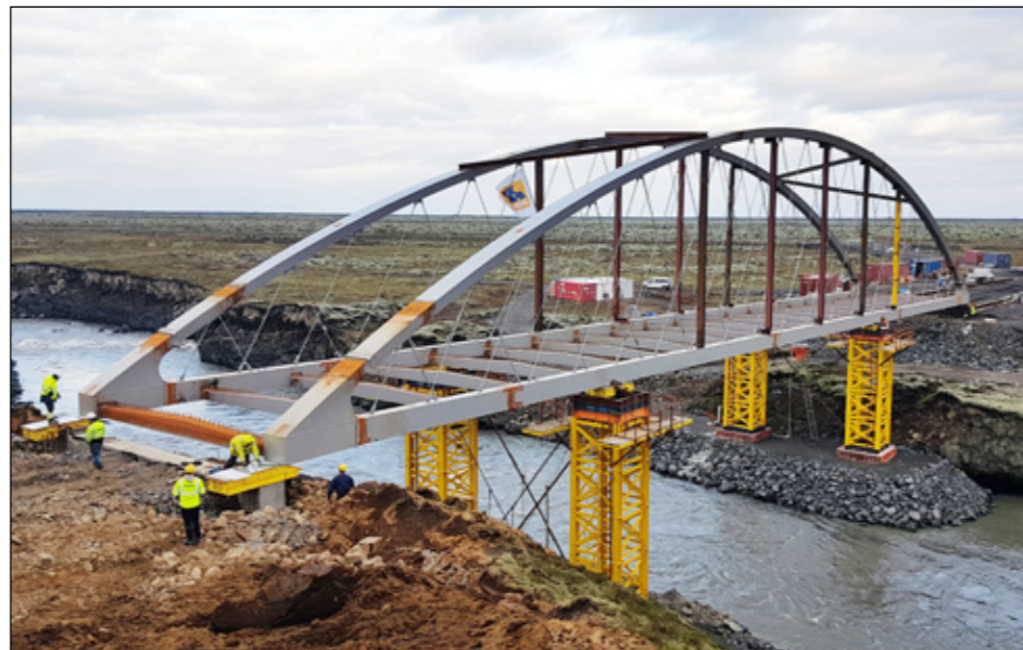
26. maí 2019 kl. 20:45. Brúin lendir á steypum endastöplum á noðurbakkanum. Undirstöður eru steypar, skorðaðar í klöpp með bergboltum.
