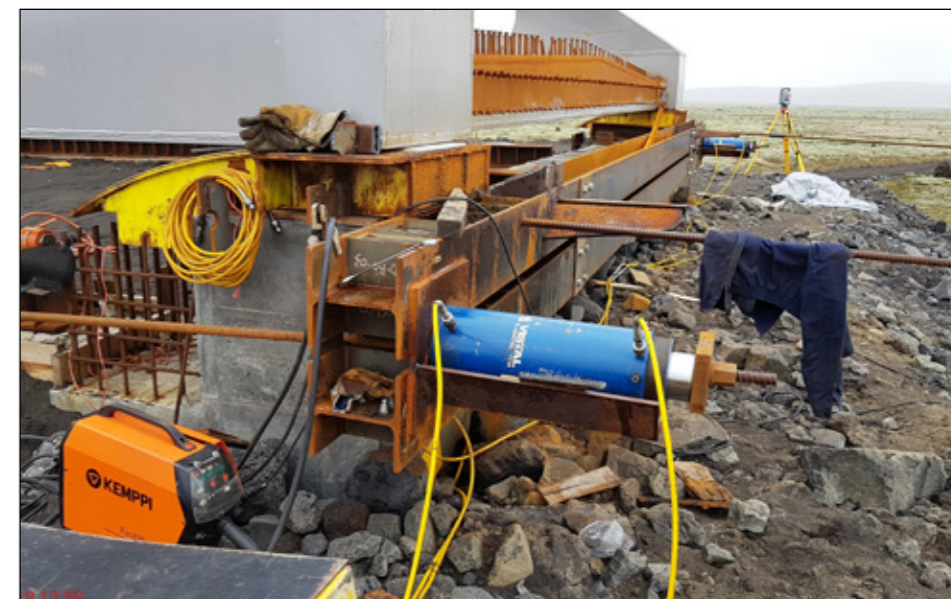
24. maí 2019 kl. 12:00. Tjakkarnir sem toga brúna fram. Heildarþyngd brúarinnar þegar hún var dregin yfir var um 200 tonn.
