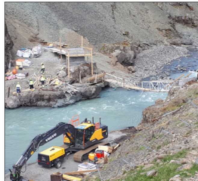
Unnið við stöpla, bráðabirgðabrú komin upp, 28. maí 2019.
