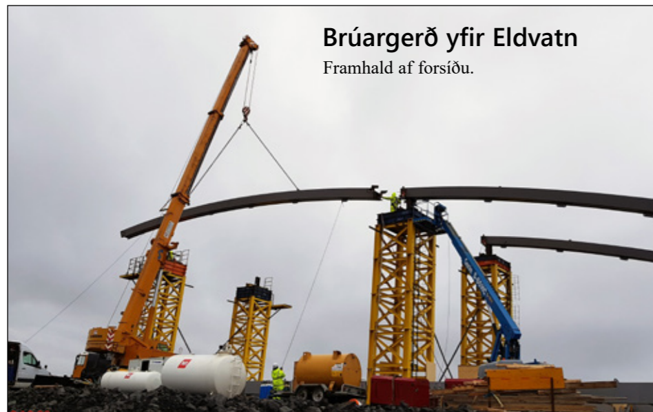
10. apríl 2019 kl. 10:30. Boginn reistur. Aðalverktaki verksins er Munck Íslandi ehf. en undirverktaki við stálsmíði og reisingu var Vistal í Gdansk í Póllandi.
