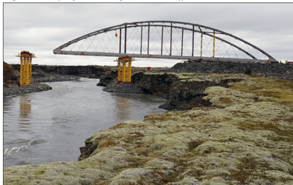
26. maí 2019 kl. 11:39. Lóðréttar stálstífur og þverstífur á milli boga eru fjarlægðar þegar brúin er komin yfir á endastöpla.
