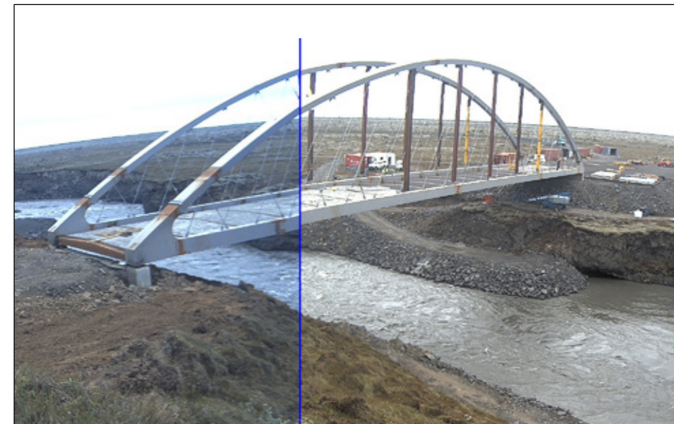
13. júní 2019 kl. 09:20. Samsett mynd frá vefmyndavél. Vinna við brúargólf í gangi. Brúargólfid er steyppt plata, samverkandi við þverbita, steyppt ofan á forsteypptar einingar.
