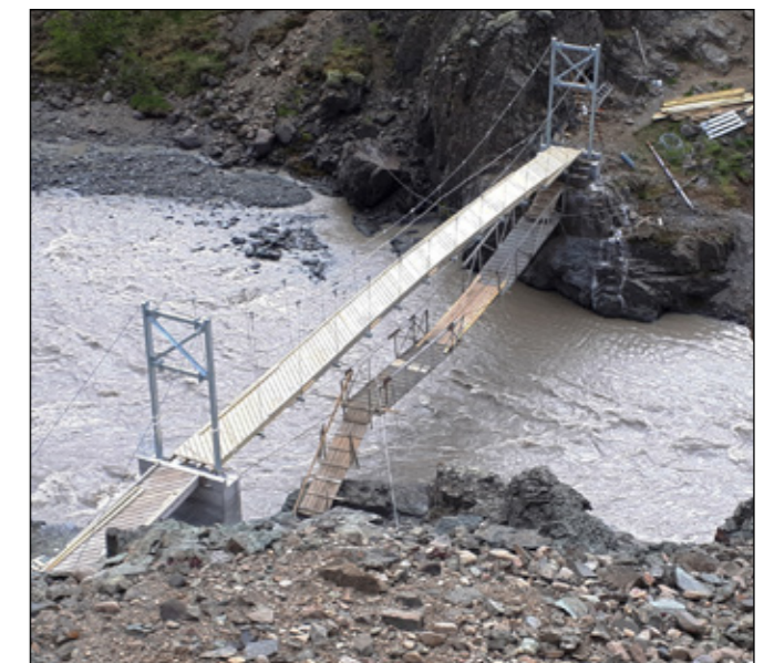
Brúargerðin langt komin 14. júní 2019. Eftir var að ganga frá handriðum og landbrú öðru megin.
