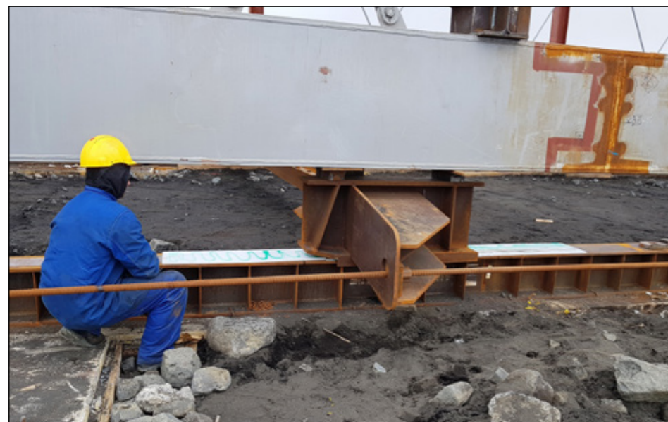
24. maí 2019 kl. 14:53. Brúin var reist á nokkurskonar braut úr stálbitum. Sleðinn sem brúin var dregin á hvíldi á teflon plötum til að lágmarka viðnám við yfirdráttinn.
