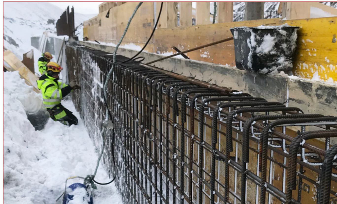
Brúavinnuflokkur Vegagerðarinnar frá Hvammstanga vinnur nú að gerð 60 m stokks fyrir Tjarnará á Vatnsnesi. Stokkurinn kemur í staðinn fyrir lélega einbreiða brú. Vegagerð yfir stokkin er á lista yfir fyrirhuguð útböð.
