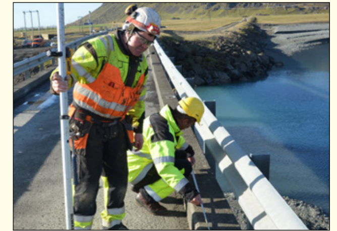
Sigurður Hallur Sigurðsson brúasmíður og Aron Bjarnason tæknifræðingur meta ástand gömlu brúarinnar. Samkvæmt útreikningum var ekki hægt að réttlæta umferð léttra bifreiða yfir brúna. Hins vegar var ákveðið að leyfa gangandi vegfarendum að fara um brúna undir eftirliti.
