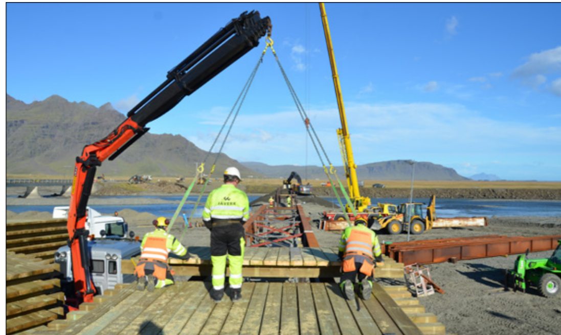
Þverbiti settur upp á undirstöður, staura sem reknir eru niður.
