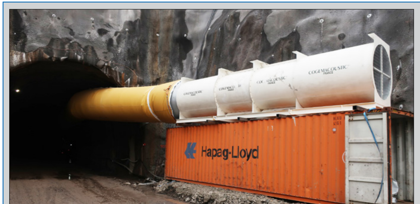
Nú eru Dýrafjarðargöng orðin það löng að þörf er á loftræstingu. Blásari er kominn upp.
