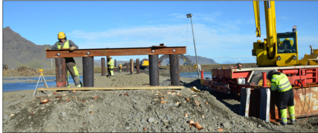
Þverbiti settur upp á undirstöður, staura sem reknir eru niður.
