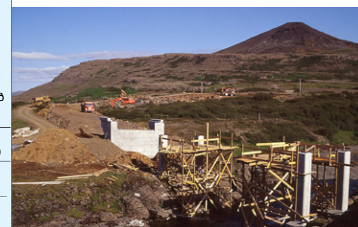
Efri mynd: Brú yfir Laxá hjá Vindáshlíð í byggingu 1994. Neðri mynd: Sama brú í ágúst 2017. Nú hafa verið boðnar út endurbætur á vegi og lagning bundins slitlags á þennan vegarkafli. Brúin er með 7 m breiðri akbraut.
