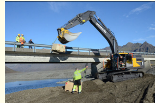
Gert var álagspróf á löskuðu brúnni. Það fór þannig fram að settur var þungi upp á 4 tonn á löskuðu höfin, þ.e. á milli ónýta stöplunsins og næstu stöpla til hvorrar hliðar. Fyrst var fargið sett á vestan megin og varð þá 3 mm sig en þegar álagið var tekið af rétti brúin sig af á ný. Það var því innan marka og mælingar á sprungum sýndu engar breytingar. Þá var farið í hafid austan megin og gert það sama. Svipað sig mældist þar en þegar álagið var tekið af fór brúin ekki aftur til baka, þ.e. sigið var orðið varanlegt. Þá voru mælingar endurteknaðar og álagið látið sitja í klukkustund. Austan megin jókst sigið enn frekar, var orðið 7 mm og fór ekki til baka. Greinilegt var að burðarkerfi brúarinnar var orðið alveg ónýtt og flot varanlegt. Því var ákveðið að hleypa ekki umferð léttra bíla á brúna.
