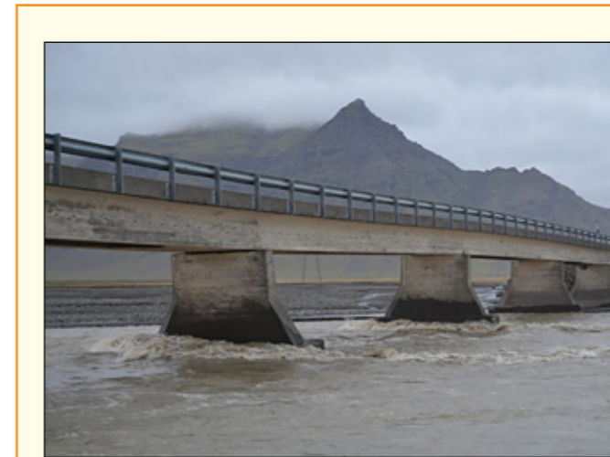
Þrátt fyrir gríðarlega úrkomu og flóð hefði brúin á Steinavötnum að öllum líkindum staðist áhlaupið ef svo óheppilega hefði ekki viljað til að áin lagðist vestast í farveginn og rann svo í austur, þvert á stöplana. Þá myndast sog hlémeigin og það grefst frá stöplunum það mikið að einn þeirra gaf sig.
