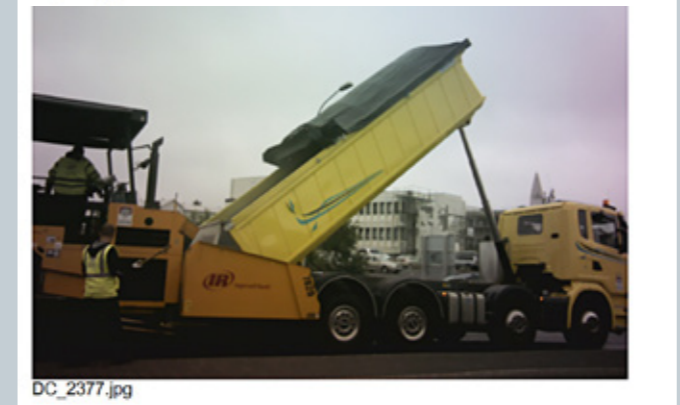
Hitatap malbiks á flutningsvagni. Þessi vagn virðist vera nokkuð vel einangraður og mælist varmatap mest 50°C neðst á hlið hans.
