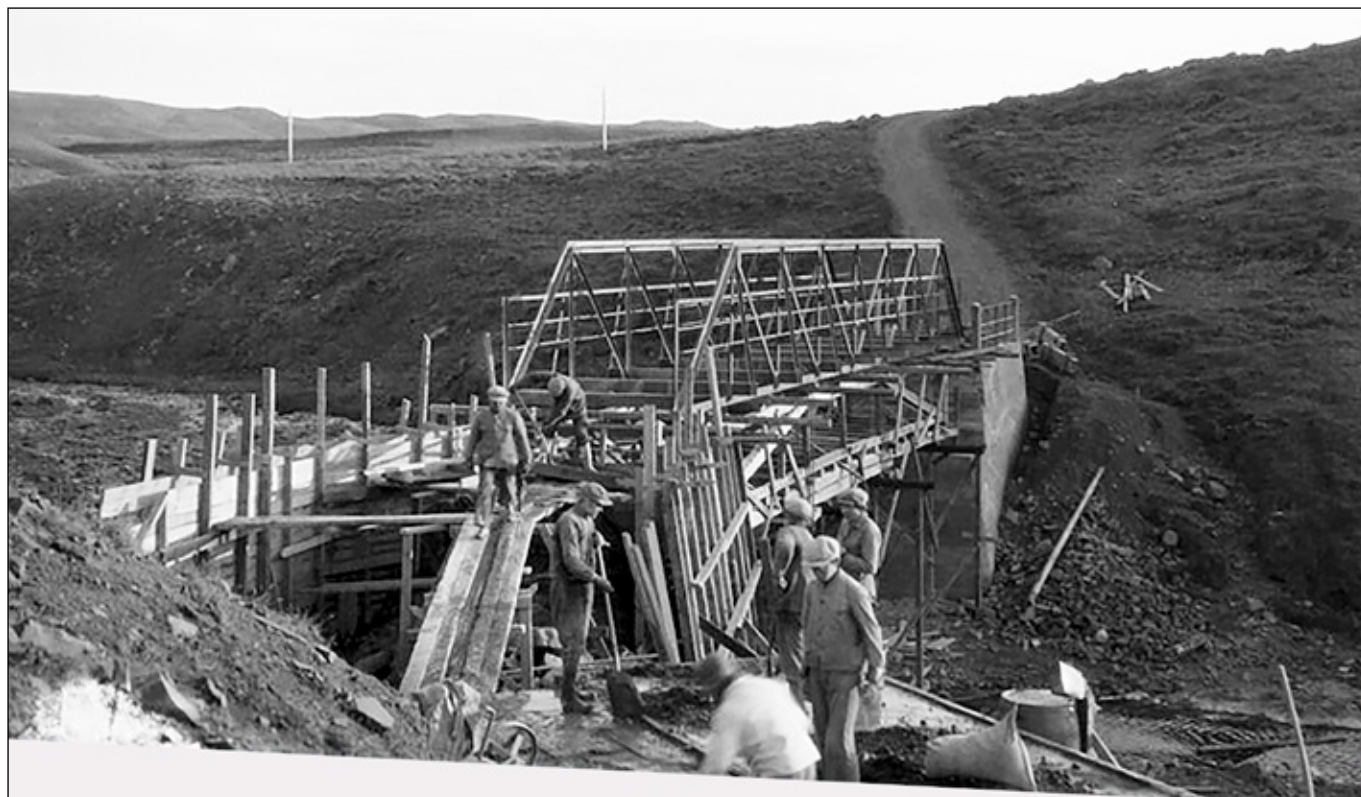
Brúin yfir Laxá við Kjörseyri í Hrótafirði í byggingu 1929. Sjá má eldri trébrú undir stálbitabrúnni en hún hefur verið notuð sem upppláttur undir nýju brúna á meðan grindarbitarnir voru settir saman. Verið er að steypa annan stöpulinn. Steypan er handhrærd á palli og henni síðan ekið út á hjólbörum. Steyptir stöplar undir trébrúnni hafa væntanlega verið hækkaðir við þessa framkvæmd og má enn í dag sjá hilluna sem trébrúin hefur settið á. Myndin er úr safni Geirs G. Zoega. Við myndatökuna hefur myndavélin hallað aðeins og er myndin rétt af fyrir birtingu hér. Það er ástæðan fyrir ljósum þríhyrningi neðst á myndinni.
