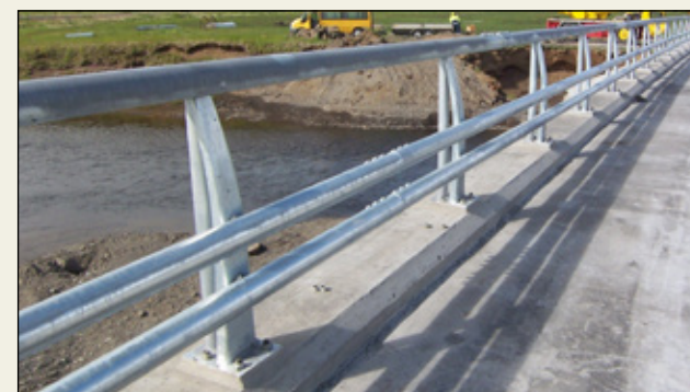
Brúavegríð, vegriðsstoðir og vegriðsbeinar úr sívölum rörum.
