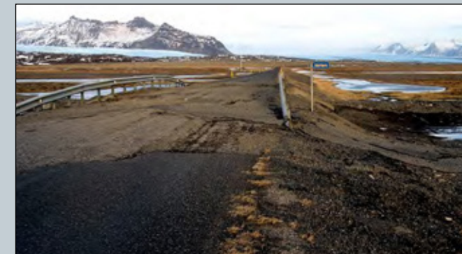
Skemmd á malbiki á Hringveginum, rétt sunnan við Kvísker, horft til norðurs. Í forgrunni er malbikið fokið af veginum og liggur til hægri við hann, í því sem næst heilu lagi.
