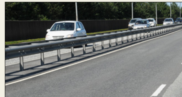
Miðjuvegríð, vegriðsstoðir og W-bitavegríðsbeinar.
