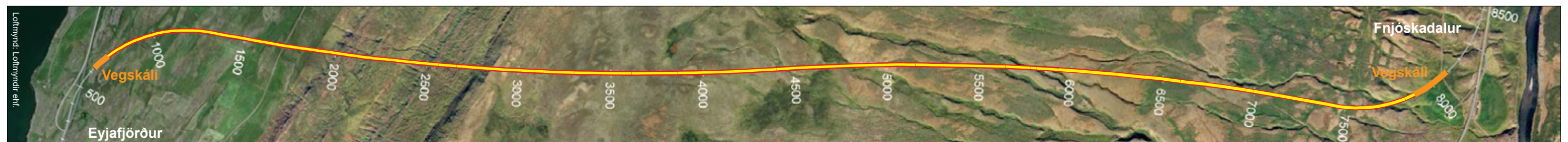
Vaðlaheiðargöng, gegnumslag var 28. apríl 2017.
