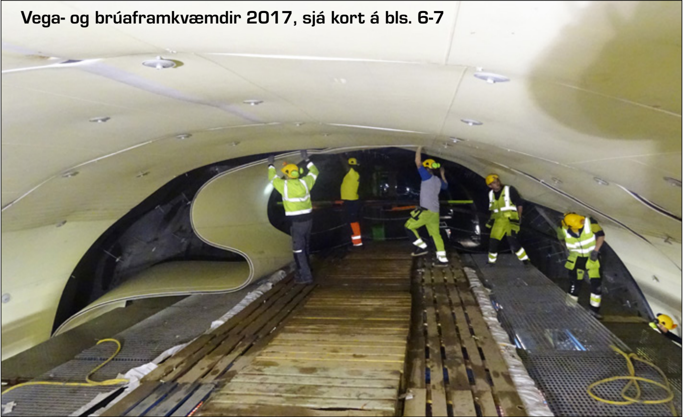
Húsvíkurhöfðagöng 7. mars 2017. Einangrunar- og vatnasklæðing sett upp, 45 mm dúkur. Síðan er sett 80 mm lag af sprautusteypu yfir dúkinn sem brunavörn.
