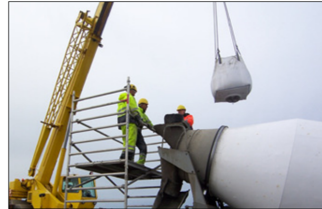
Steypa blönduð í steypubíl á staðnum.
