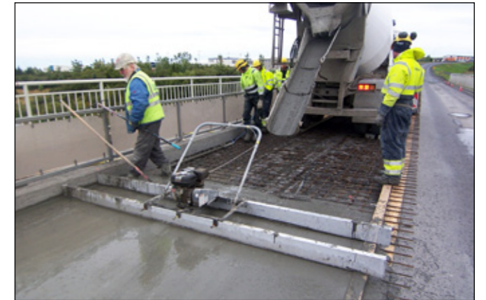
Steypa lögð út á vinstri akrein. Sjá má nýja járnabindingu.
