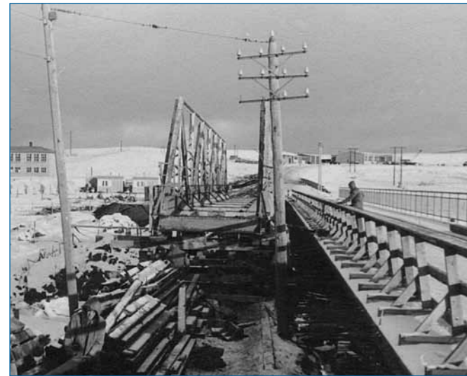
Bygging Blöndubrúar 1962. Fyrir í brúarstæðinu var gömlu stálgrindarbrú. Því var hægri akrein nýju brúarinnar byggð fyrst. Síðan var umferð hleypt á þann brúarhluta en gamla brúin fjarlægð (og flutt á Svartá). Að því loknu var vinstri akrein nýju brúarinnar byggð.
