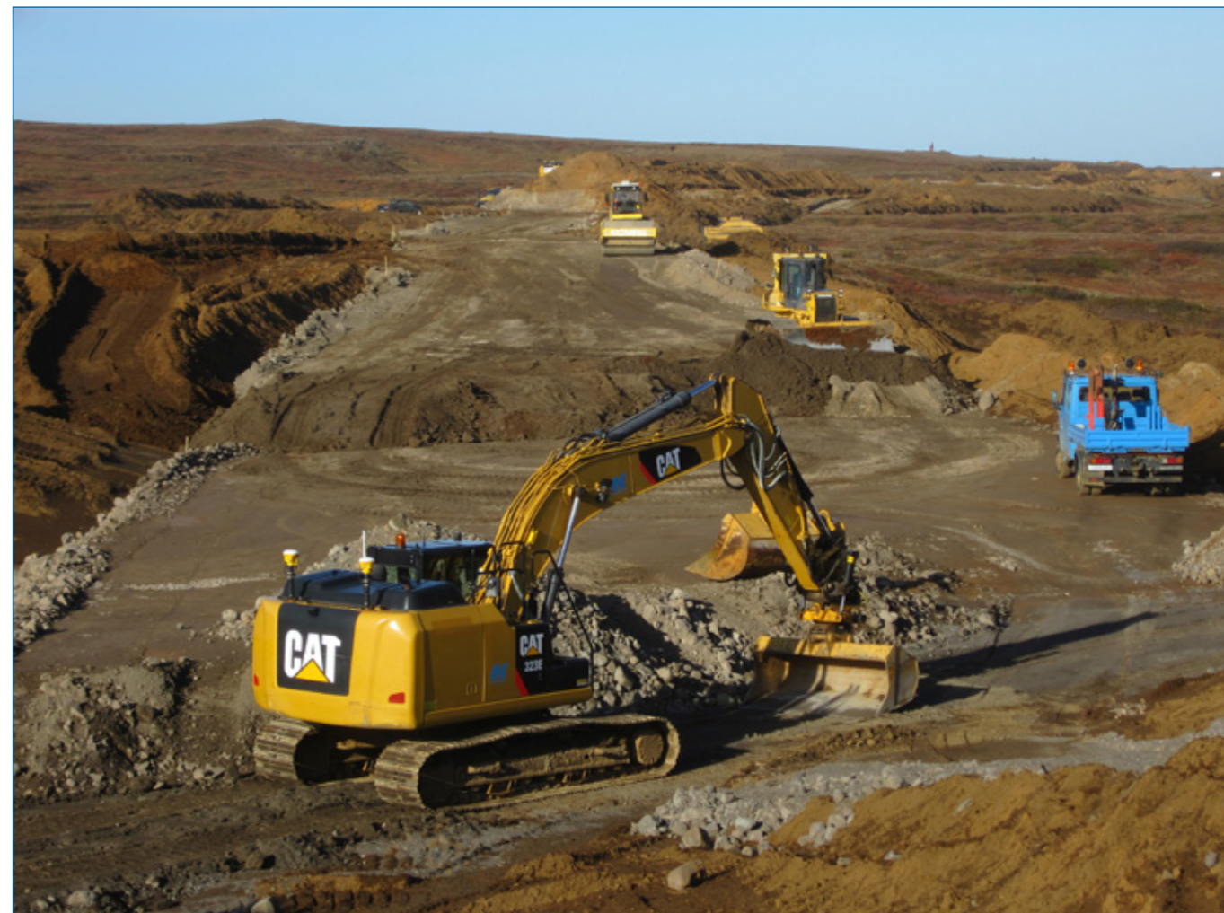
Framkvæmdir við Dettifossvog 3. október 2016.
