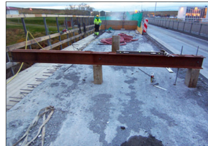
Stálbitar til að halda uppi undirlætti. Innri endi er festur niður með tveimur teinum sem eru línðir niður í brúargólfið.
