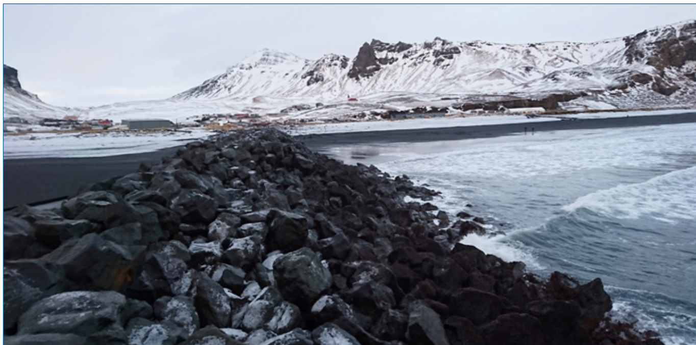
Vík í Mýrdal, sandfangari sem var byggður 2011, sjá niðurstöðu útbóðs hér á síðunni.
