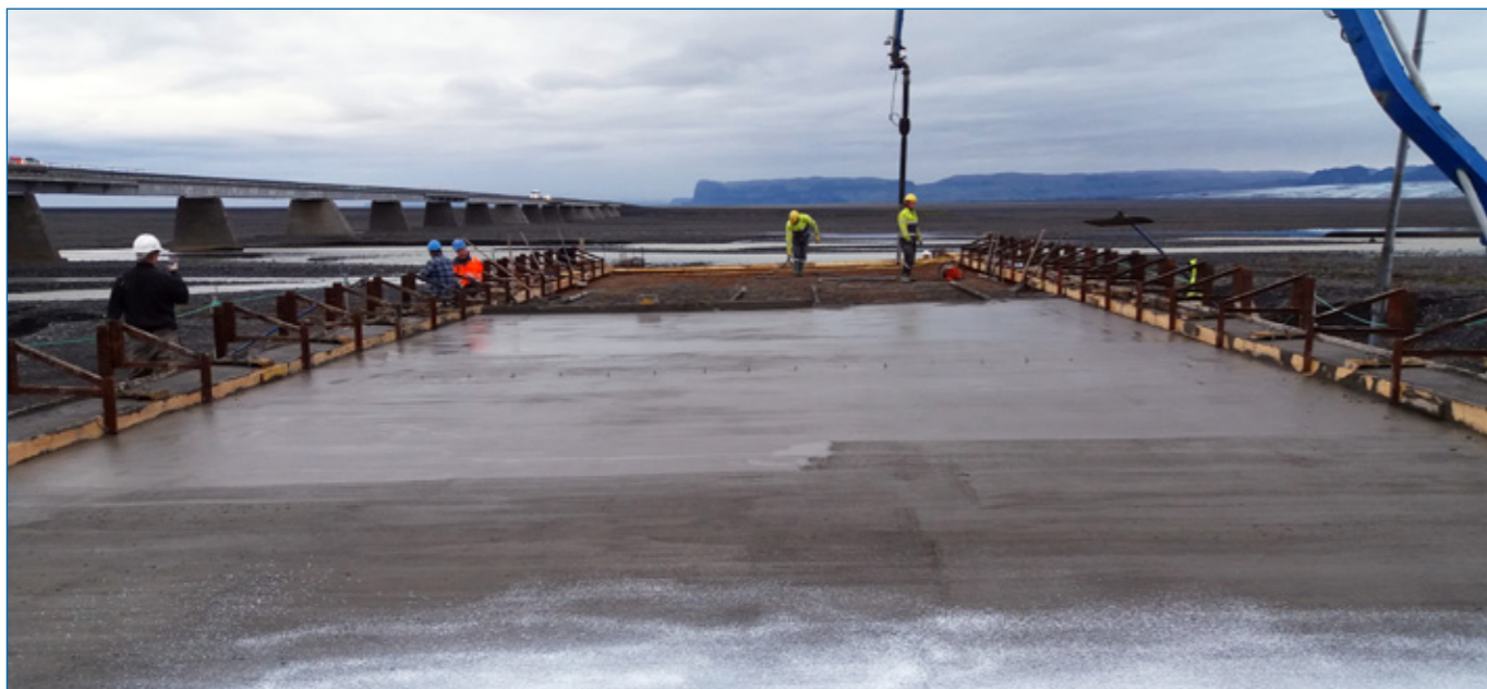
Steypuvinna við Morsá 16. október. Skeiðarárbrú sést til vinstri og Lómagnúpur er í baksýn.
