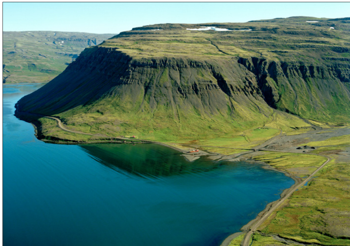
Skápadalur og Skápadalsmúli. Eystri mörk útboðskafla. Samið hefur verið við Borgarverk ehf. um framkvæmd verksins. Ljósmynd: Mats Wibe Lund.
