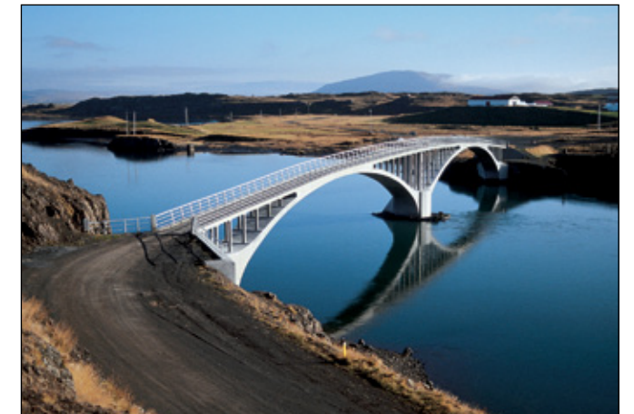
Hvítá hjá Ferjukoti, Borgarfirði, 106 m löng steipt bogabrá með tveimur bogum, byggð 1928. Hönnun: Árni Pálsson. Endurgerð 2001.
