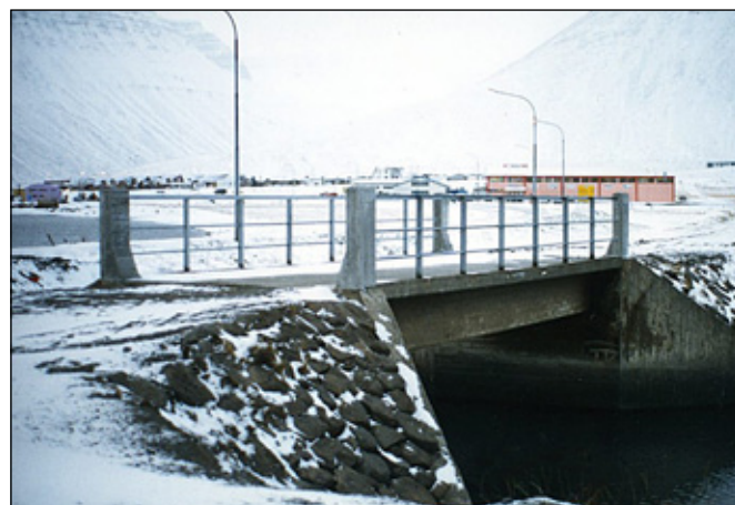
Tunguá í Skutulsfirði, 10 m löng steipt bitabrá byggð 1940.
