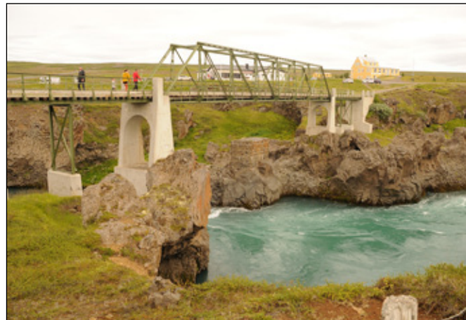
Skjálfafljótið hjá Fosshóli, 71 m löng stálgrindarbrú, byggð 1930. Var í notkun til 1972. Kom í stað eldri brúar frá 1883.
