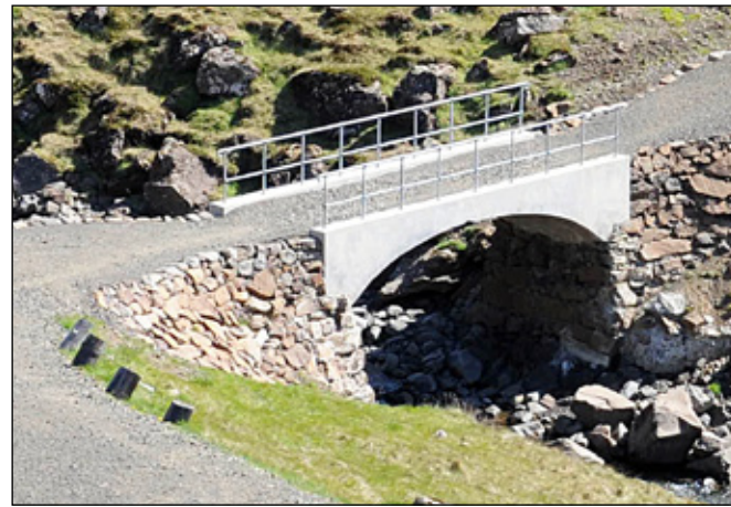
Bláskeggsá hjá Þyrli í Hvalfirði, 7 m löng steipt bogabrá, byggð 1907, í notkun til 1951. Elsta steinsteypubogabrá landsins. Hönnun: Jón Þorláksson. Endurgerð brú vígð 2010.
