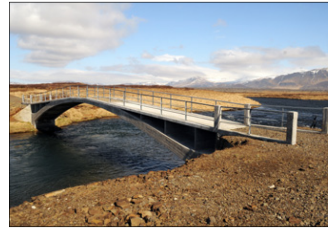
Haffjarðará, 30 m löng og 2,80 m breið steipt bogabrá, byggð 1912. Í notkun til 1965. Endurgerð 2011.
