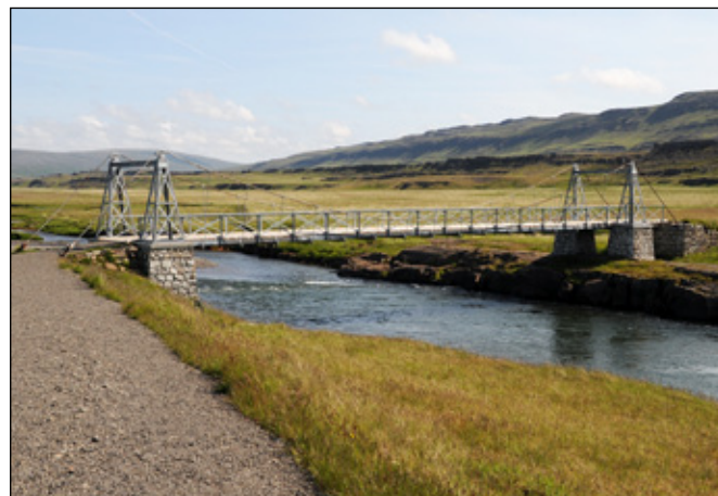
Örnólfsdalsá hjá Norðtunga, 33 m löng hengibrú, byggð 1899. Hönnun: Windfeld Hansen / Sigurður Thoroddsen. Eina varðveitta brúin frá 19. öld.
