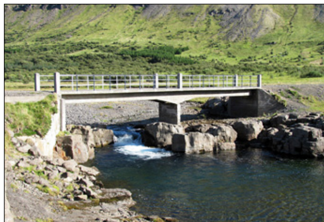
Botnsá í Hvalfirði, 22 m löng steipt bitabrá, byggð 1932, lagfærd 1985.
