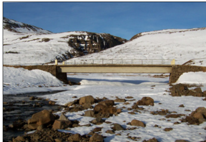
Geithúsaá í Reyðarfirði, 18 m löng, bitabrá, byggð 1935 á stöplum timburbrúar frá 1905.
