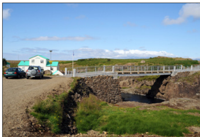
Hítará, gamlar undirstöður frá 1905. Ný yfirbygging 2008.
