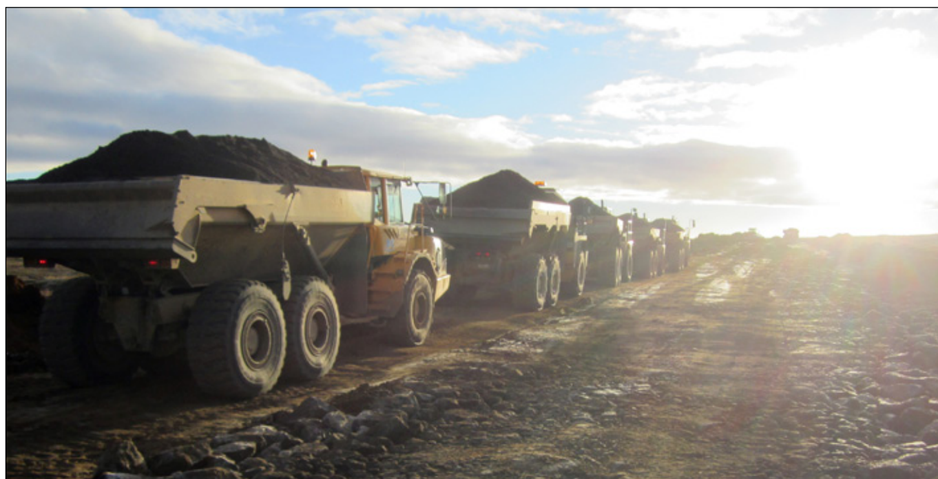
Dettifossvegur (862), Ásheiði - Tóveggur, 10. nóvember 2015.
