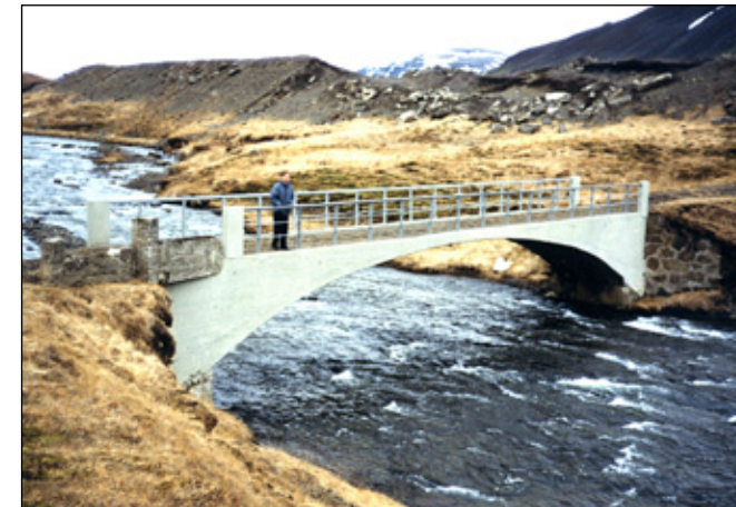
Kaldakvísl í Mosfellsbæ, 19,3 m löng steipt bogabrá, byggð 1912. Lagfærð 1986.
