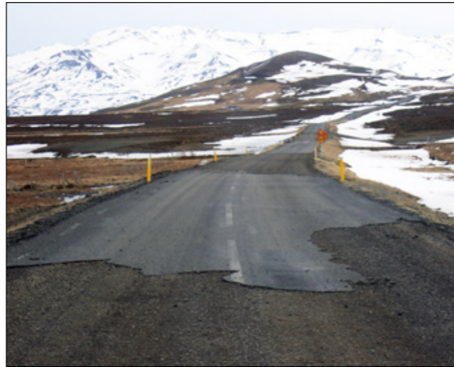
Siglufjarðarvegur (76) við Stafá.
