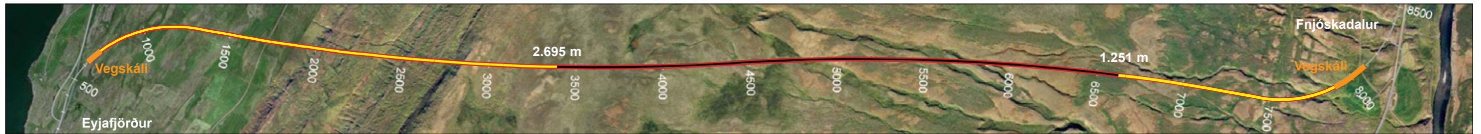
Vaðlaheiðargöng, staða framkvæmda 16. mars 2015. Búið er að sprengja samtals 3.946 m sem er 54,8% af heildarlengd.
