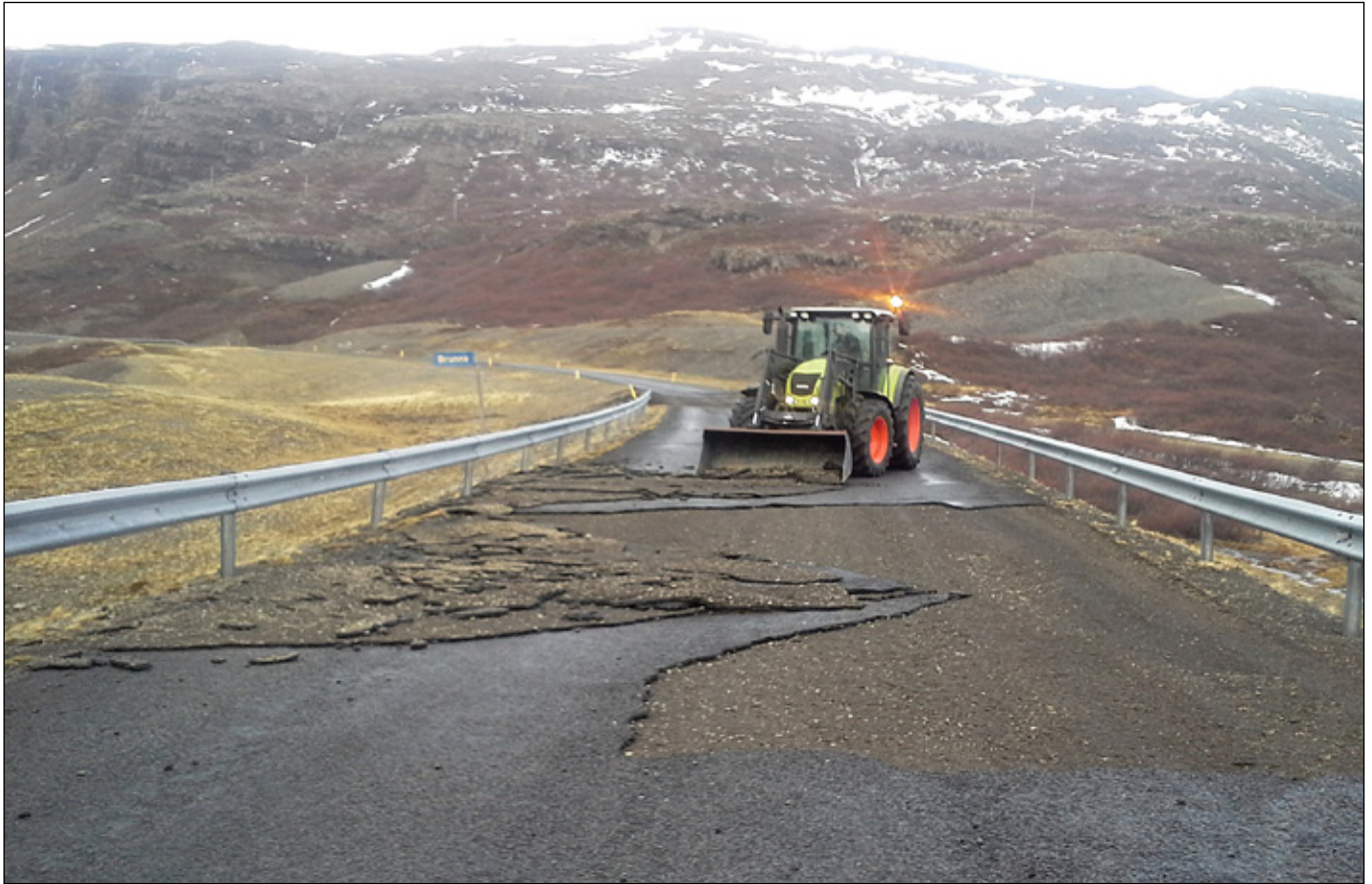
Hvalfjarðarvegur (47) við Brunná. Skemmdir á klæðingu eftir ofsaveður laugardaginn 14. mars.
