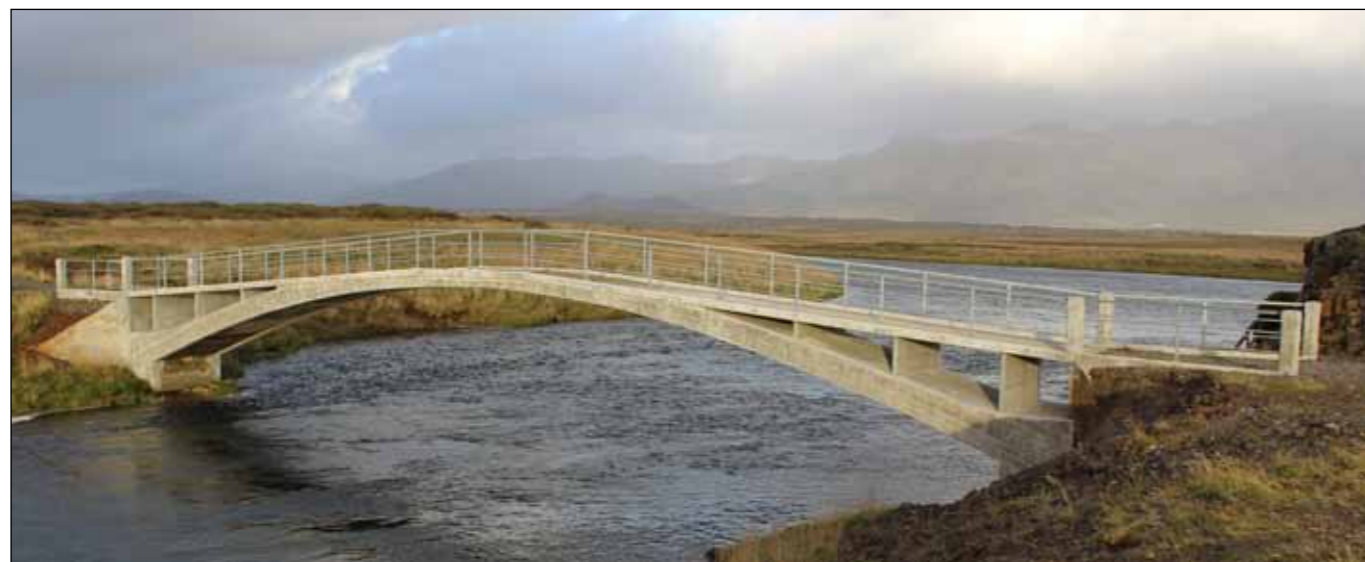
Haffjarðará, gömul brú eftir endurbyggingu.
