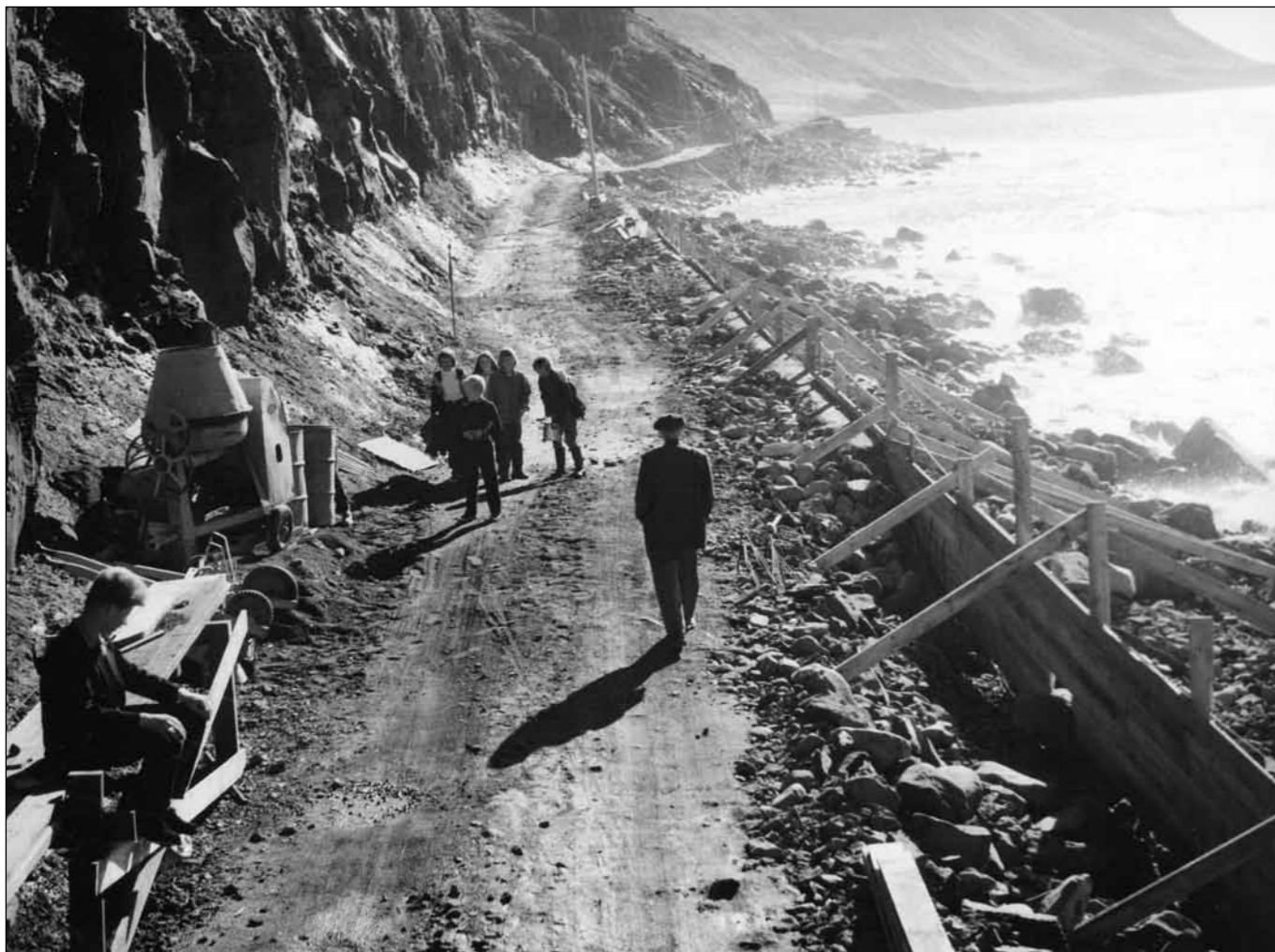
Bætt við steyptan varnargarð undir Spilli árið 1960. Myndina tók Jón J. Víðis en pilturinn sem situr á járnabekknunum er líklega Jakob Hálf-danarson sem var aðstoðarmaður Jóns við landmælingar.
