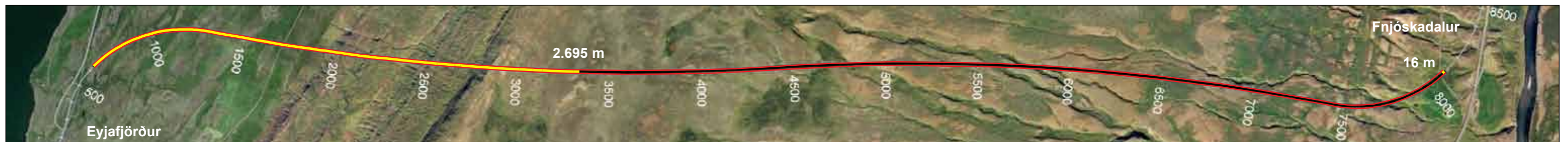
Vaðlaheiðargöng, staða framkvæmda 8. september 2014. Búið er að sprengja samtals 2.711 m sem er 37,6% af heildarlengd.
