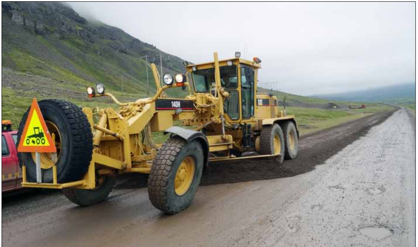
Enn er hluti Hringvegur (1) í Berufirði með malarlitlagi. Hann var hefлаður 8. júlí. Þorleifur Olsen vélamaður á Höfn stjórnaði heflinum. Ljósmynd: Hafdis Eygló Jónsdóttir.
