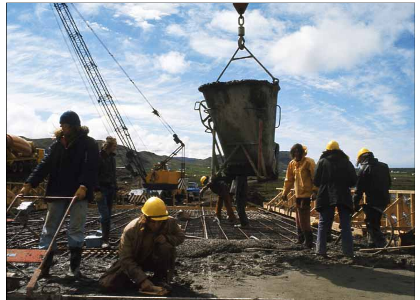
Brúarvinnuflotkur Huga Jóhannessonar að steypa brúardekk á Köldukvísl hjá Gljúfrasteini í Mosfellsdal árið 1974. Ljósmynd: Ímynd.
