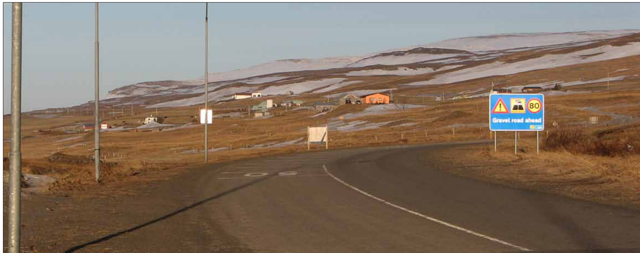
Vatnsnesvegur (711) norðan Hvammstanga. Mörk útboðssvæðis. Ljósmynd: Hafdís Eygló Jónsdóttir.
