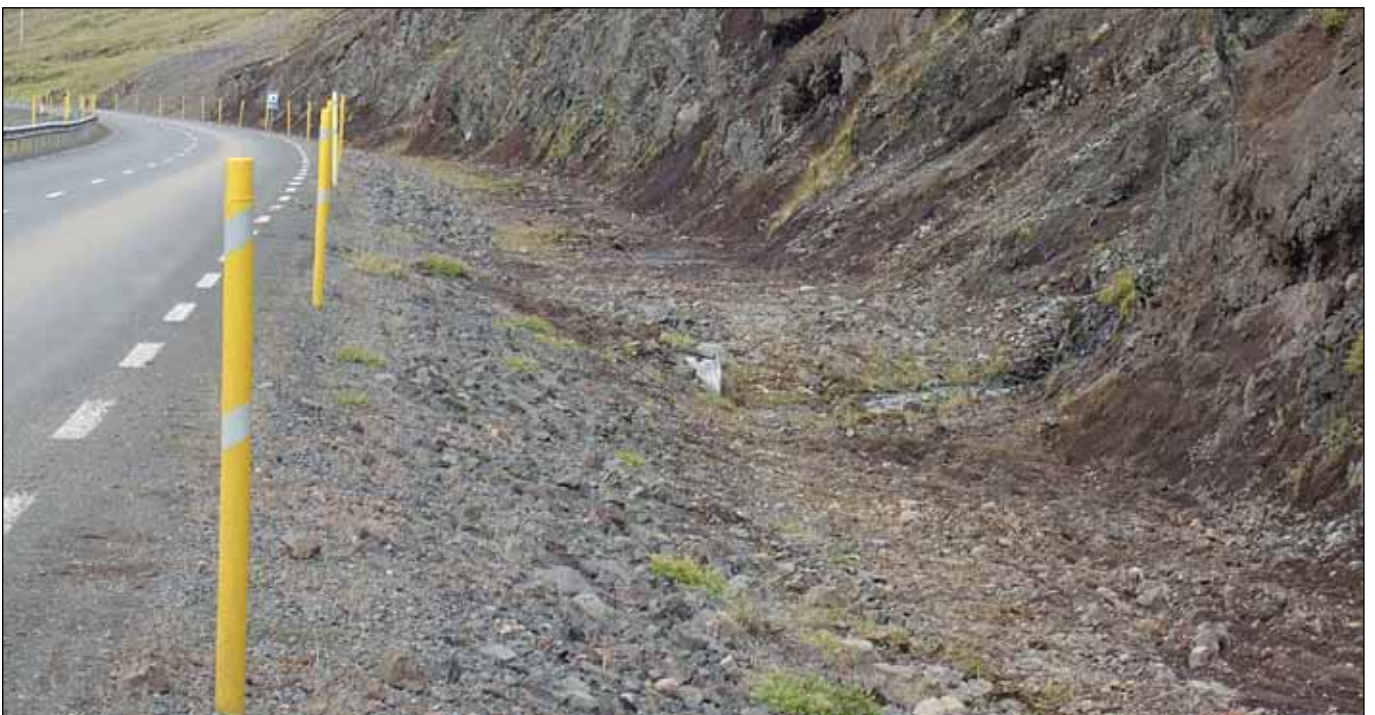
Vegrásir á Öxnadalshéiði fyrir og eftir grjóthreinsun. Í skýrslunni „Lagfæringar á umhverfi vega“ er fjöldi mynda sem sýnir hættulega staði og hvernig þeir gætu litid út eftir lagfæringar.
