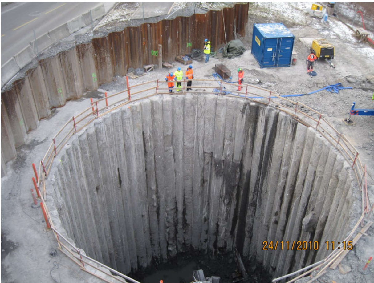
Mynd 16. Dæmi um staðsteypta staura, hér niður á 22 m dýpi við Midgardsormen verkefnið í Osló [4].
