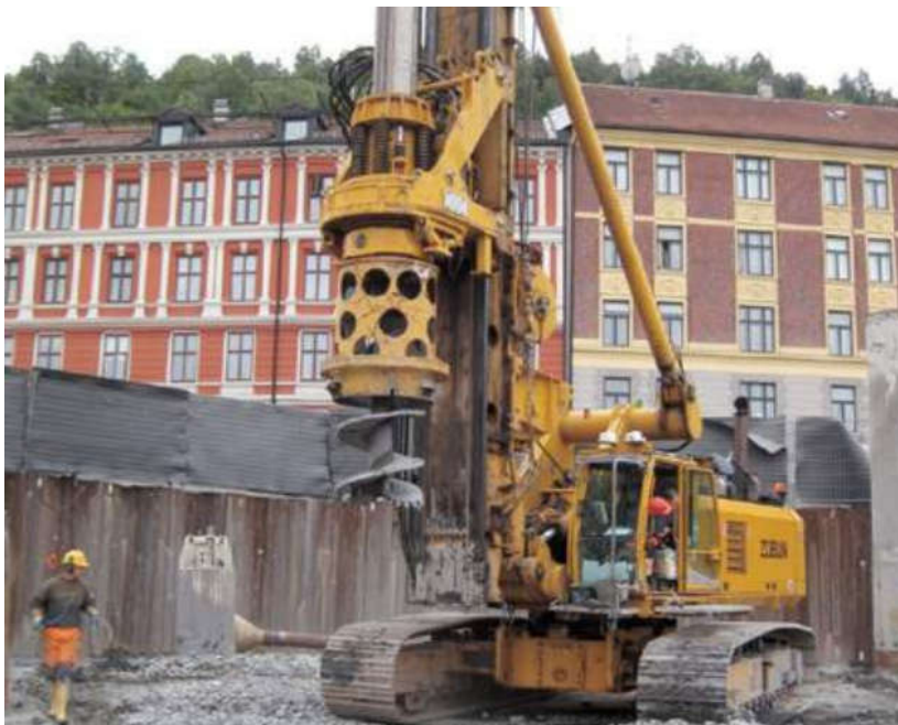
Mynd 14. Bortæki og borkróna með 1080 mm þvermál [3].
