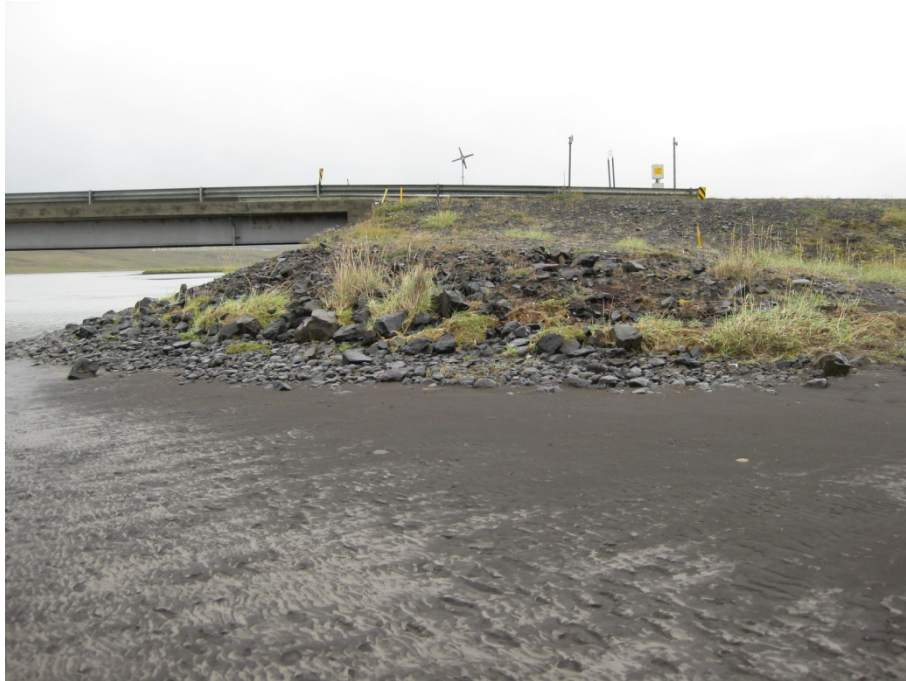
Mynd 10 – Grjót hefur verið flutt í vestari leiðigarð til styrkingar. Myndin er tekin til suðurs.
