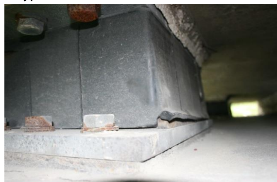
Myndir 21 og 22 – brú á Sog í Prastalundi – legur á landstöpli austan ár
