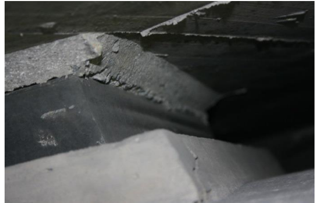
Myndir 25a og 25b – brú á Sæbraut – legur á landstöpli norðan Sæbrautar
