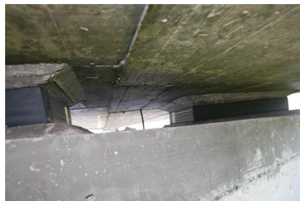
Mynd 24 – lega á millistöpli austan ár
