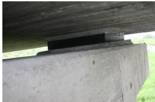
Mynd 11 – legur í brú í Bæjarhálsi – millistöpull
