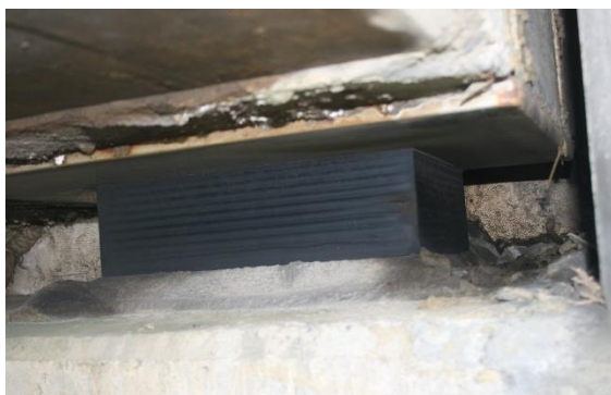
Myndir 28 – brú á Ölvusárósi – rennilega á landstöpli stöpull nr. 1 að austan
