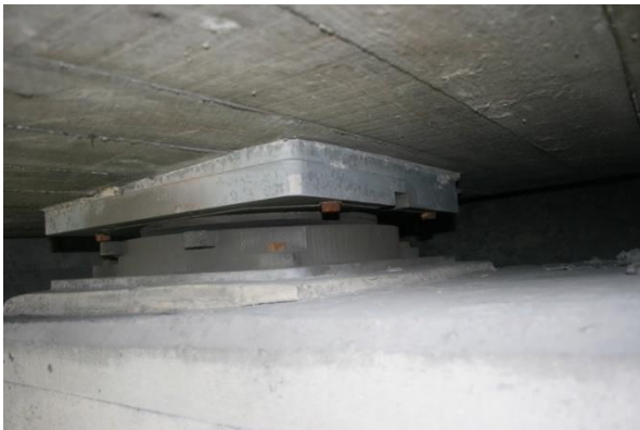
Myndir 14 – lega á norður – landstöpli Elliðaárbrúar við Ártúnsbrekku
