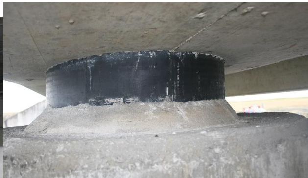
Myndir 26 og 27 – brú á Þverá við Hvolsvöll – legur á landstöpli og millistöpli austan Þverár
