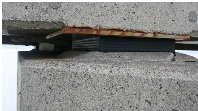
Mynd 29 – rennilega á stöpli nr. 2, millistöpull
