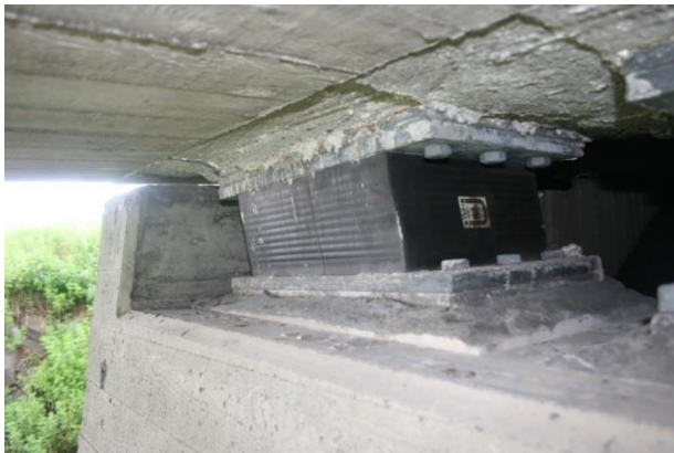
Mynd 10 – legur í brú í Bæjarhálsi – landstöpull
