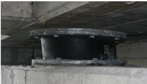
Myndir 26 og 27 – brú á Þverá við Hvolsvöll – legur á landstöpli og millistöpli austan Þverár
