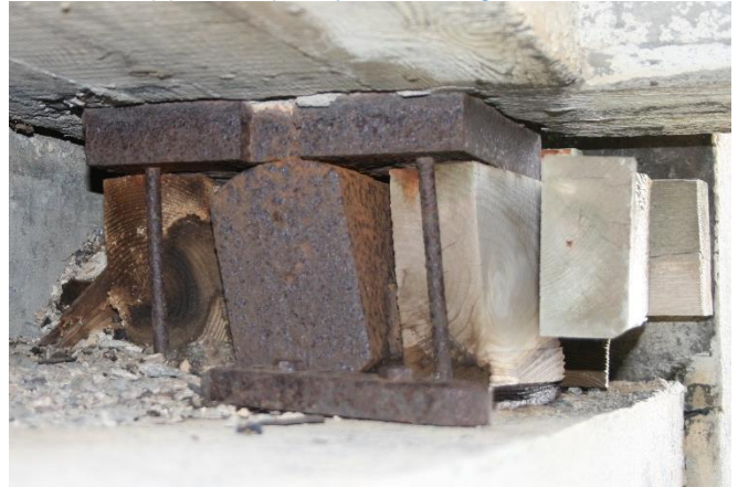
Myndir 16 og 17 – brú á Gljúfurá í Borgarfirði – veltilegur að austanverðu
