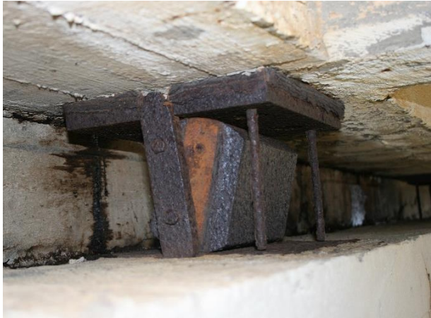
Myndir 16 og 17 – brú á Gljúfurá í Borgarfirði – veltilegur að austanverðu
