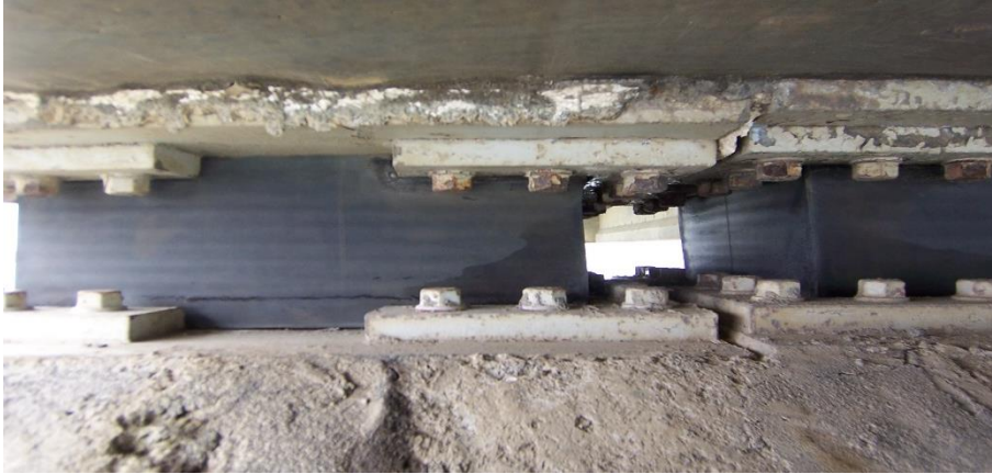
Myndir 30 – brú á Ölvusárósi – millistöpull. SHS 2008
