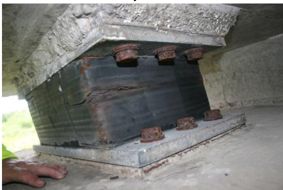
Myndir 21 og 22 – brú á Sog í Prastalundi – legur á landstöpli austan ár
