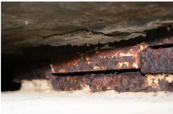
Myndir 19 – brú á Norðurá hjá Haugum – færslustýring á landstöpli að austanverðu
