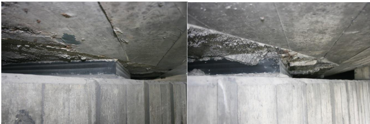
Mynd 4 og 5 – legur í brú á Arnarneshæð – landstöpull
