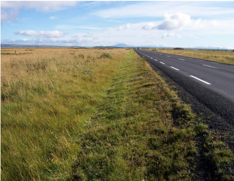
Mynd 1. Algengt er að slá vegfláa. Þolnar tegundir (t.d. snarrót) eru ekki gallalausar, þær hindra landnám staðargróðurs. Slá þarf efsta hluta vegfláans, til að hindra skaflamyndun á vegi.
