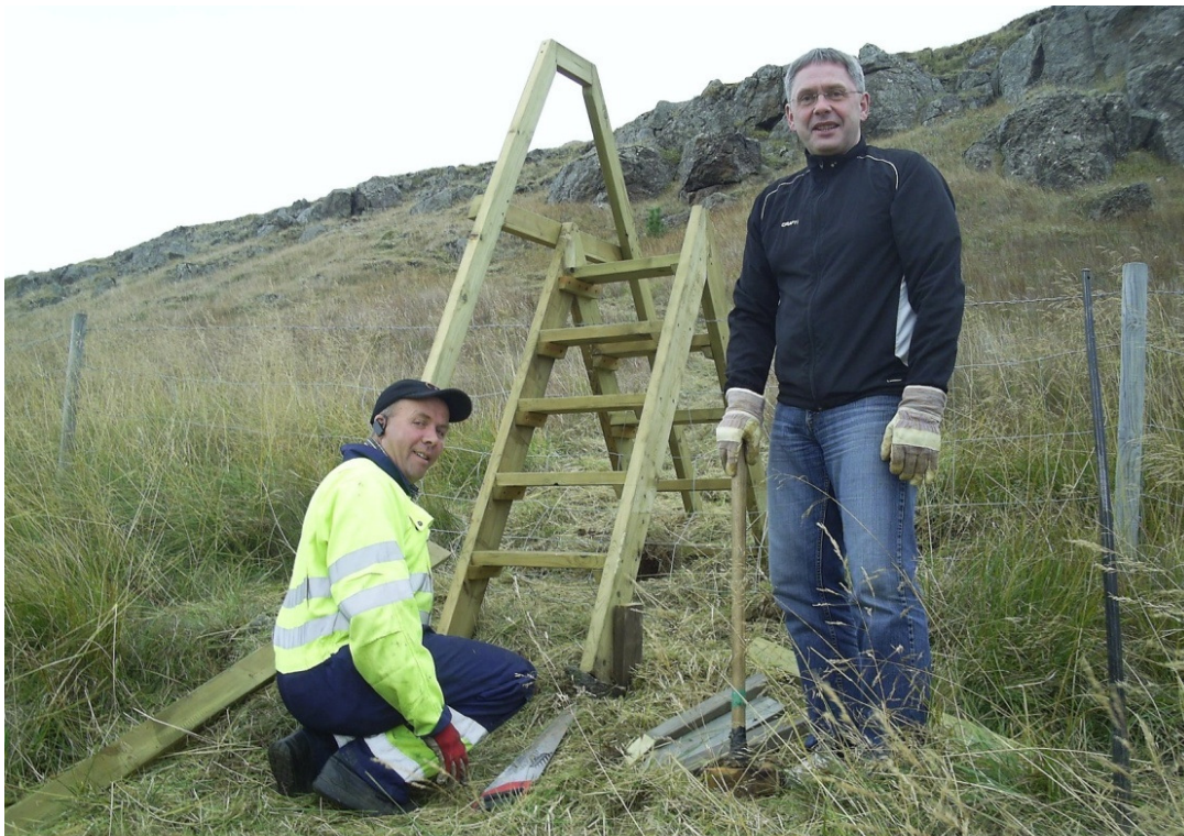
Mynd 58. Sveinn Einarsson og Gunnar Guðmundsson við uppsetningu prílu. (Valgeir S. Kárasón).
