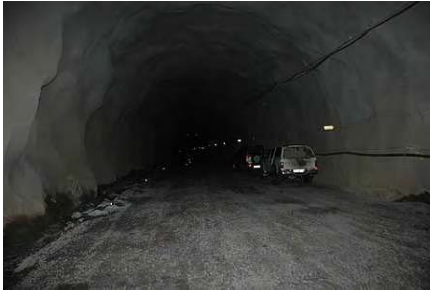
Mynd 34. Bolungarvíkurgöng / Óshlíðargöng, síðasta sprenging (G. Pétur Matthíasson).
