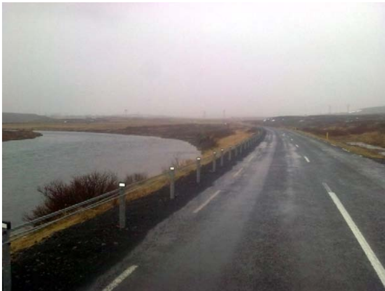
Mynd 52. Víravegrið við Sogið á Þingvallavegi (Gunnar Garðarsson).
