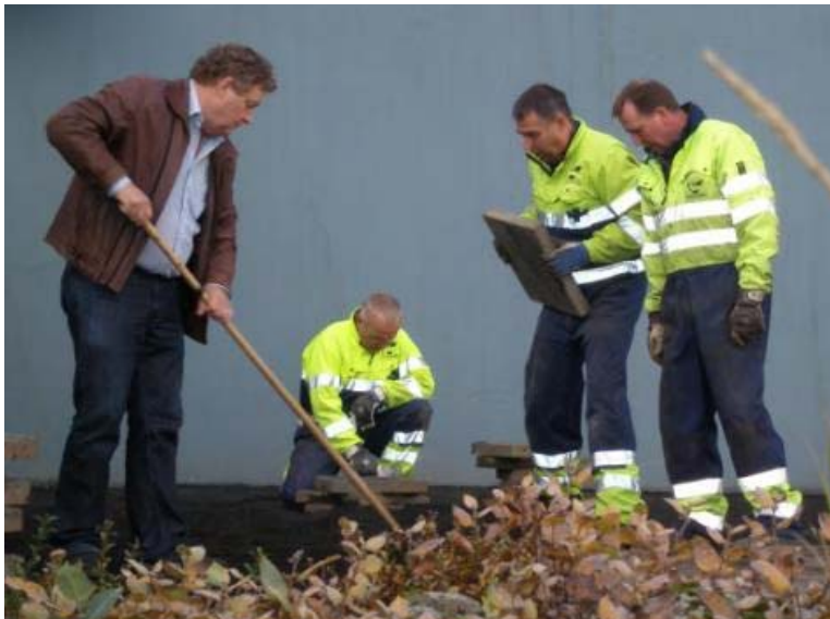
Mynd 58. Jafnað undir og hellur lagðar. Jón Magnússon, Sverrir Valgarðsson, Haraldur Sigurðsson og Skúli Halldórsson (Valgeir S. Kárason).
