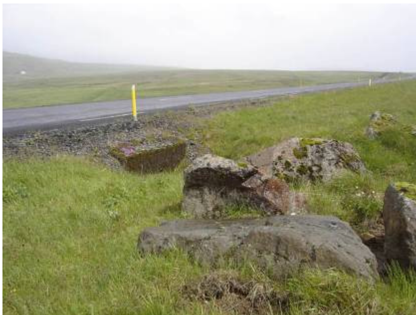
Mynd 12: Þingvallavegur: Við útafakstur lendir bíll á grjótinu. Einföld lausn er að fjarlægja steinana og auka halla fláa.
