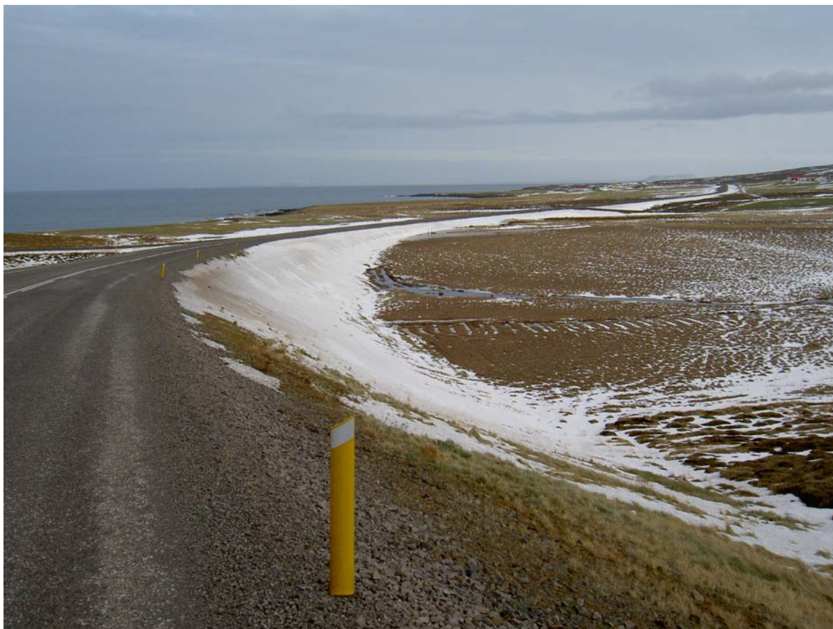
Mynd 21: Á Norðausturvegi á Tjörnesi. Dæmi um veg, sem liggur nokkuð yfir landi, til að forðast snjósöfnun.
