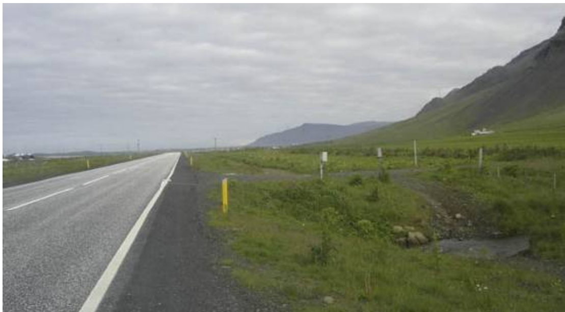
Mynd 17: Vesturlandsvegur undir Akrafjalli: Við útafakstur getur bíll lent í ákeyrslu á afleggjarann og oltið. Hér þarf að auka fláa afleggjarans.
