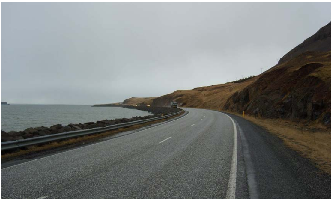
Mynd 19: Vesturlandsvegur í Kollafirði. Vegrið frá 1992 sem fullnægði kröfum sem þá voru gerðar. Þær uppfylla ekki kröfur Evrópusambandsins í dag þar sem það er bæði of lágt og of stíft.
