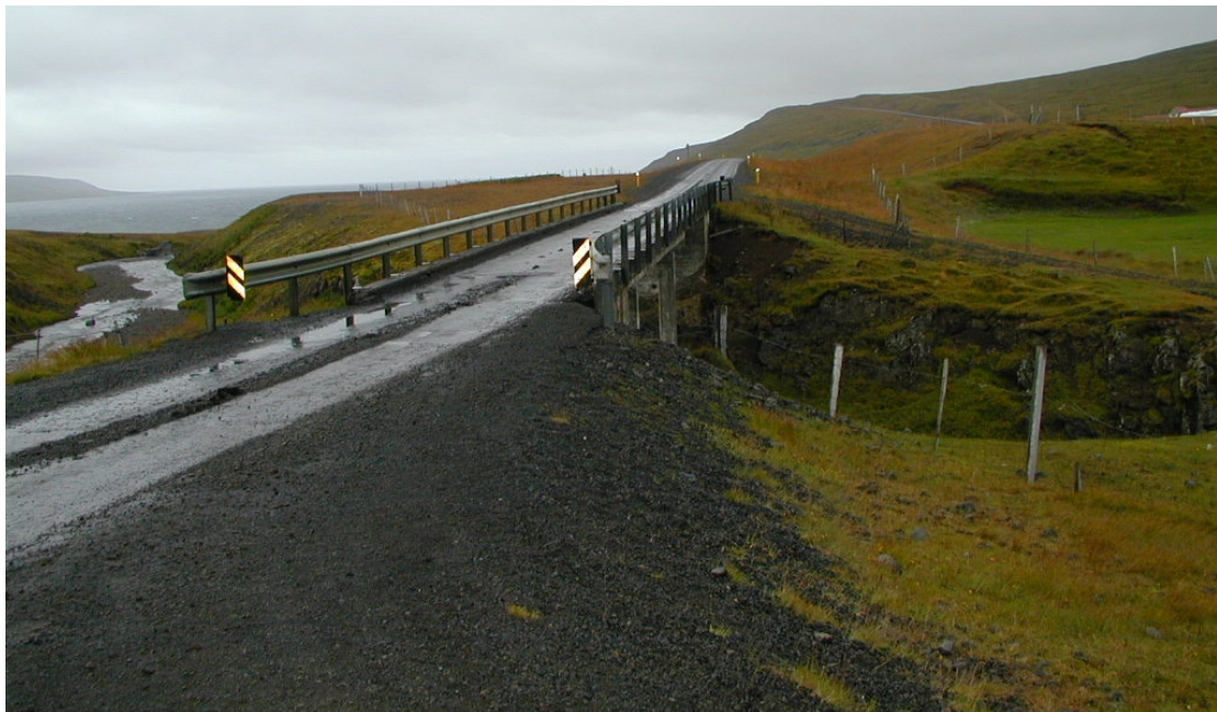
Mynd 16: Brú yfir Þambá í Bitrufirði.
