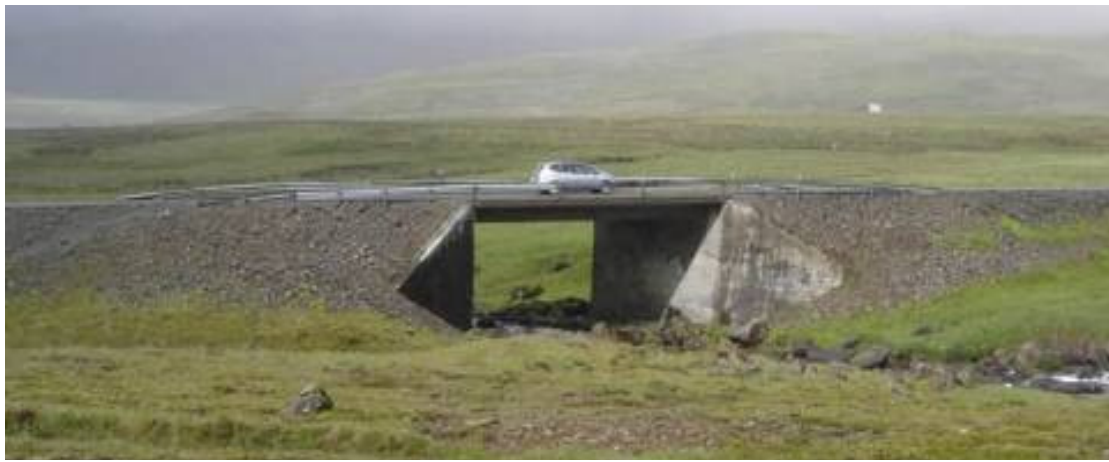
Mynd 15: Leirvogsa, Þingvallavegur: Dæmigerð mynd um vegrið á brú. Við útafakstur eru mikil líkindi á að bíll keyri útaf áður en að vegriði kemur, steypi stömpum niður vegfláann og lendi loks ofan í ánni. Hér þarf að lengja vegriðið.
