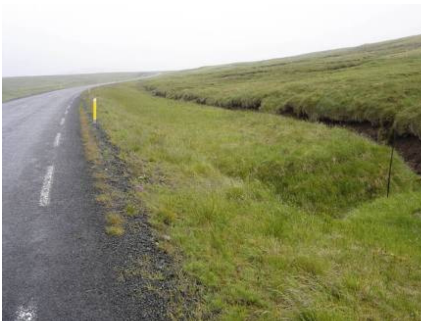
Mynd 14: Þingvallavegur: Við útafakstur getur bíll lent í ræsisskurði eða í vegskurði. Best er að endurgera vegsvæðið, lengja ræsi og moka ofan í skurðinn.
