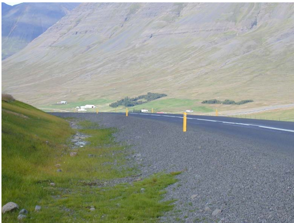
Mynd 7: Hringvegur við Þelamörk, Hörgárdal. Nokkuð aflíðandi fláar og sæmilega hreint vegsvæði. Dæmi um öryggisflokk A.
