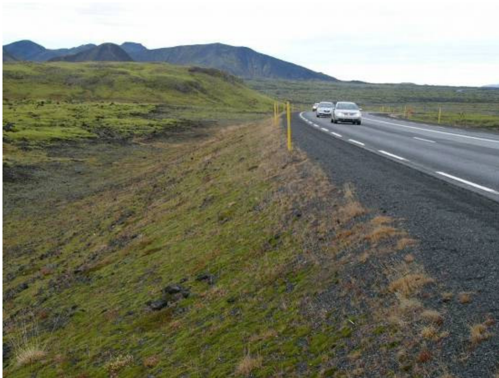
Mynd 6: Suðurlandsvegur. Hæð vegar yfir landi er víða töluverð. Vegrið vantar yfirleitt. Velta má fyrir sér, hvort þörf sé á svo mikilli veghæð til að taka tillit til snjóalaga.
