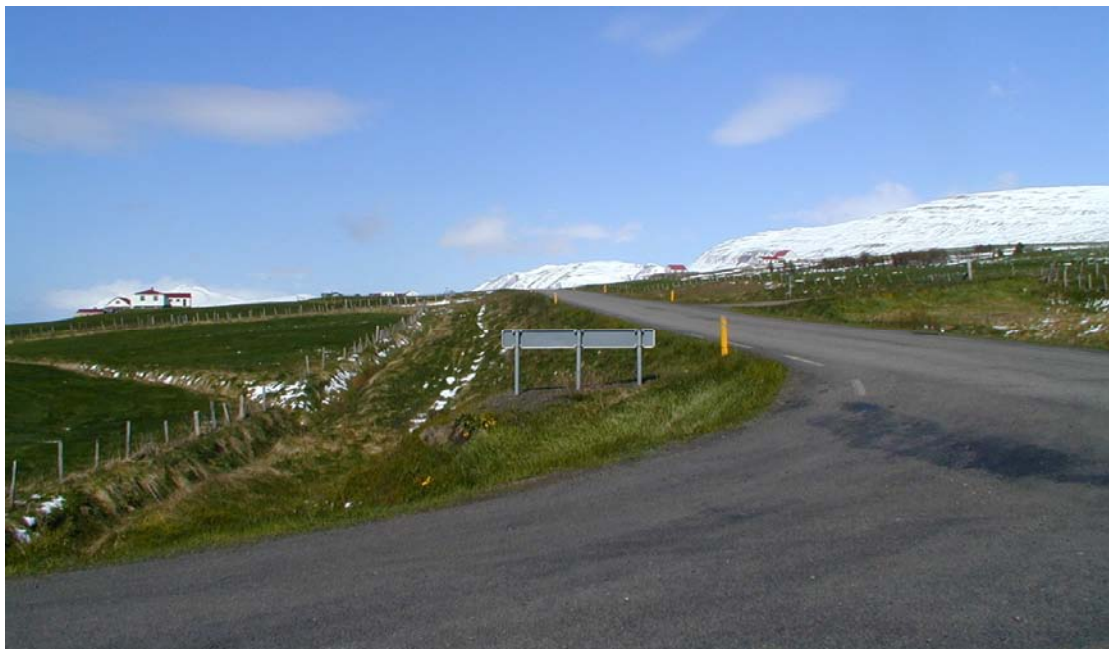
Mynd 18: Afleggjarinn að Svalbarðseyri. Í umhverfi þessara gatnamóta eru margar hættur. Hérna er fláinn of brattur, stór malarpúði er undir skiltinu og skurður liggur nálægt veginum.
