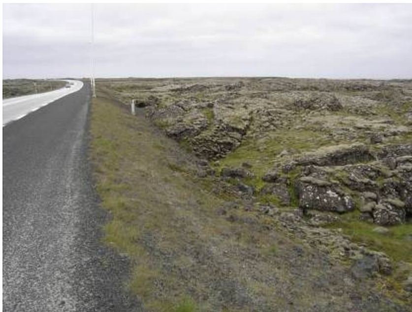
Mynd 11: Reykjanesbraut: Við útafakstur lendir bíll á hraunkletti og líkindi er á árekstri við hann. Vegrið er lausn og einnig er möguleiki á að auka fláa og jafna land út frá veginum. Dæmi um öryggisflokk C.
