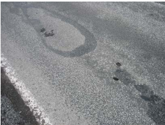
Mynd 3 Ytra hjólfarið sjávarmegin. Mynd 4 Nærmynd af skemmd.
