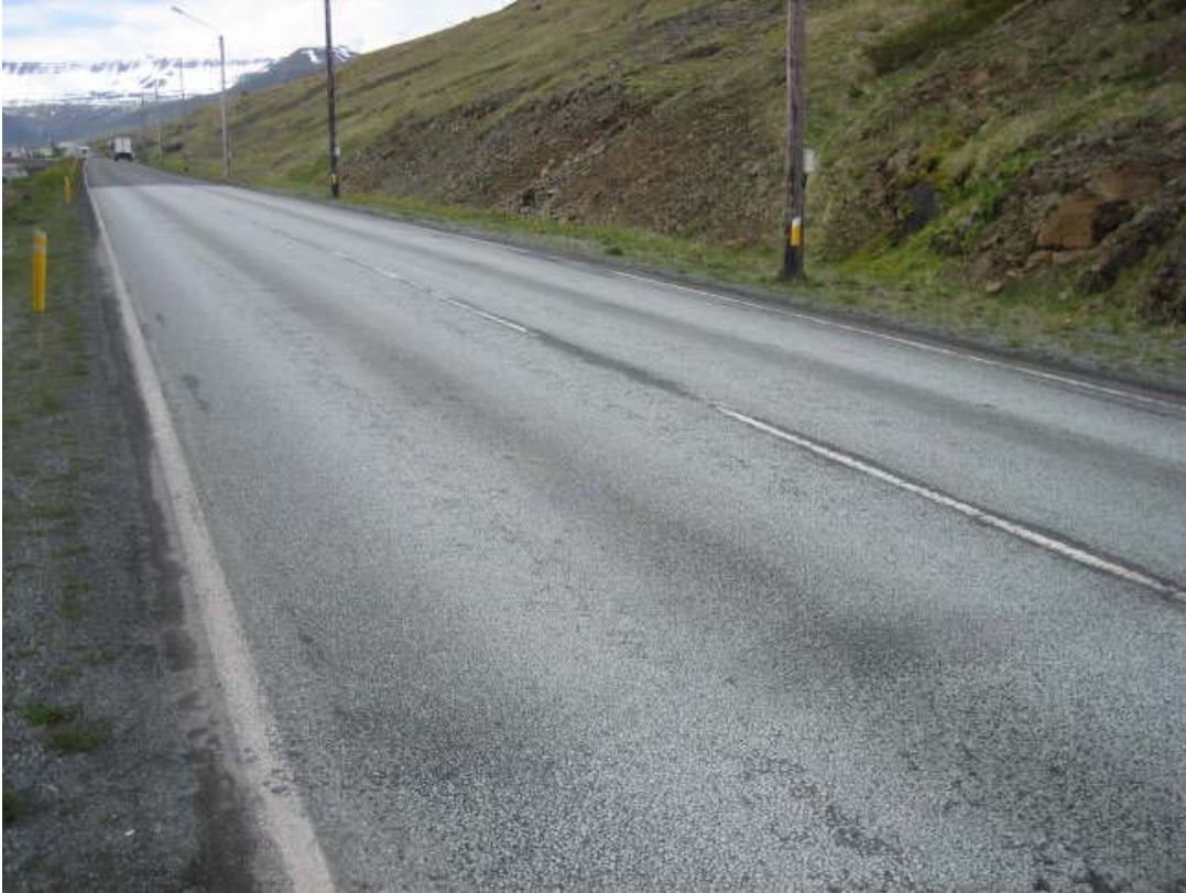
Mynd 14 Yfirlitsmynd af kafla 5 Durasplitt 8/11 mm í júní 2007.
