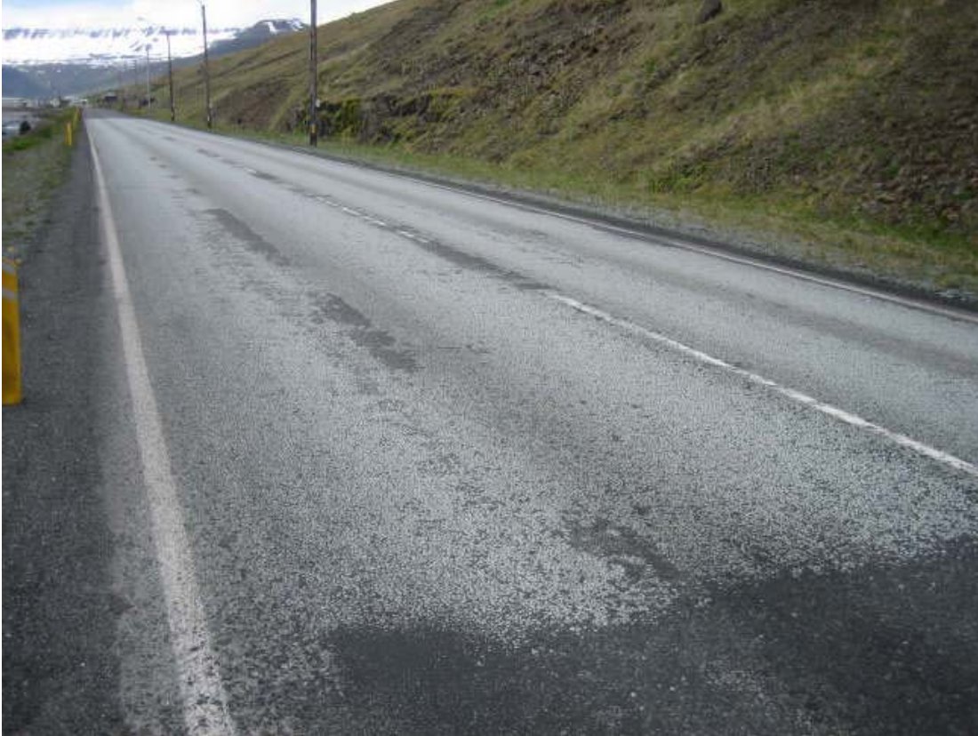
Mynd 11 Yfirlitsmynd af kafla 4 Durasplitt 11/16 mm í júní 2007.
