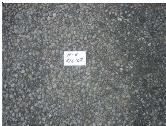
Mynd 19 Nærmynd af slitlaginu á miðhrygg sýnir að steinefnið er heillegt.
