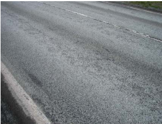
Mynd 15 Slitlagið er nokkuð heillegt, en grisjar í gegn í hjólförum.
