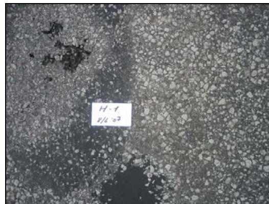
Mynd 3 Ytra hjólfarið sjávarmegin. Mynd 4 Nærmynd af skemmd.
