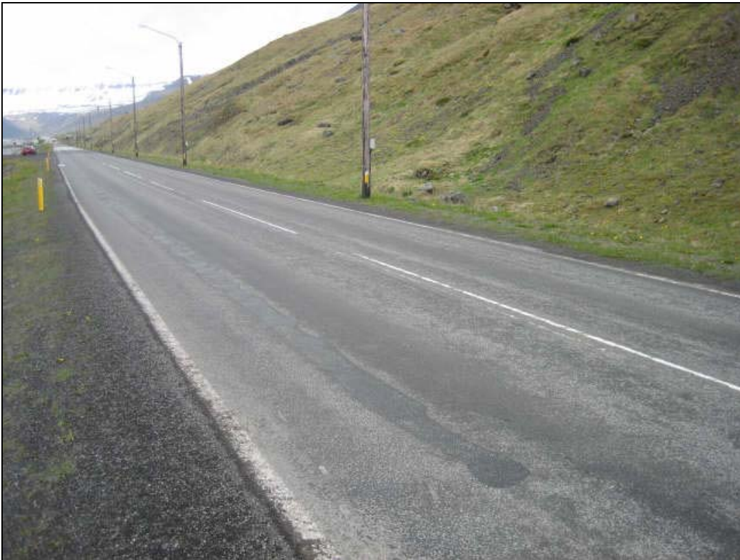
Mynd 2 Yfirlitsmynd af kafla 1 Austmannsfalli 11/16 mm í júní 2007.
