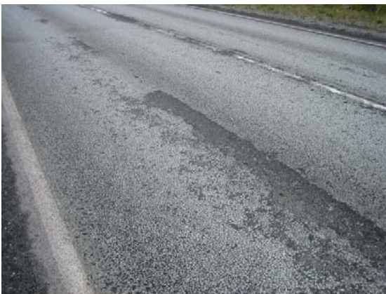
Mynd 11 Yfirlitsmynd af kafla 4 Durasplitt 11/16 mm í júní 2007.
