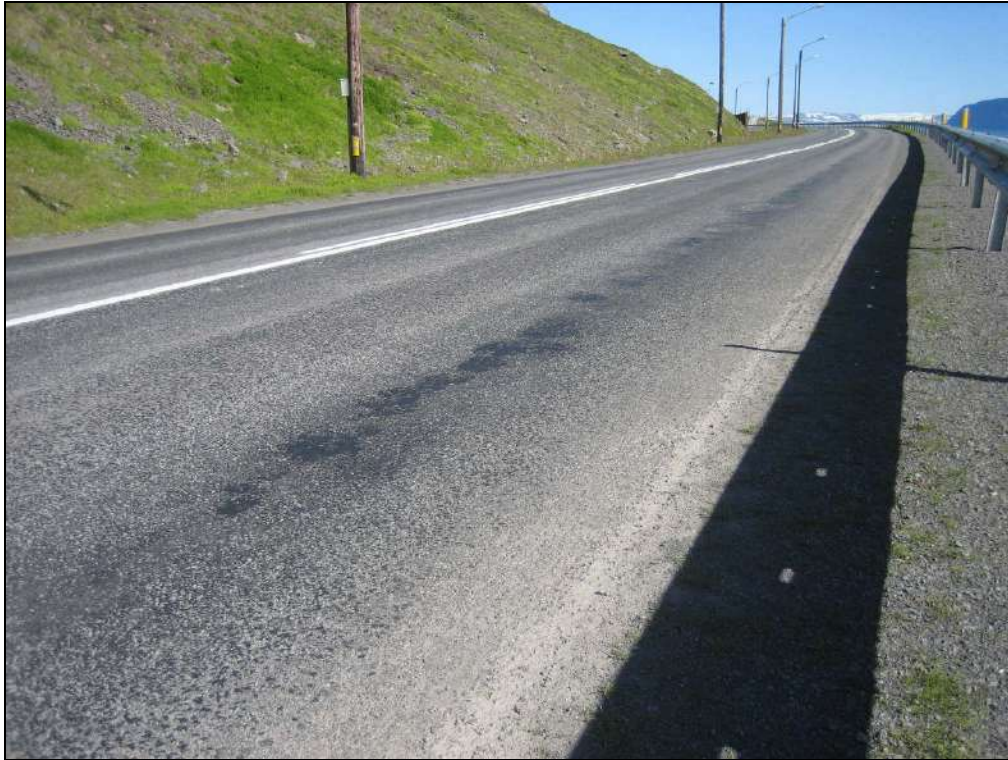
Mynd 5 Viðgerðir eða feitir blettir á yfirlögn á tilraunakafla á Hnífsdalsvegi 23/6 2008.
