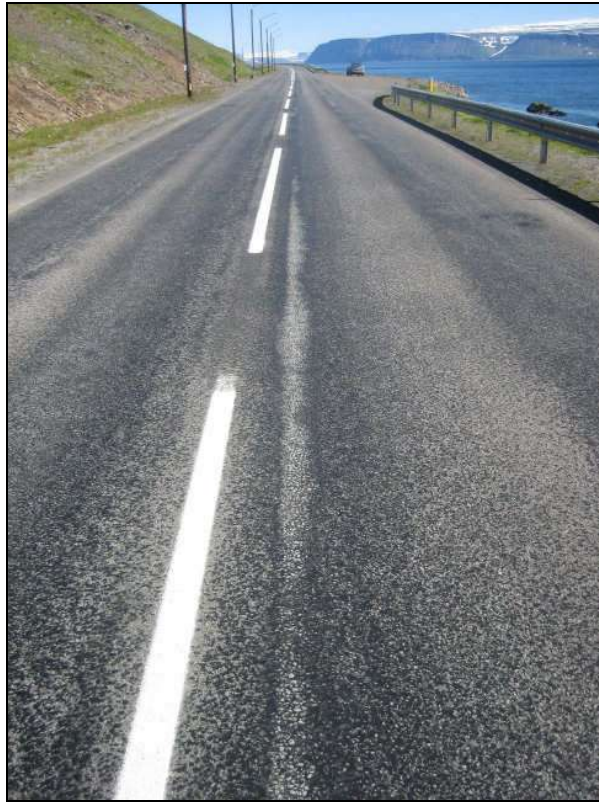
Mynd 2 Slitið í gegn eða sár eftir plóg á tilraunakafla á Hnífsdalsvegi 23/6 2008.
