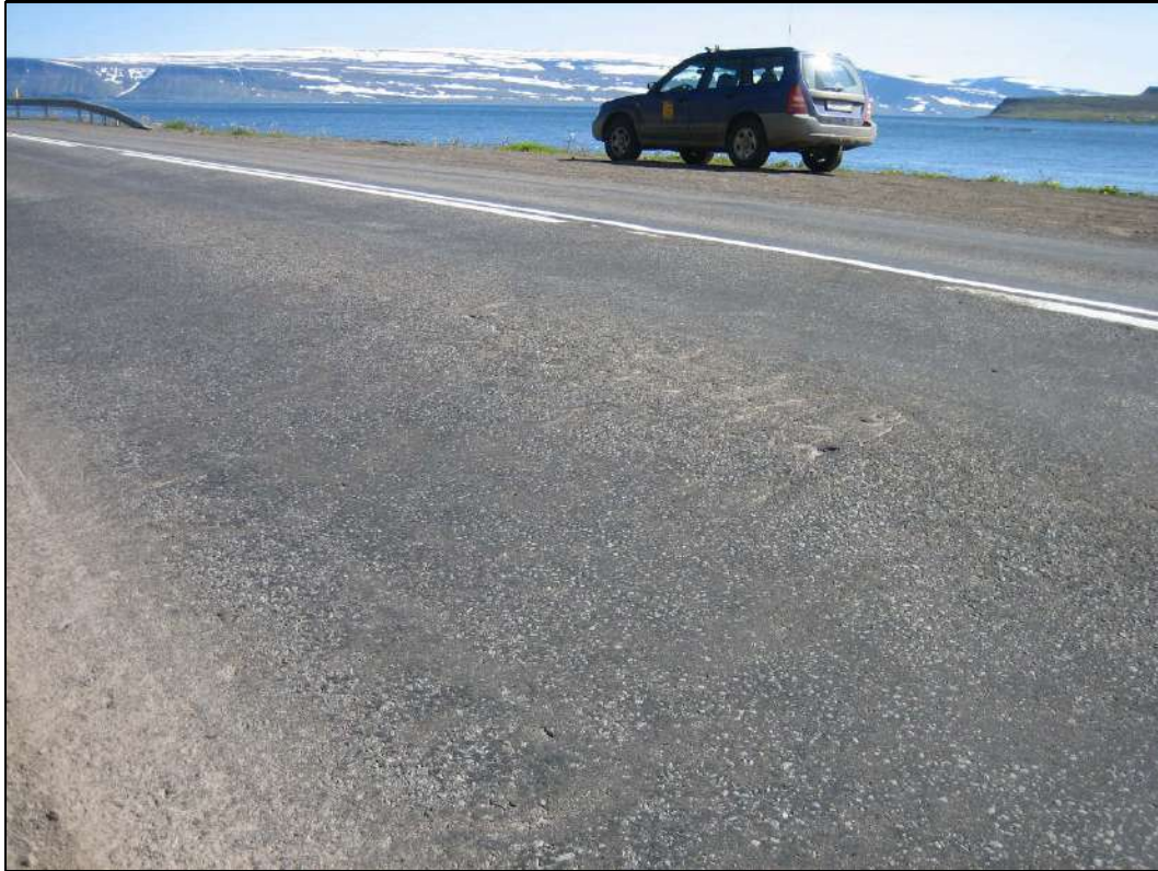
Mynd 1 Plógför á yfirlögn á tilraunakafla á Hnífsdalsvegi 23/6 2008.
