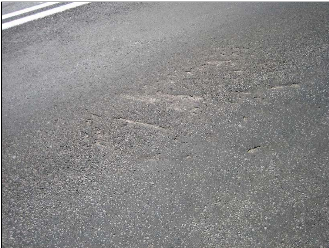
Mynd 2 Plógför séð nær á tilraunakafla á Hnífsdalsvegi 23/6 2008.
