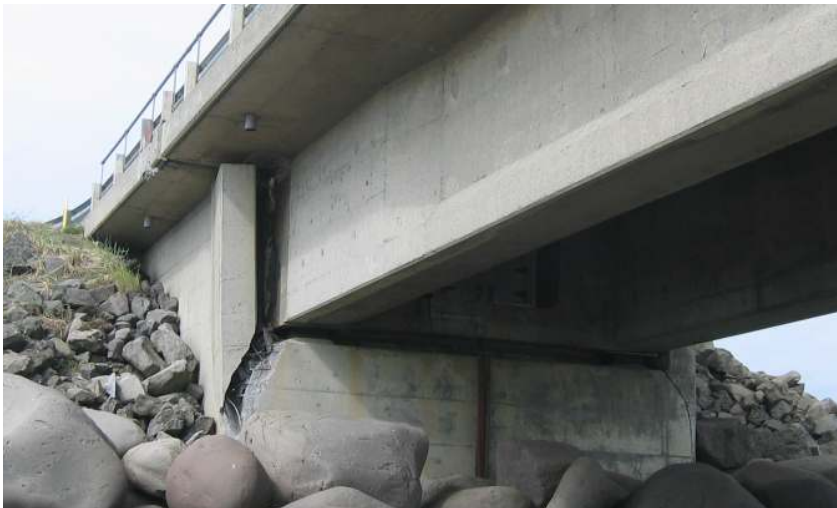
Mynd 2.5 Skemmdir á vestari landstöpli.
