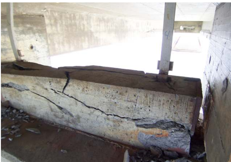
Mynd 2.8 hliðarstoppari á miðstöpli (Vegagerðin).
