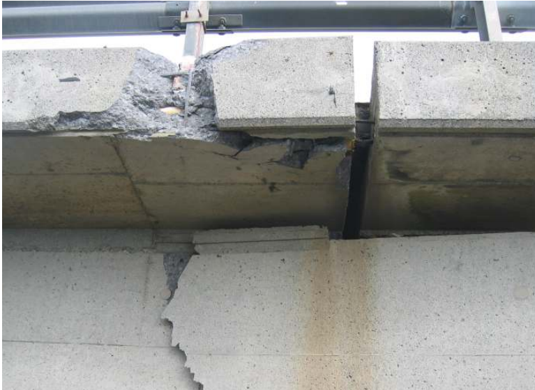
Mynd 2.9 Samskeyti vestari landstöpuls og brúardekks.
