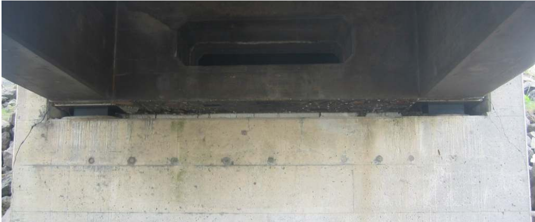
Mynd 2.6 Skemmdir á eystri landstöpli. Á myndinni sjást einnig viðnámslegurnar ágætlega en stálplöturnar renna á gúmmínu sem er teflonhúðað að ofan.
