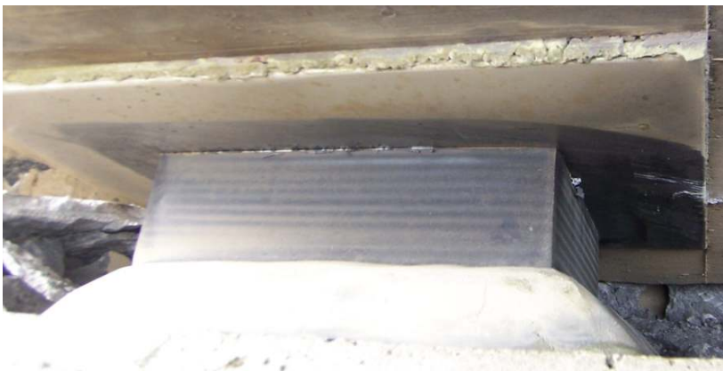
Mynd 2.10 Viðnámslega á vestari landstöpli. Sjá má svartan lit á stálplötu sem ætla má að sé tilkominn vegna mismunahreyfingar á núningsfleti legunnar (Vegagerðin).
