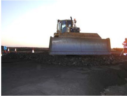
Mynd 4. Lagning lags 0-130 mm
