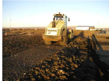
Mynd 5. Fyrsta umferð völtuð á lagi 0-130 mm
