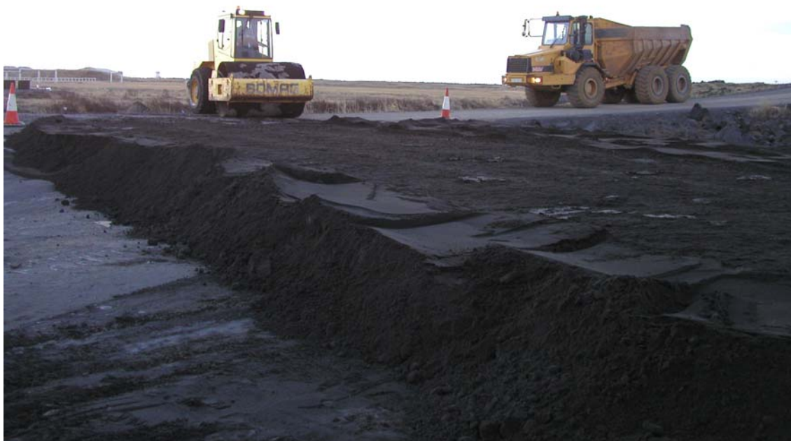
Mynd 3. Fylling eftir völtun
