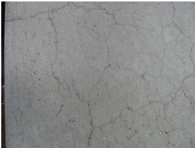
Mynd 25: Bygging A, mynd nr. 2, mynd ELÁ
