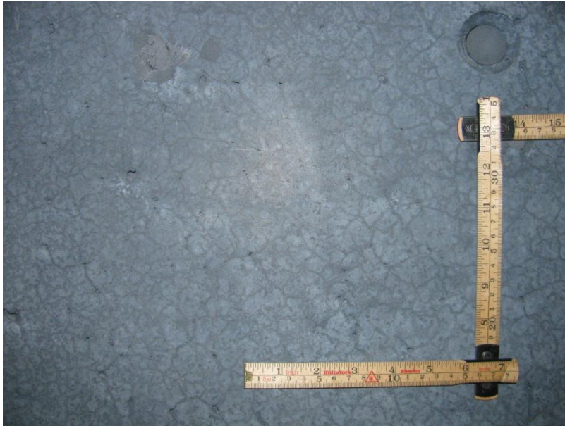
Mynd 24: Bygging A, mynd nr. 1, mynd ELÁ
