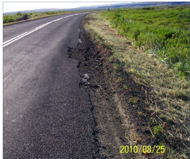
Mynd 13 Slæmt ástand á klæðingu - þarfnast endurbóta
