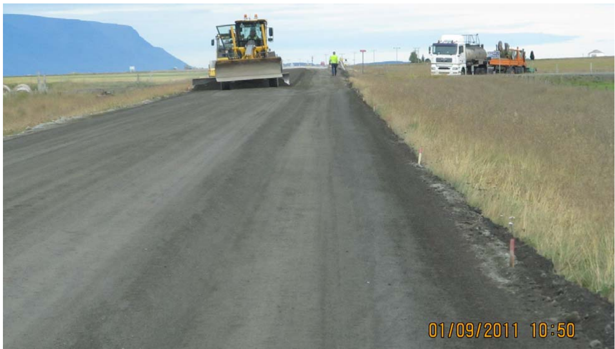
Mynd 20 Hringvegur (1) kafli m8, í Blönduhlíð Skagafirði, unnið að styrkingu vegarins, 2,64 km, með sementsfestun. Verktaki Borgarverk ehf. Hryfimælingar gerðar IRI-gildi hægra hjólfars 2,33 mm/m, sjá mynd 18 til samanburðar við aðra styrkingarkafla.
