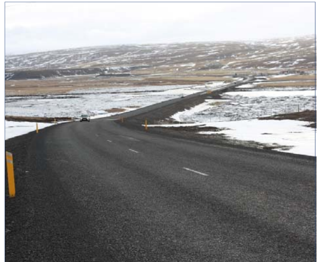
Mynd 7 Hringvegur í Hrótafjarði, nýbygging 2008, mynd mars 2009.
