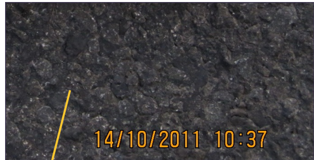
Mynd 25 Suðurstrandarvegur (427) nýbygging sem lokið við haustið 2011. Verktaki Suðurverk ehf. IRI = 3,41 (3, 21) mm/m, gróft yfirborð og sem forvitnilegt verður að vita hvernig hryfið þróast.
