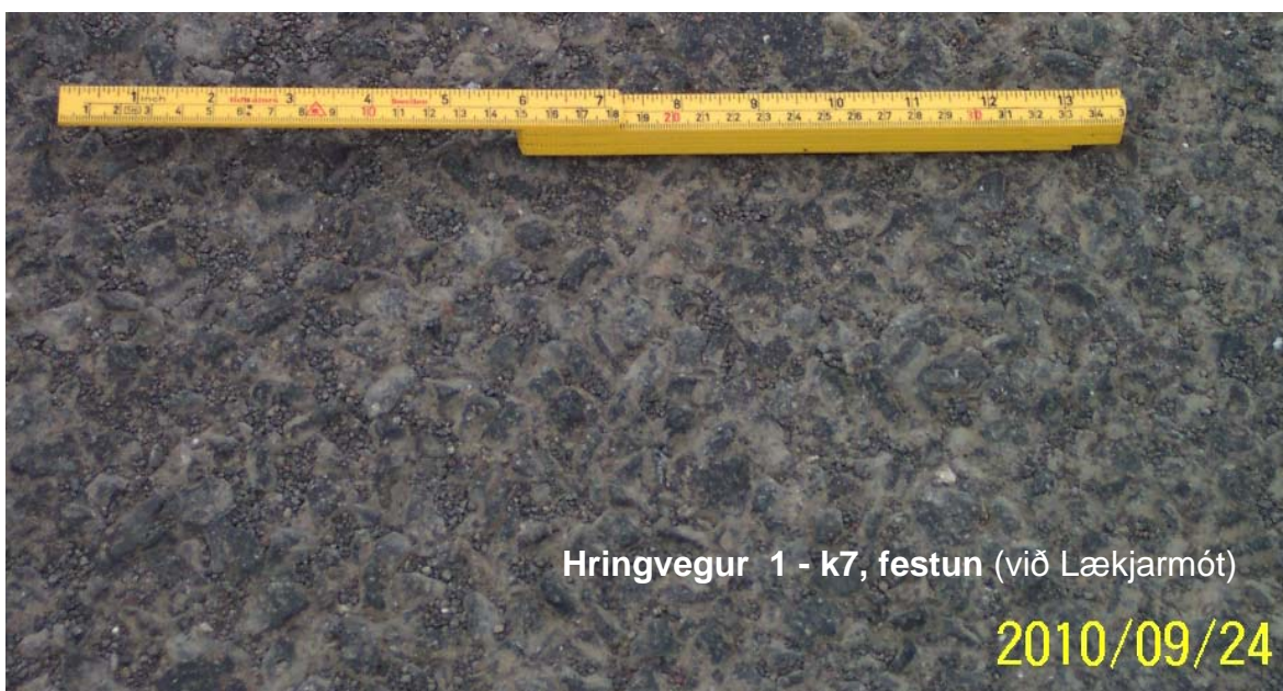
Mynd 2 - 4 Þrjú mismunandi klæðingaryfirborð, þriggja nýbygginga- og styrkingarkafla, 2010 og 2011
