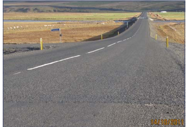
Mynd 11 Hringvegur í Vatnsdal, styrking / endurbuygging / breikkun, 2010 - 2011 Verktaki, Fjörður ehf
