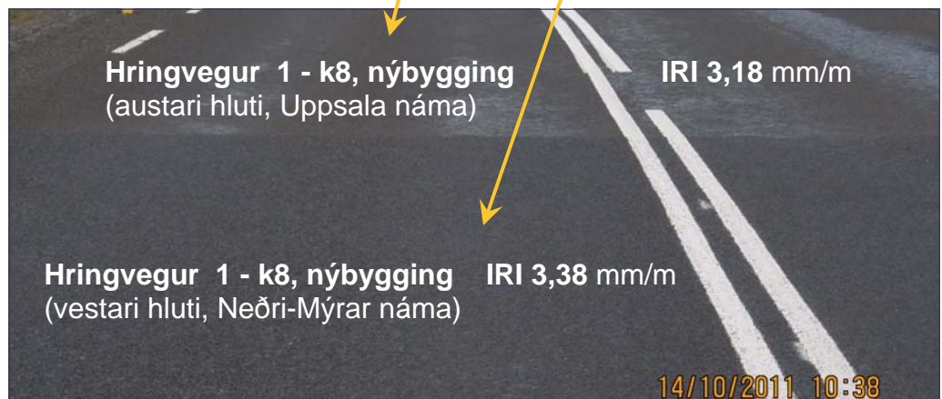
Mynd 27 - 29 Hringvegur 1-k8 í Vatnsdal nýbygging / styrking / breikkun, sem lokið var við 2011. Ósléttur vegur, sem áhugavert verður að fylgjast með.
