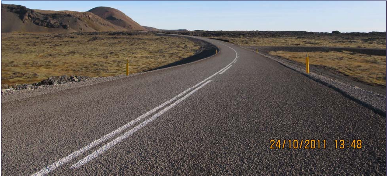
Mynd 25 Suðurstrandarvegur (427) nýbygging sem lokið við haustið 2011. Verktaki Suðurverk ehf. IRI = 3,41 (3, 21) mm/m, gróft yfirborð og sem forvitnilegt verður að vita hvernig hryfið þróast.
