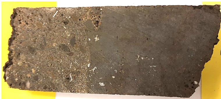
Mynd 7: Kjarnasýni fyrir þunnsneiðargerð. Yfirborð sprautusteypu er vinstra megin og hægra megin má sjá undirliggjandi berg (basalt).
