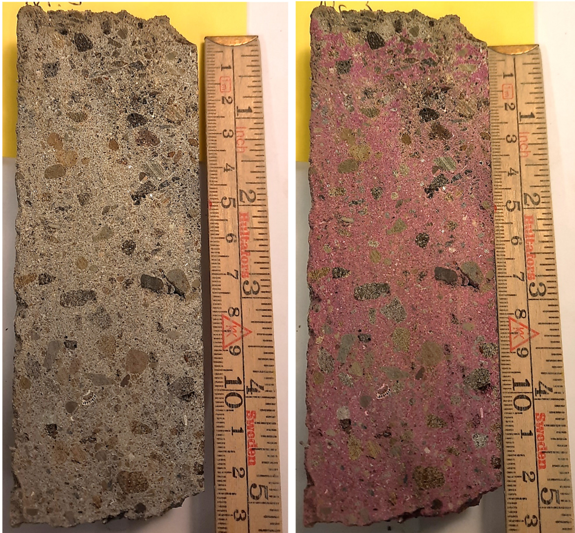
Mynd 4: Dæmi um vinnslu sýna fyrir mælingu á kolsýringu á sýni úr stöð 4898 í Hvalfjarðargöngum, sýni nr.3. Til vinstri er búið að saga kjarnasýnið eftir endilöngu og til hægri þá er búið að úða lausn á sýnið, ólitaða yfirborðið er kolsýrt (næst yfirborði sprautusteypunnar).
