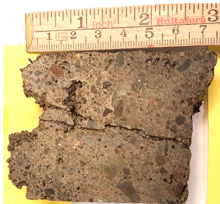
Mynd 16: Kjarnasýni fyrir þunnsneiðargerð. Yfirborð sprautusteypu er vinstra megin.
