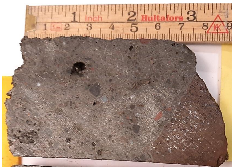
Mynd 40: Kjarnasýni fyrir þunnsneiðargerð. Yfirborð sprautusteypu er vinstra megin og hægra megin má sjá undirliggjandi berg (kargi). Eitt lag af sprautusteypu án trefja.
