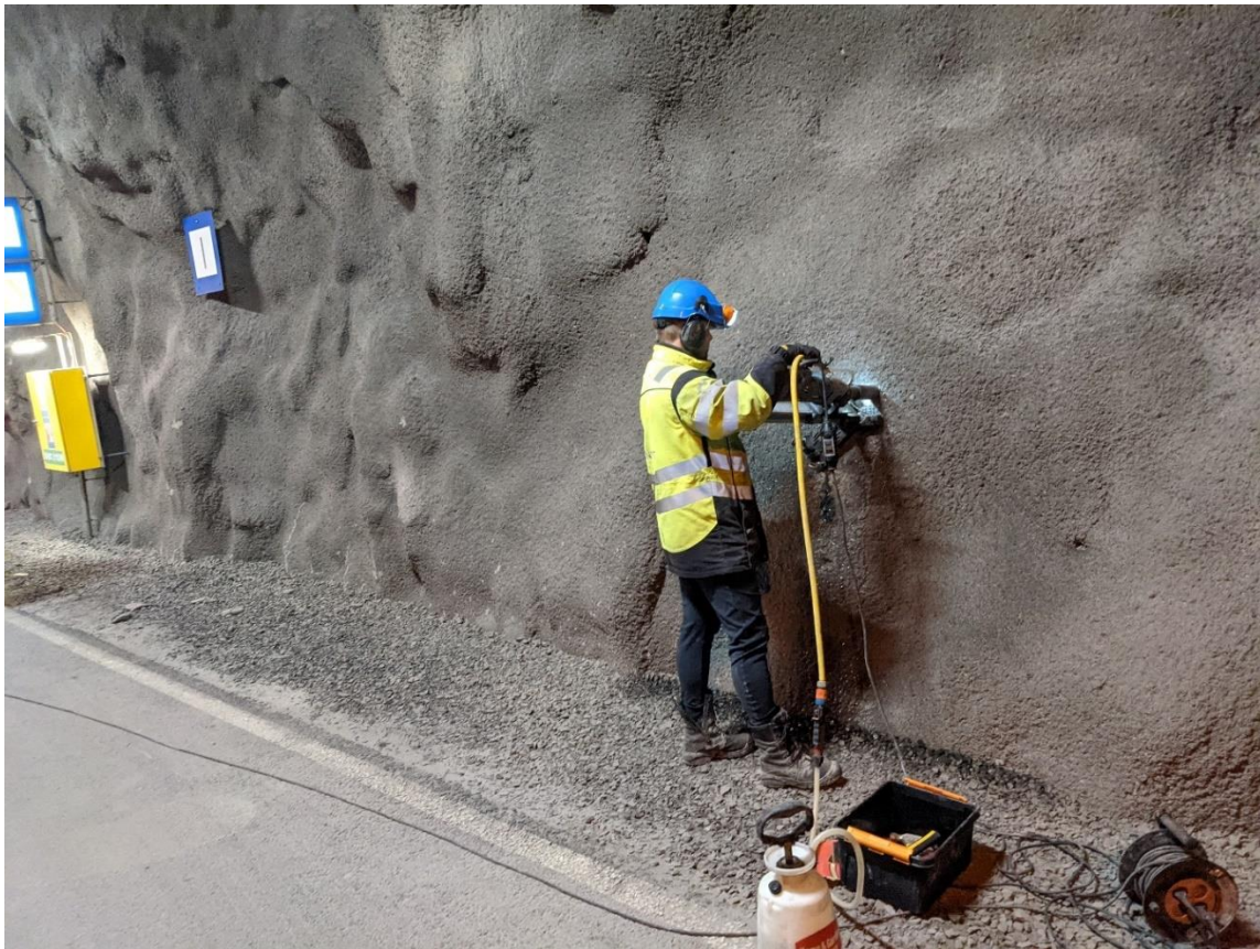
Mynd 1: Unnið við sýnatöku í stöð 8150 (útskot I) í Fáskrúðsfjarðargöngum.
