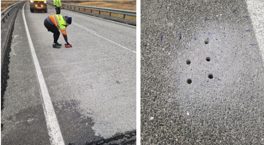
MYND 19 Sanddalsá, járnaskann og sýnataka úr steypu.
