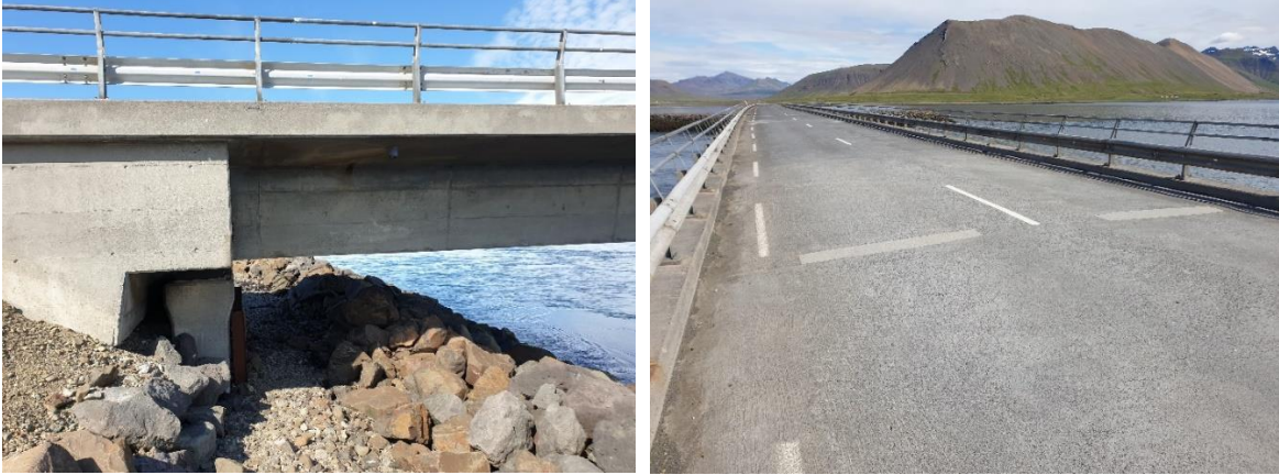
MYND 11 Vestari endi brúar þar sem borað var í bitahliðar. Einnig var borað í ljósu flekkina yfir vestasta millistöpli.
