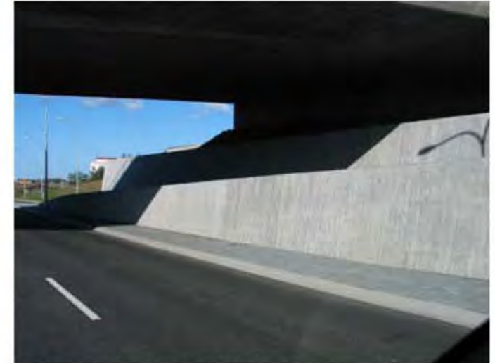
Mislæg gatnamót við Bústaðaveg
