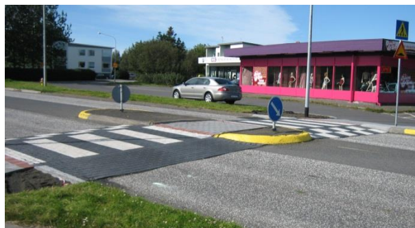
Mynd 14 Gangbraut á upphækkun með miðeyju. Hér væri einnig æskilegt að hafa gangbrautarskilti í miðeyju.
