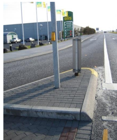
Mynd 4 Hnappur við umferðarljós staðsettur þannig að hann er ekki aðgengilegur öllum.
