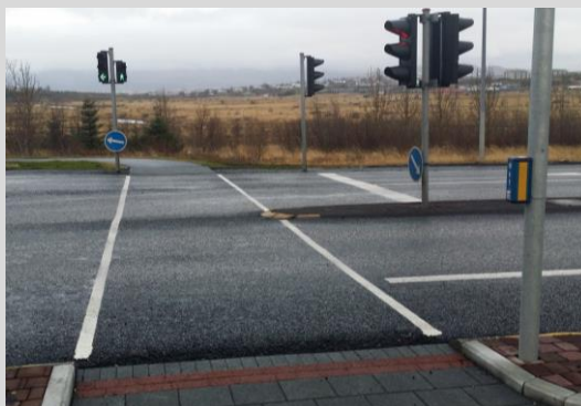
Mynd 25 Gönguþverun með umferðarljósum. Hnappur við umferðarljós er staðsettur þannig að hann er aðgengilegur öllum.
