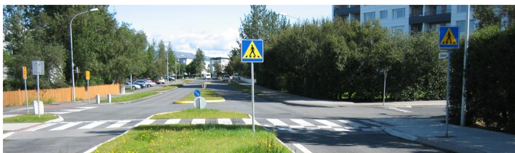
Mynd 16 Gangbraut á upphækkun. Miðeyja skilur að umferð eftir áttum.
