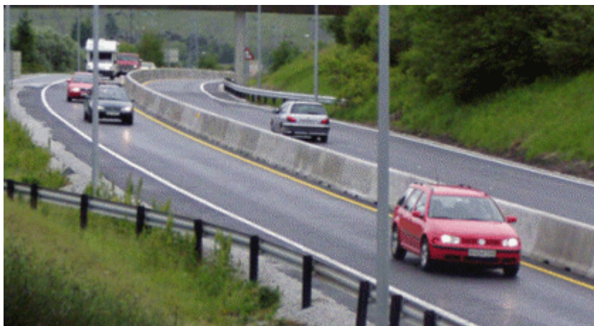
Mynd 7.4. Heill steyptur miðdeilir [Heimdal Granitt & Betongvarer 2006].
