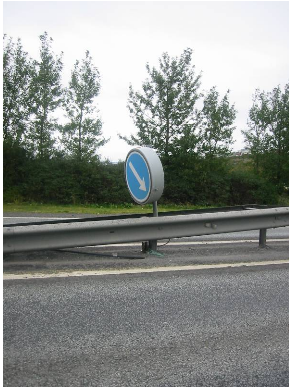
Mynd 7.3. Hefðbundið vegrið með árekstrarvörn beggja vegna.
