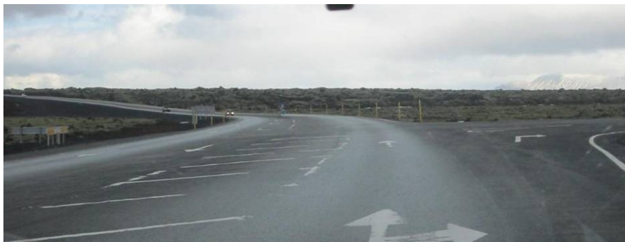
Mynd 3.3. Hamragilsvegamót á Suðurlandsvegi. Vegurinn er breiður og merkingar hafa máðst af yfir veturinn. Ökumenn kvarta yfir óöryggi við akstur um vegamótin.
