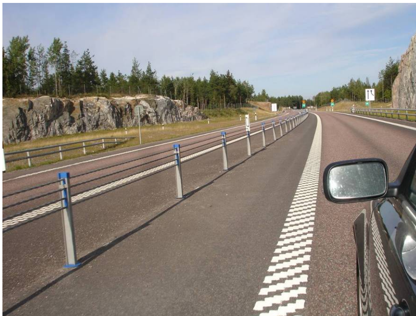
Mynd 7.1. Upphleyptar vegmerkingar við víravegrið (mynd tekin í september 2006 í Svíþjóð).
