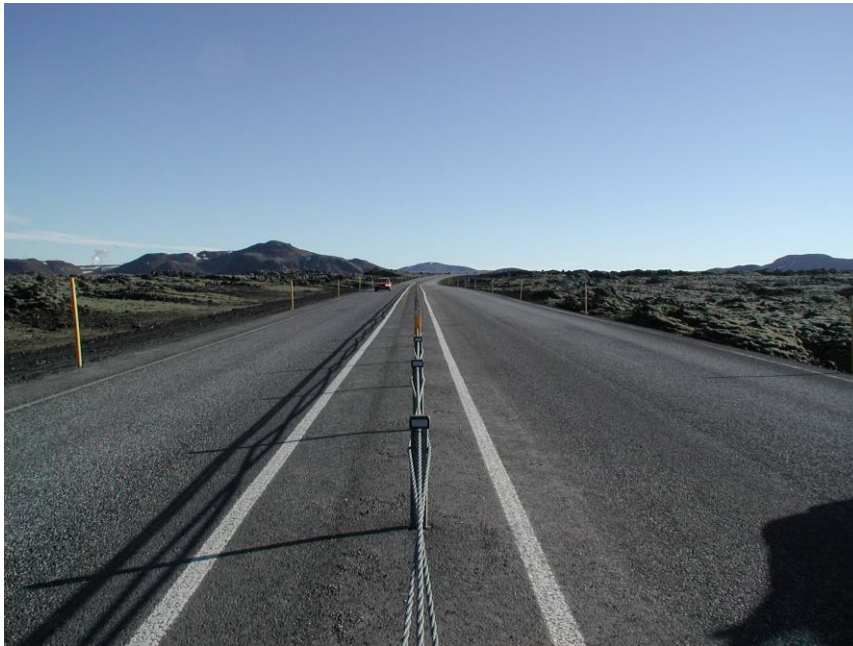
Mynd 7.2. Víravegrið með fjórum vírum, tveir neðstu vírarnir fléttast (mynd tekin veturinn 2006).
