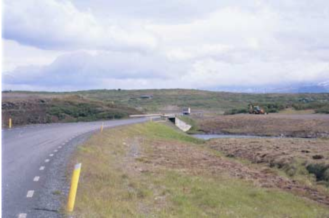
Mynd 25. Ólafsvíkurvegur, brú yfir Langá á Mýrum.
