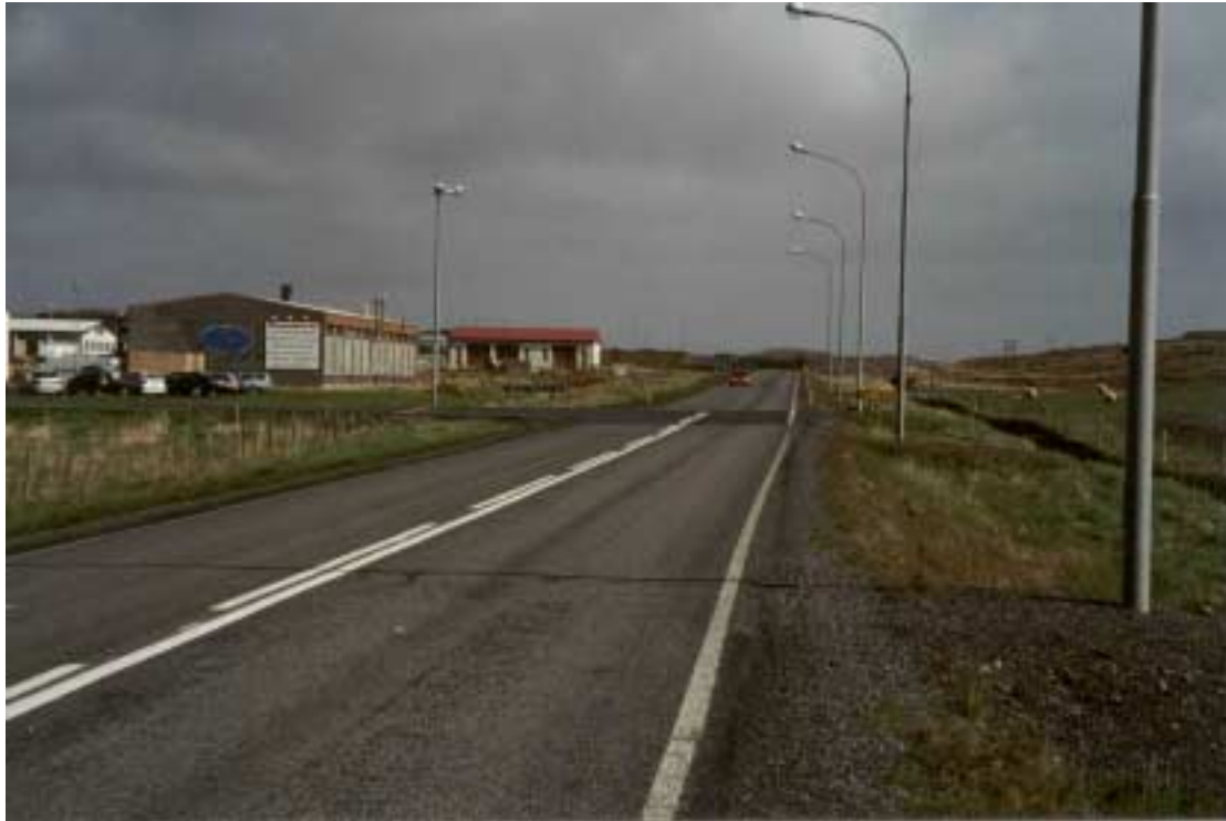
Mynd 26. Vegamót Vesturlandsvegur og Ólafsvíkurvegar, horft til norðurs.
