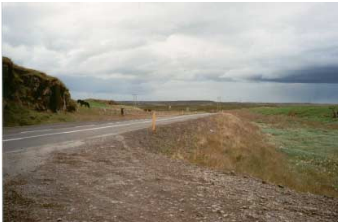
Mynd 14. Vesturlandsvegur við afleggjara að Svignaskarði, horft frá afleggjar til suðurs.
