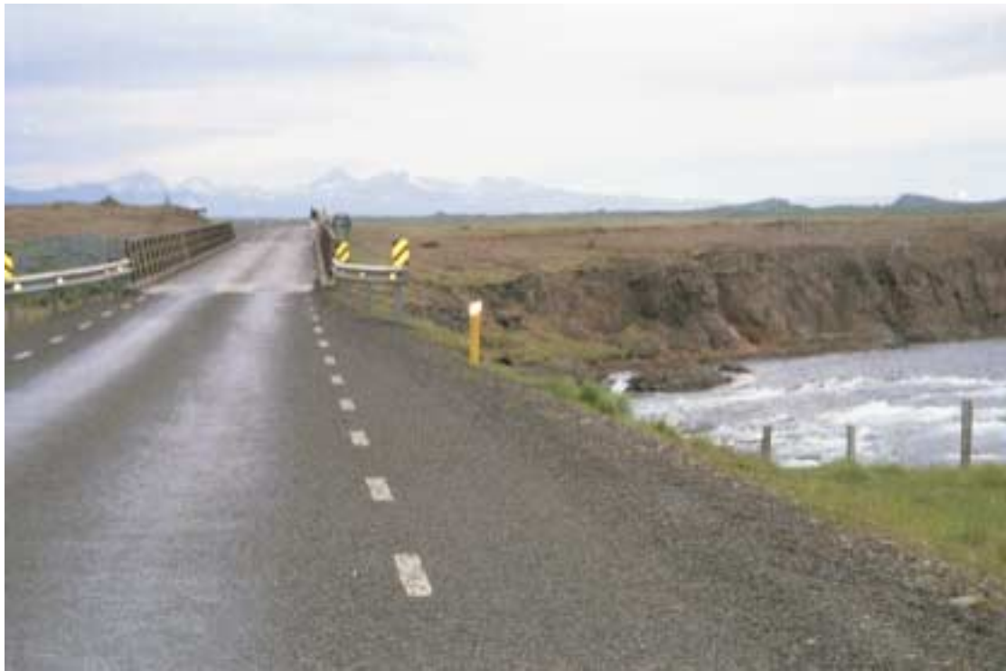
Mynd 2. Of stutt vegrið. Ólafsvíkurvegur, brú yfir Hítará.
