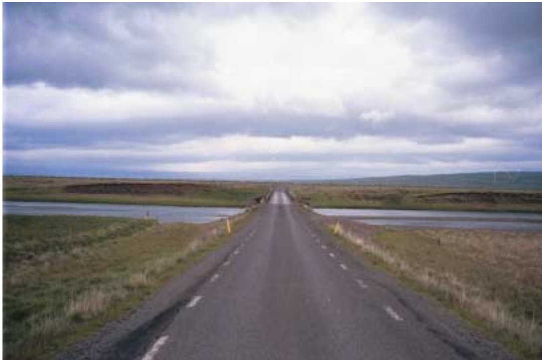
Mynd 22. Vestfjarðarvegur, sunnan við brú yfir Miðá í Miðdölum.
