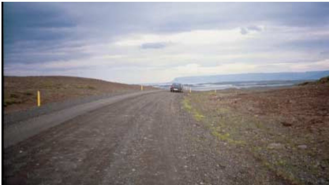
Mynd 30. Snæfellsnesvegur við Straumfell, horft til austurs.
