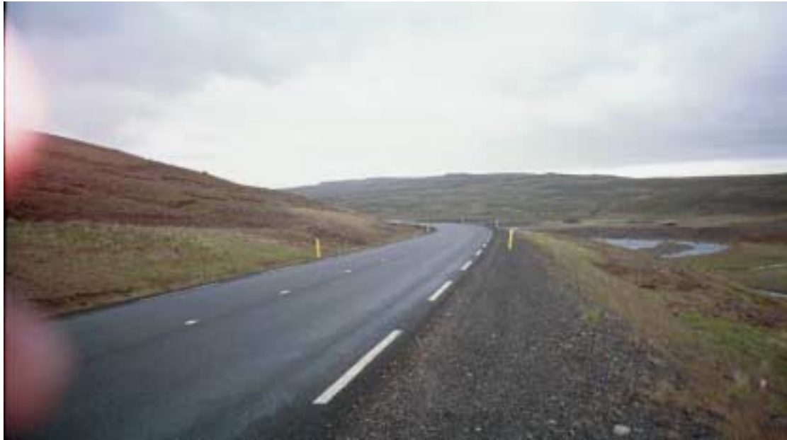
Mynd 19. Vesturlandsvegur við Sveinatungu – horft til norðurs.
