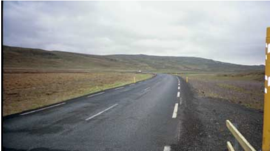
Mynd 20. Vesturlandsvegur í Norðurárdal, við Fornahvamm.
