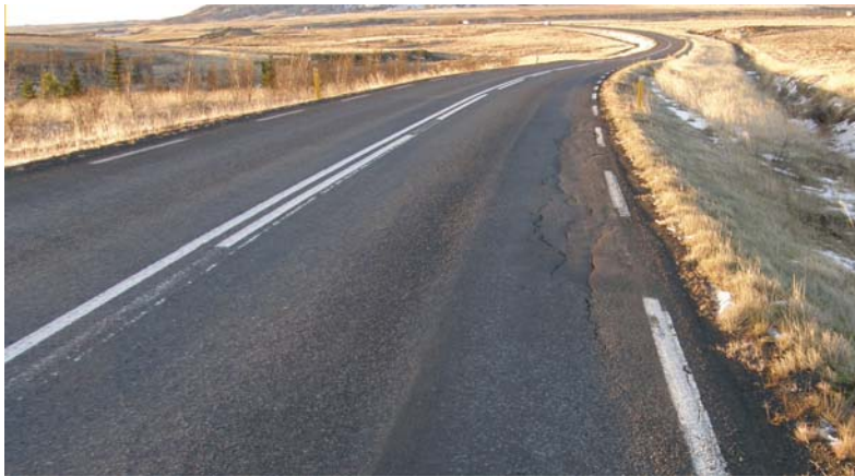
Mynd 5, álagið verður mest í innbeygjum og axlir þurfa að veita góðan hliðarstuðning.
