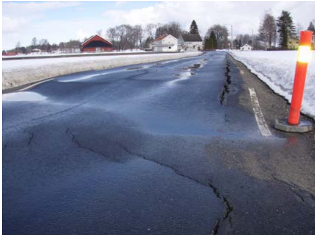
Mynd 4, Ástand vegar getur sagt mikið um undirbygginguna.
