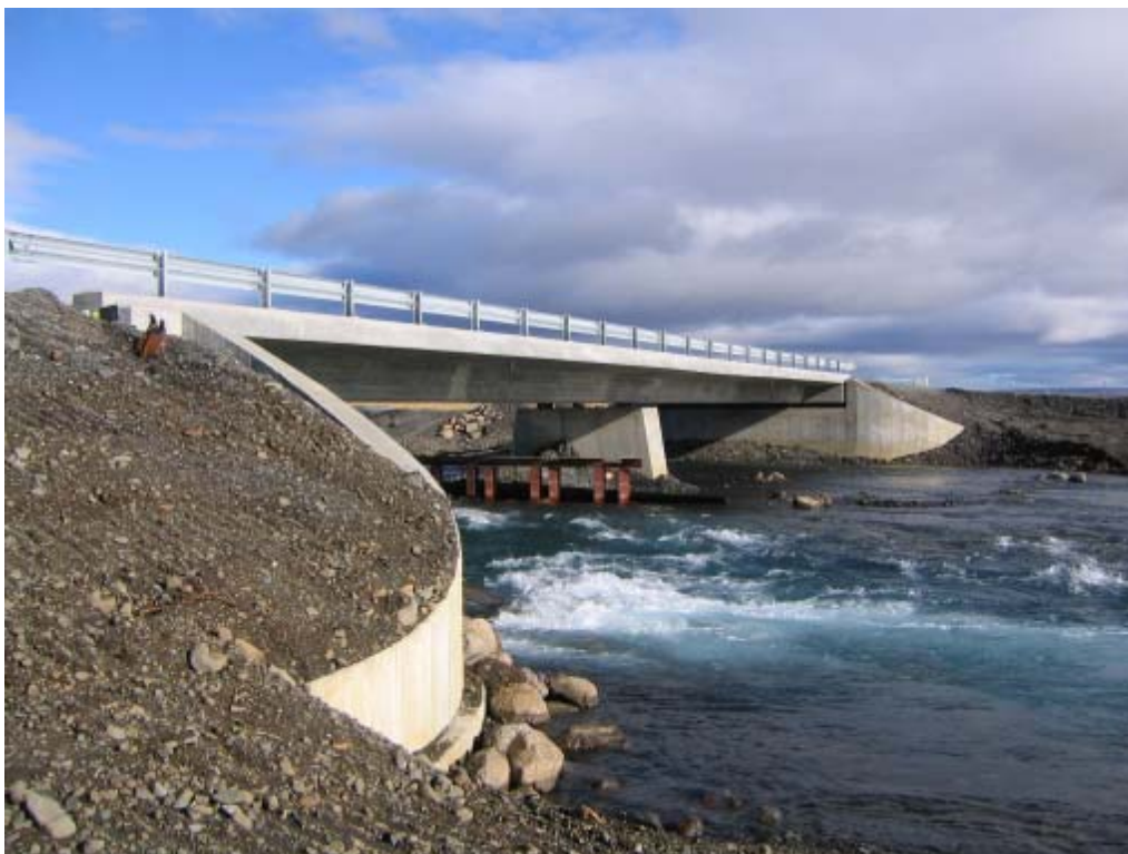
Mynd 3.3 Landstöplar og millistöpull brúarinnar á Brúará hjá Efri-Reykjum haustið 2004.
